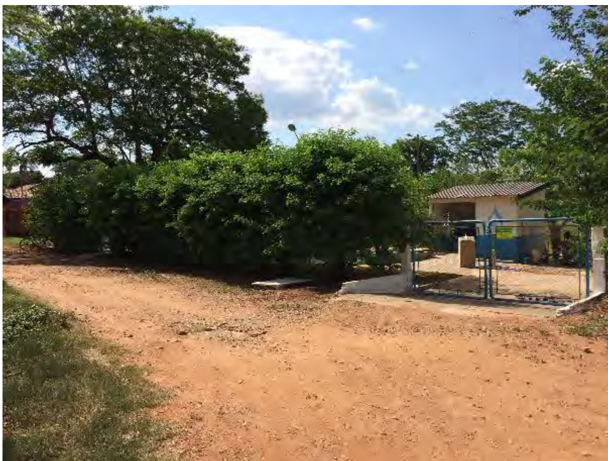
Figura 13: Vista da Estação de Tratamento de Esgoto de Nioaque.
