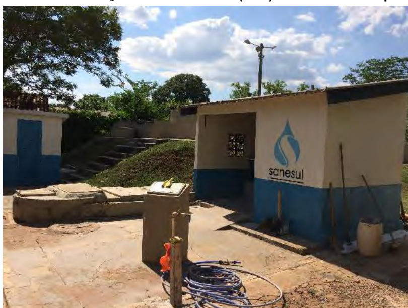
Figura 6: Vista da ETE - Final da ETE de Nioaque, ao fundo abrigo do QDC e a direita casa de aplicação de solução de cal.
