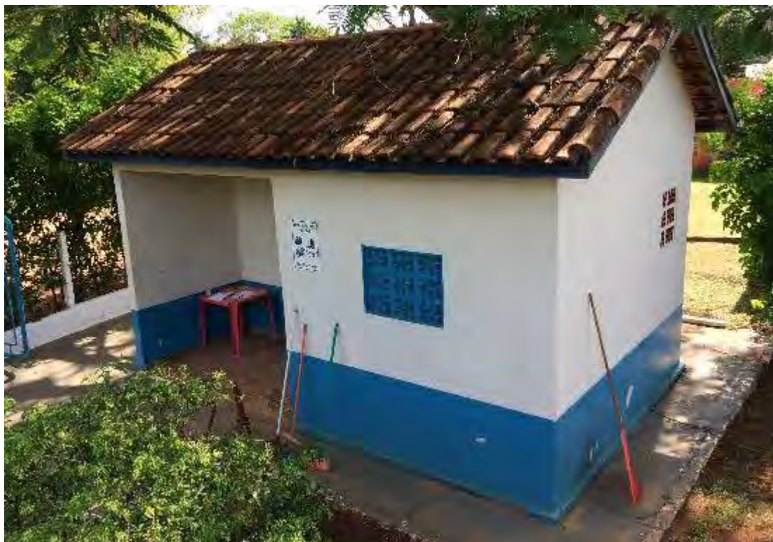
Figura 18: Vista do prédio do laboratório da ETE Nioaque.
