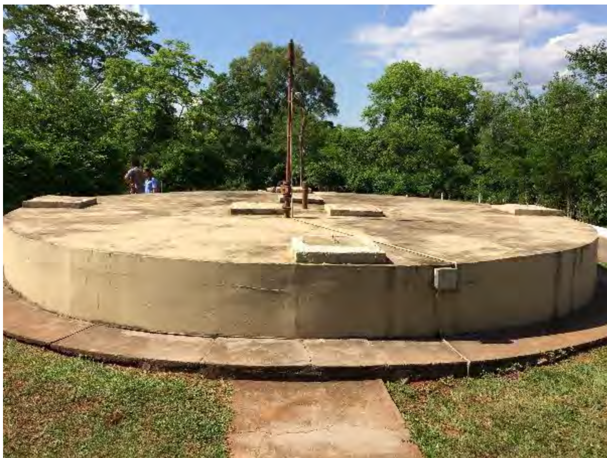
Figura 16: Vista do Reator Anaeróbio de Leito Fluidizado (RALF) - capacidade de 5L/s da ETE Nioaque.
