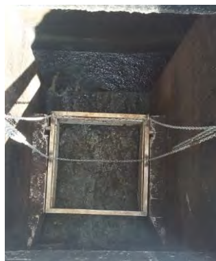
Cesto (retenção sólidos grosseiros)
