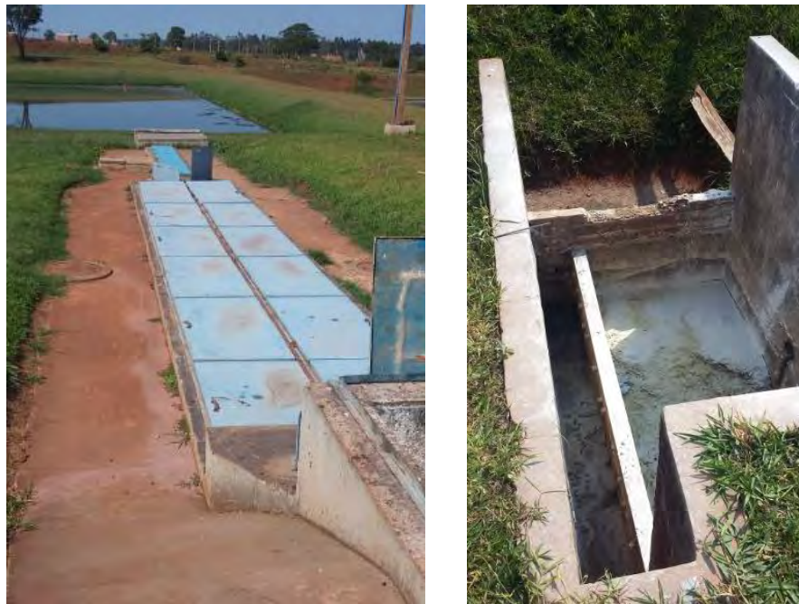
Figura 11: Desarenador (ETE Ipê) e Caixa de Areia
