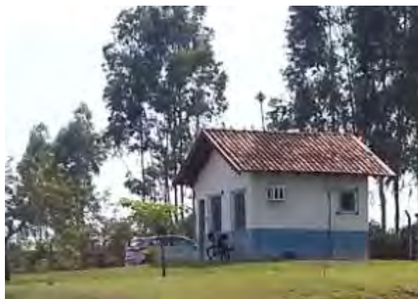
Figura 20: Estrutura de apoio ETE Ipê
