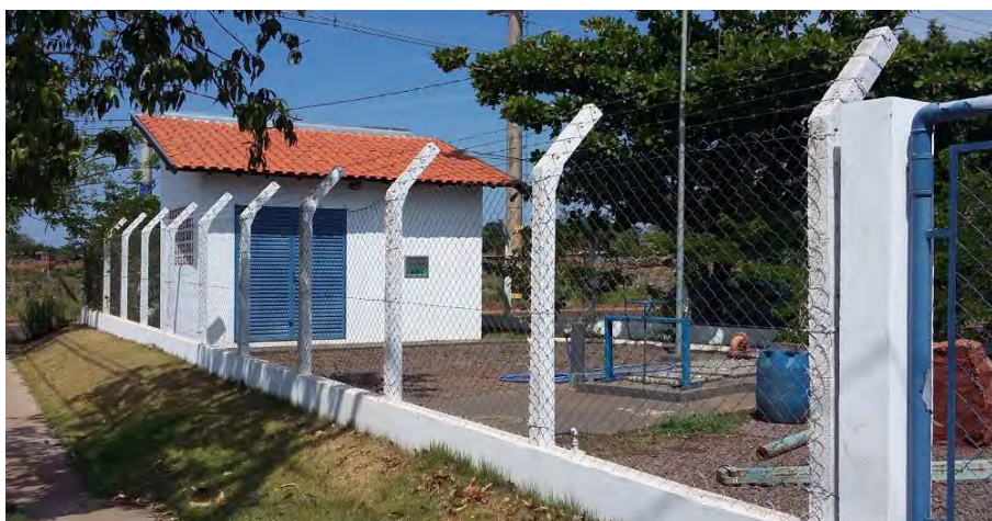
Vista geral da unidade
