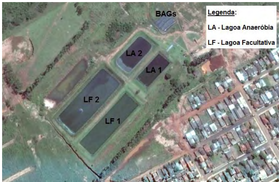
Figura 8: Vista geral superior das unidades (ETE Ipê) Fonte: Google Earth – Adaptado
