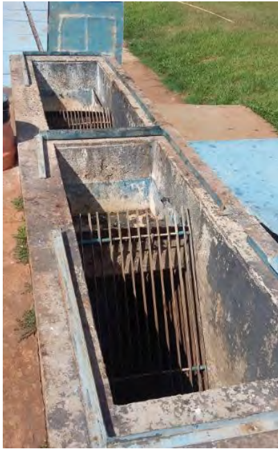
Figura 10: Gradeamento (ETE Ipê) e BAG 1,0m 3 (material sólido grosseiro)
