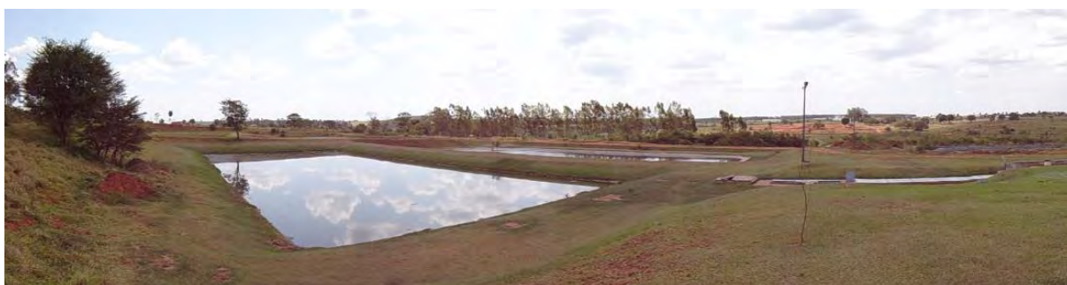
Figura 21: Vista Geral da urbanização da ETE Ipê
