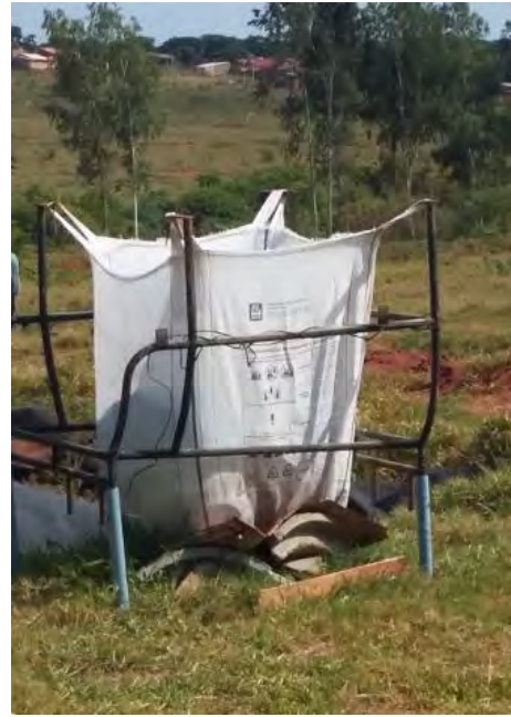
Figura 10: Gradeamento (ETE Ipê) e BAG 1,0m 3 (material sólido grosseiro)
