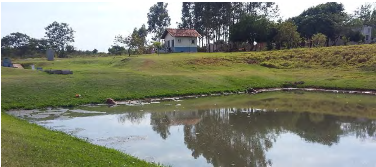
Figura 13: Vista Lagoa Anaeróbia 1 (Entrada)
