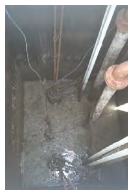
Poço de Sucção
