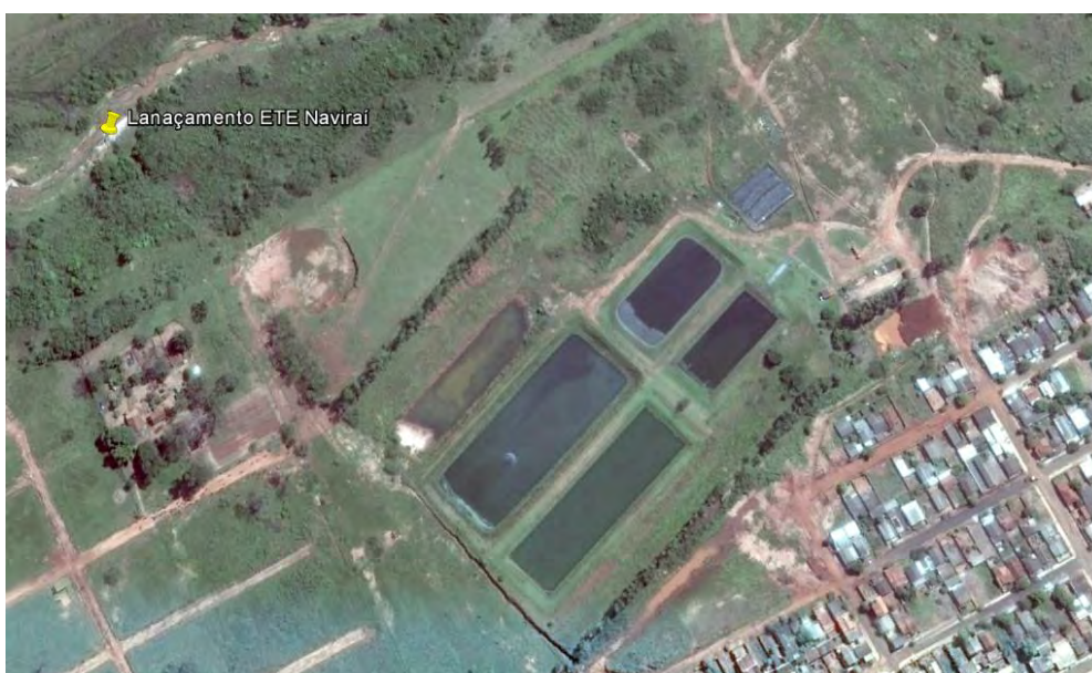
Figura 22: Ponto de lançamento da ETE Ipê – Córrego do Touro
