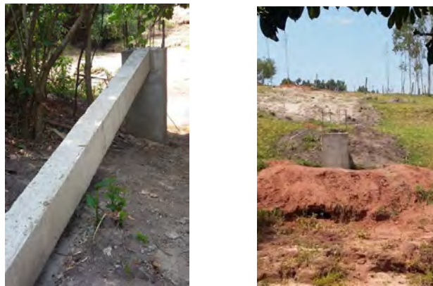
Sustentação tubulação na travessia do Córrego do Touro
