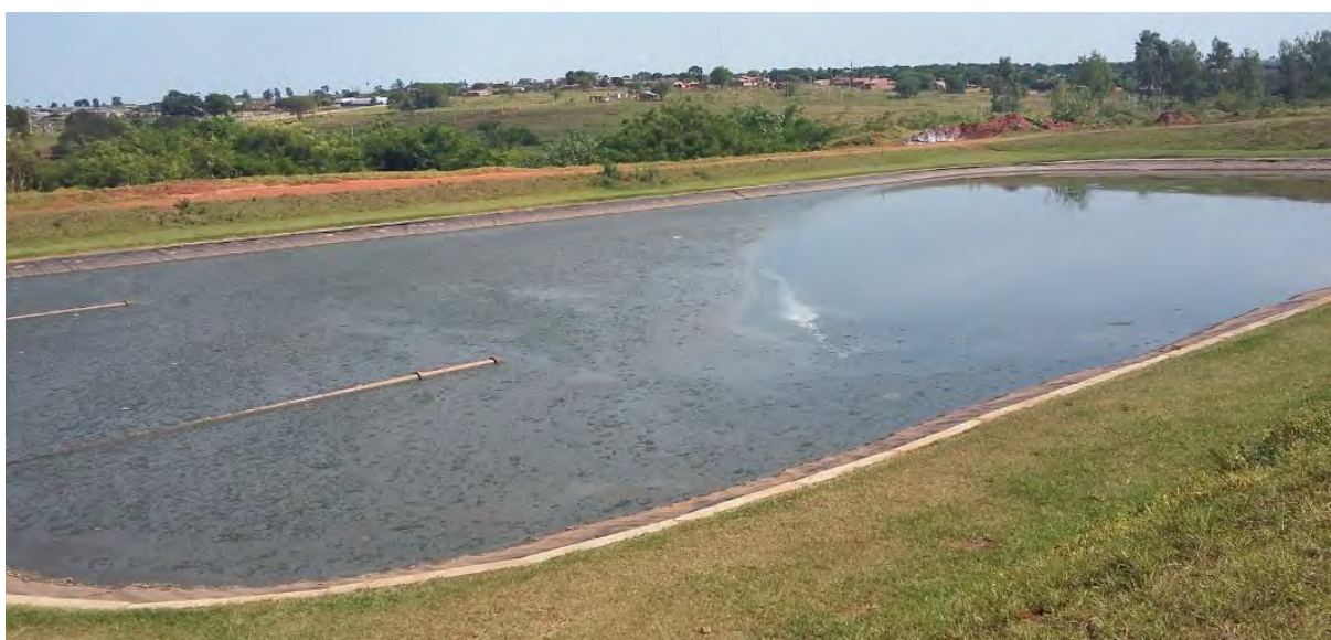
Figura 15: Vista geral da Lagoa Anaeróbia 2
