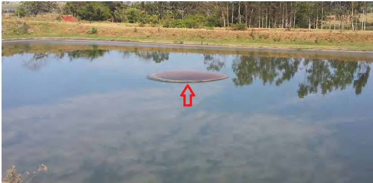
Figura 18: Detalhe “bolsão de gás” Lagoa Facultativa 2
