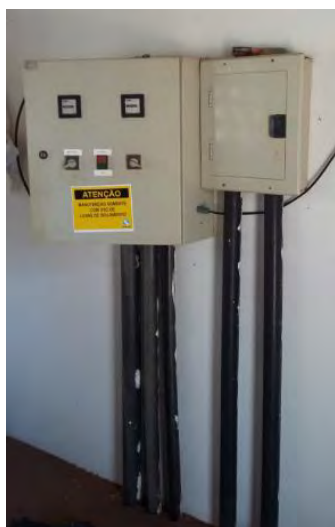
Quadro de comando Grupo gerador Stemac Figura 5: Relatório fotográfico EEEB 01 – Campo Belo (BNH).
