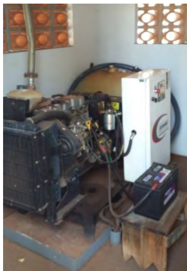
Quadro de comando Grupo gerador Stemac Figura 5: Relatório fotográfico EEEB 01 – Campo Belo (BNH).
