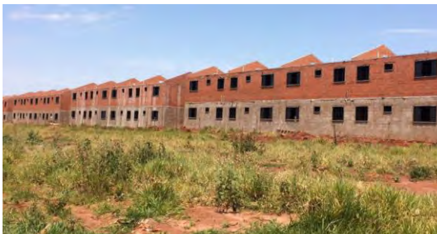
Figura 26: Empreendimento contemplado com obras de infraestrutura de coleta de esgotos (Residencial Deputado Federal Nelson Trad)
