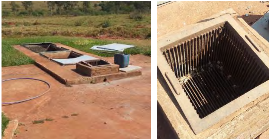
Figura 12: Estrutura de recebimento de Auto-Fossa / Cesto remoção de sólidos grosseiros
