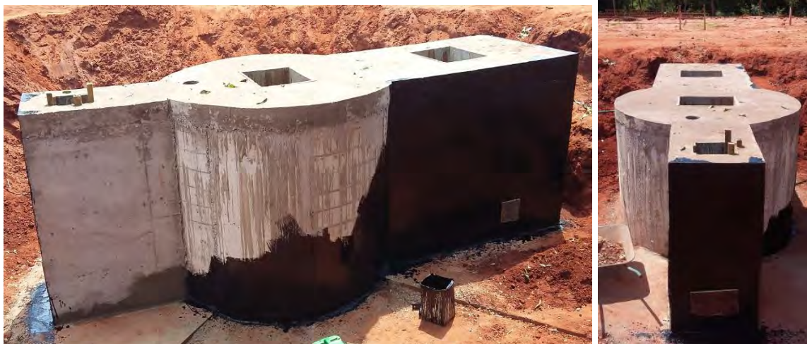
Vista geral da unidade em construção
