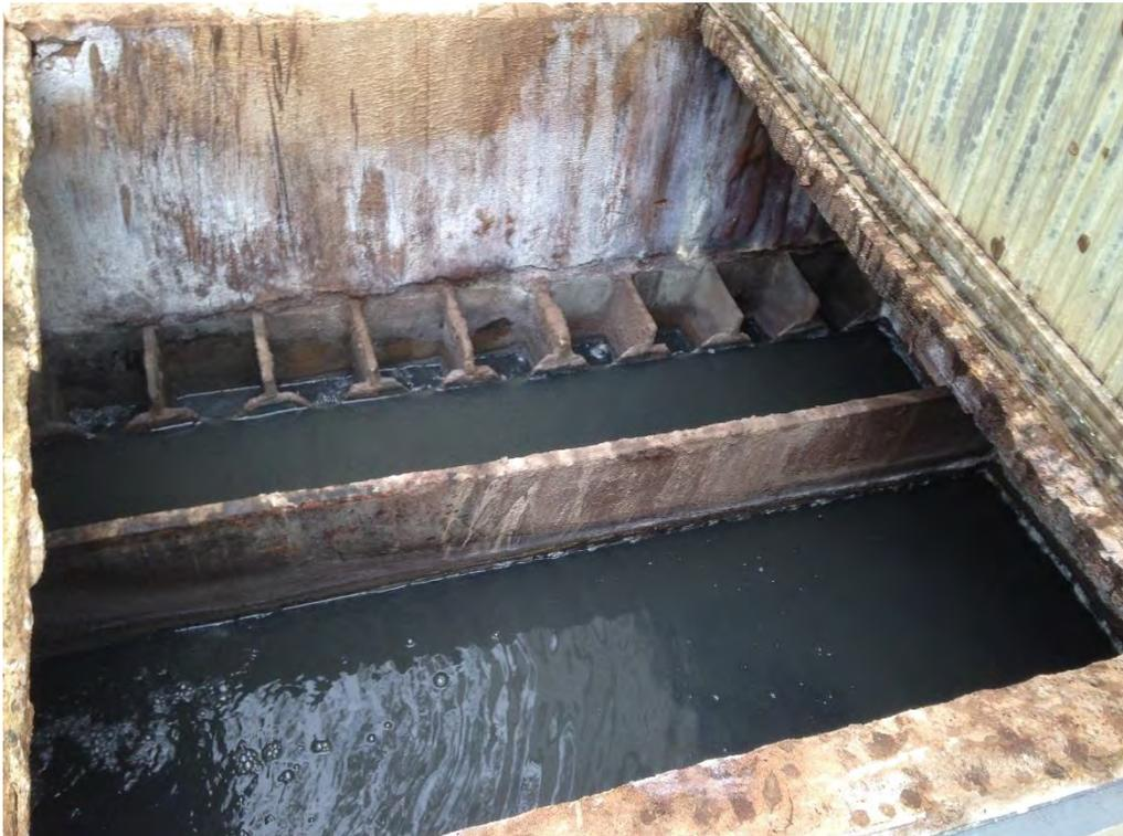
**Figura 18: ETE Miranda – Tratamento primário – Vista interna do reator UASB**
