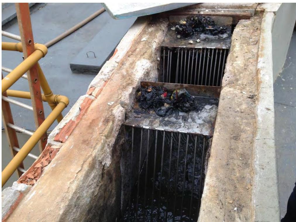
**Figura 14: ETE Miranda – Tratamento preliminar - Canal de gradeamento**
