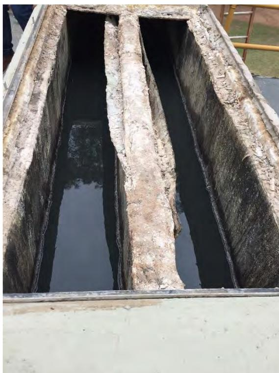
**Figura 16: ETE Miranda – Tratamento preliminar - Desarenador**
