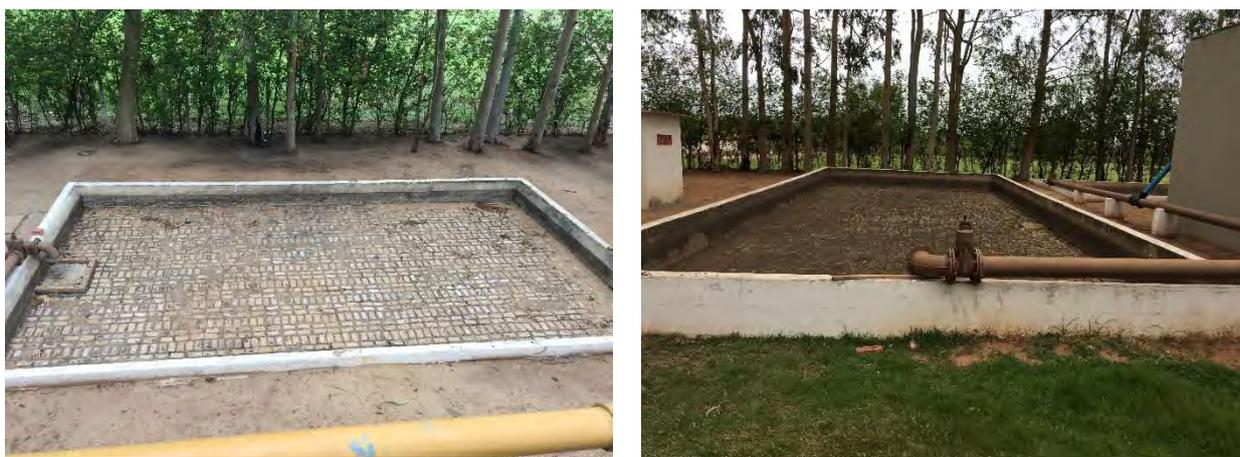
**Figura 20: ETE Miranda – Pós-tratamento – Leitos de secagem**
