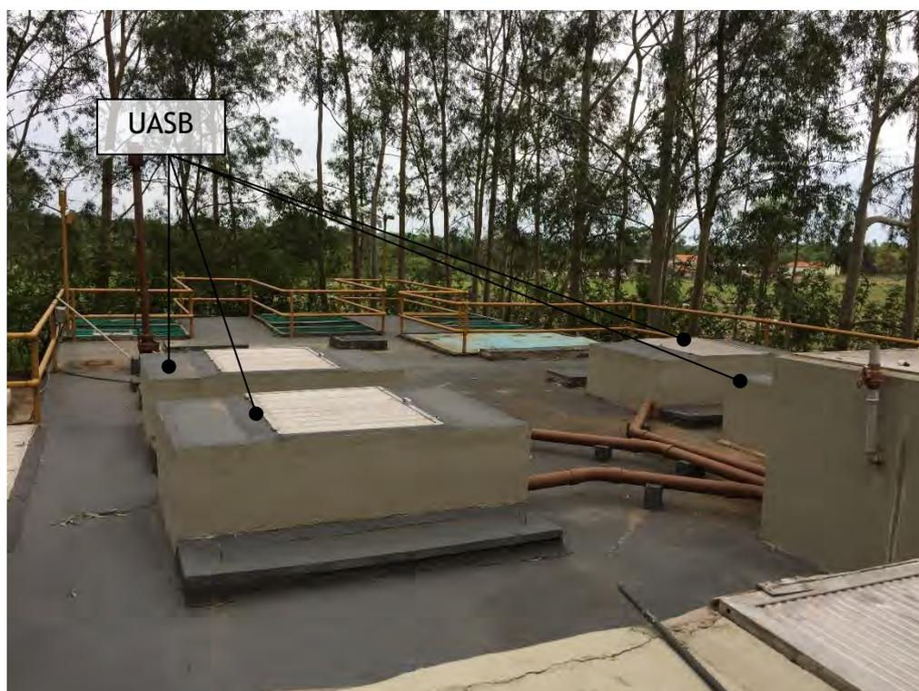
Figura 17: ETE Miranda – Tratamento primário – Vista externa dos reatores UASB
