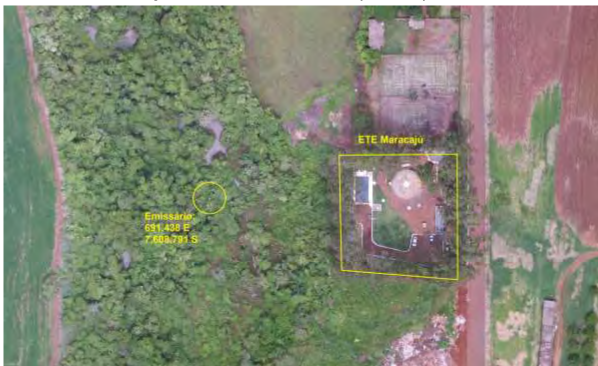
Figura 3: Vista aérea da ETE Maracaju e entorno, Maracaju, MS.
