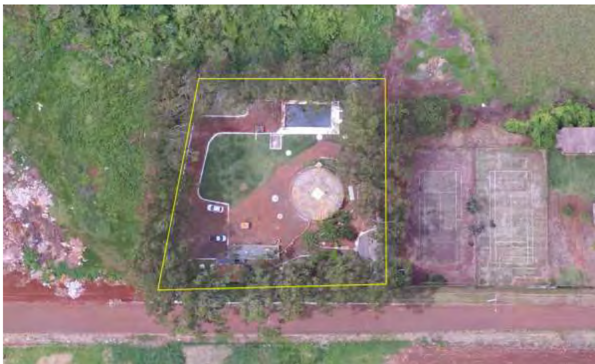
Figura 2: Vista aérea da ETE Maracaju, Maracaju, MS.
