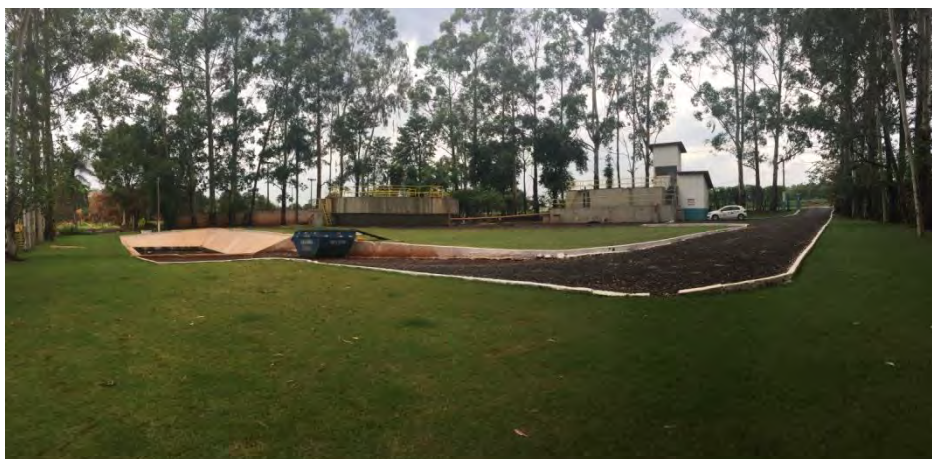
Vista geral - ETE Maracaju
