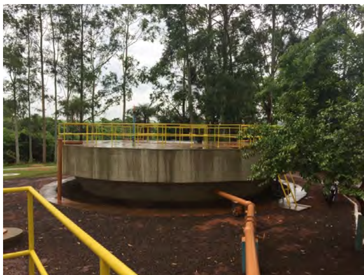
Figura 12: Vista externa do reator RALF
