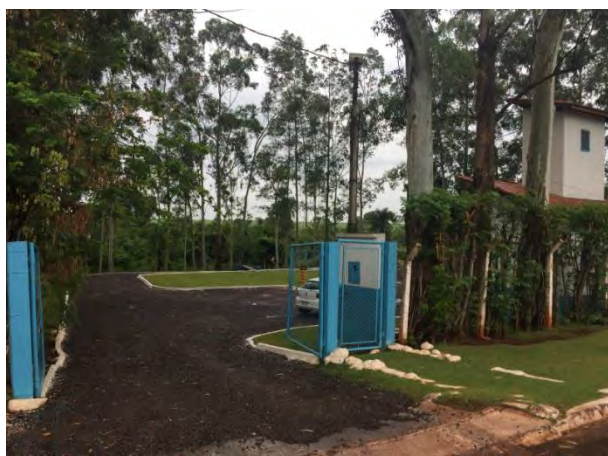
Entrada da ETE Maracaju
