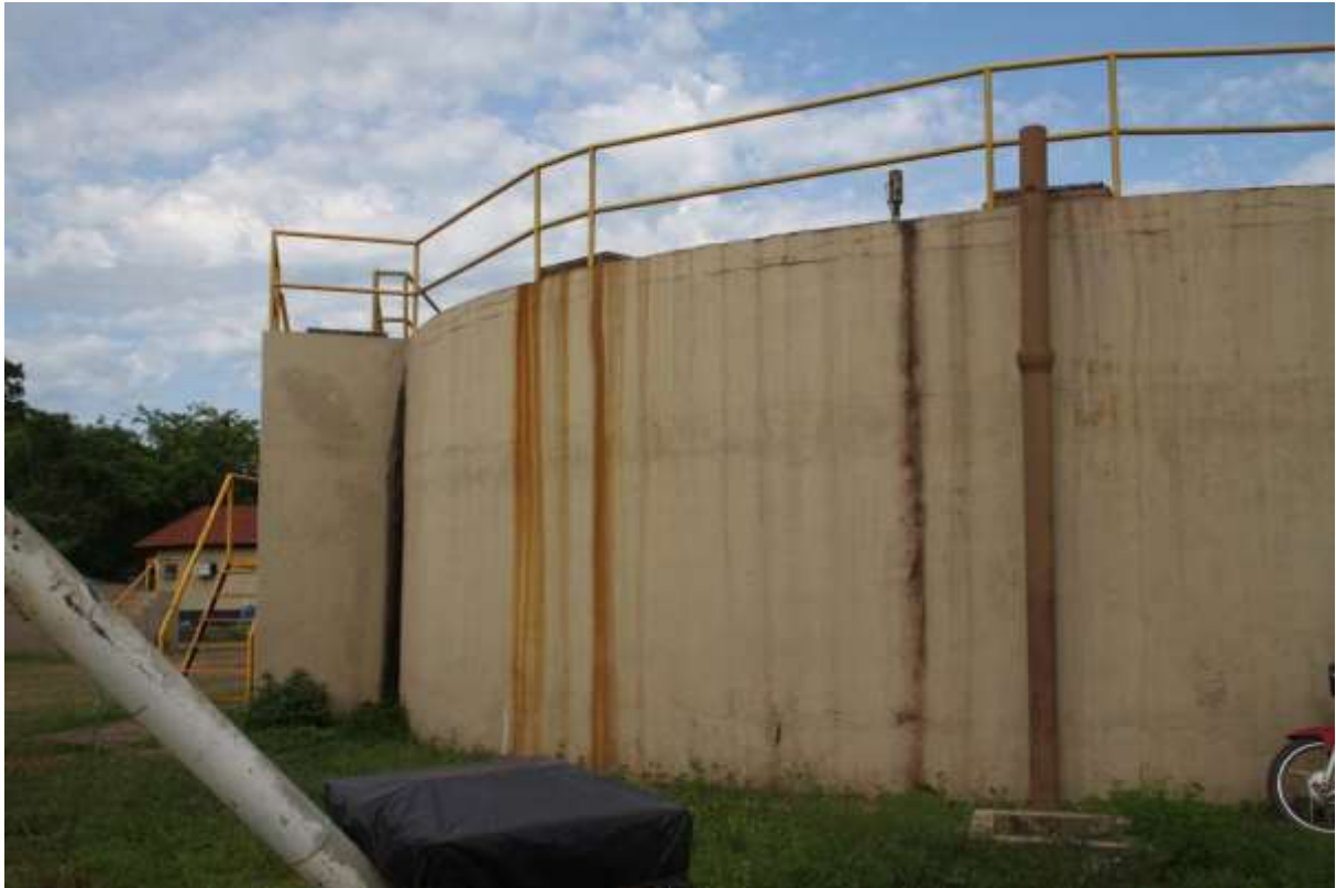
Figura 5: Vazamentos na parede externa do UASB ETE Ladário, Ladário, MS.
