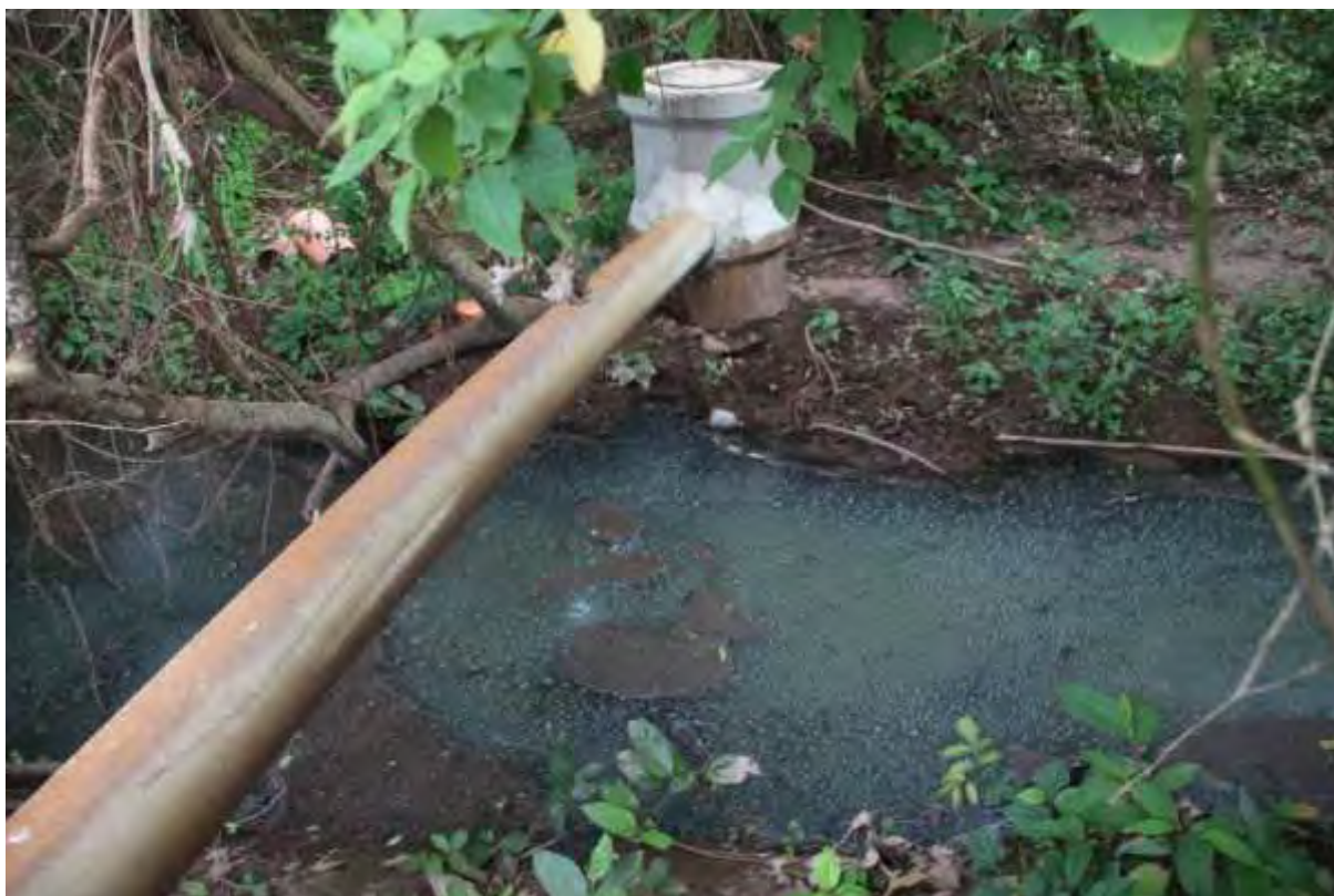
Figura 6: Vazamento do efluente no córrego sem denominação na área da ETE Ladário, Ladário, MS.
