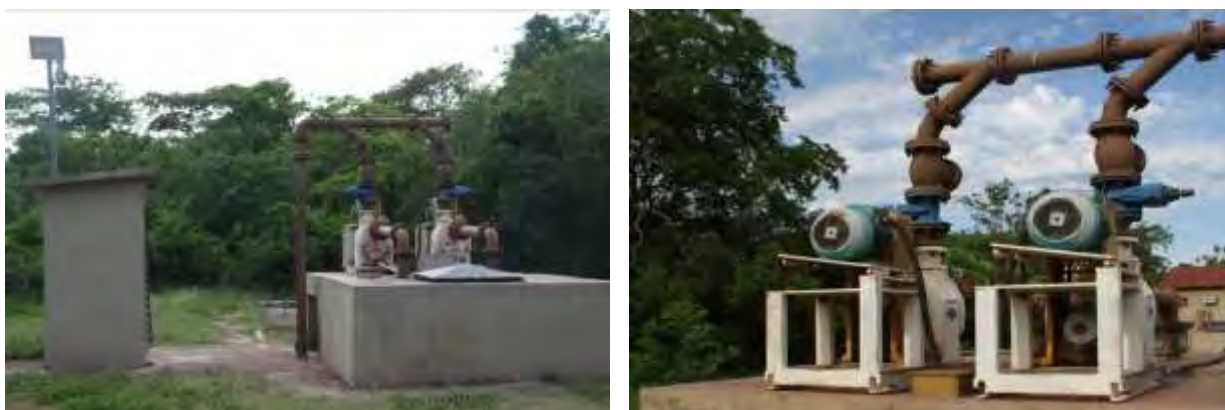
Figura 11: Vista geral da EEEB ETE SEAC, Ladário, MS.
