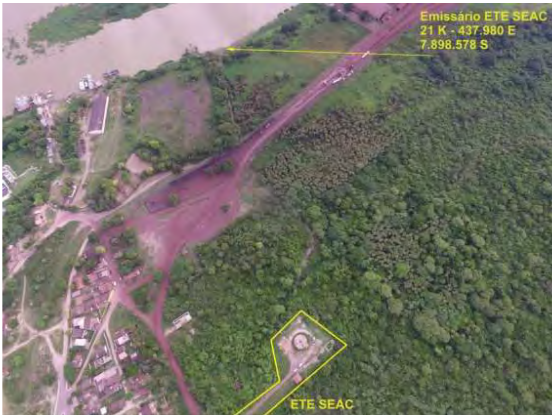
Figura 3: Vista aérea da ETE SEAC e entorno, Ladário, MS.
