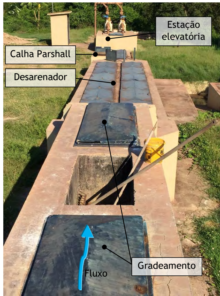
Figura 13: ETE SEAC – Tratamento preliminar
