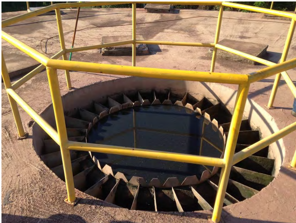
Figura 20: ETE SEAC – Tratamento primário - Entrada do reator
