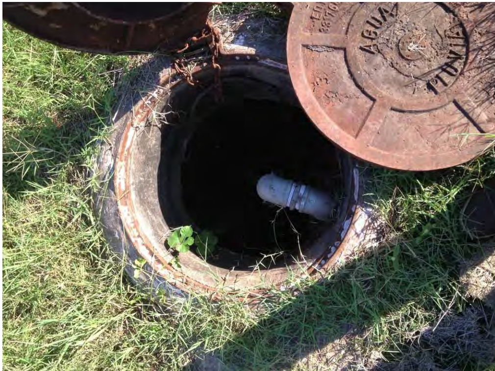
Figura 17: ETE SEAC – Tratamento preliminar - Estação elevatória de efluente da caixa de areia
