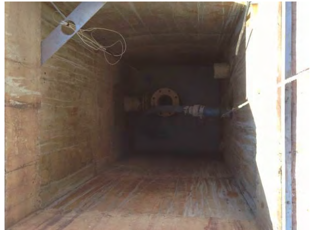
Poço de sucção
