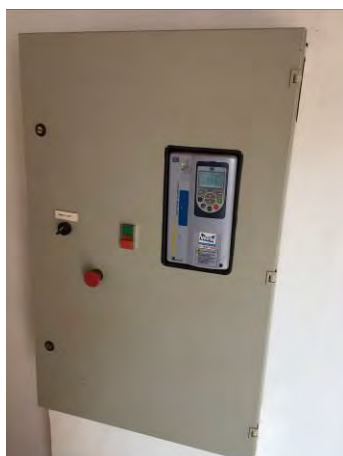
Quadro de comando
