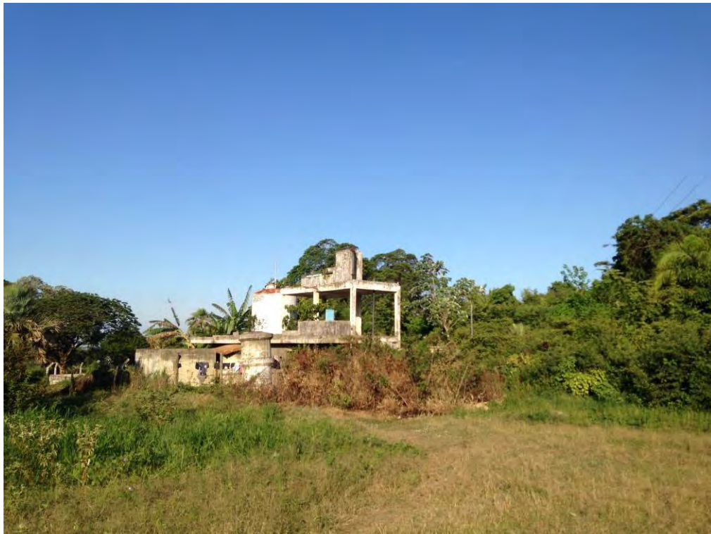
Figura 29: ETE Desativada – Vista geral
