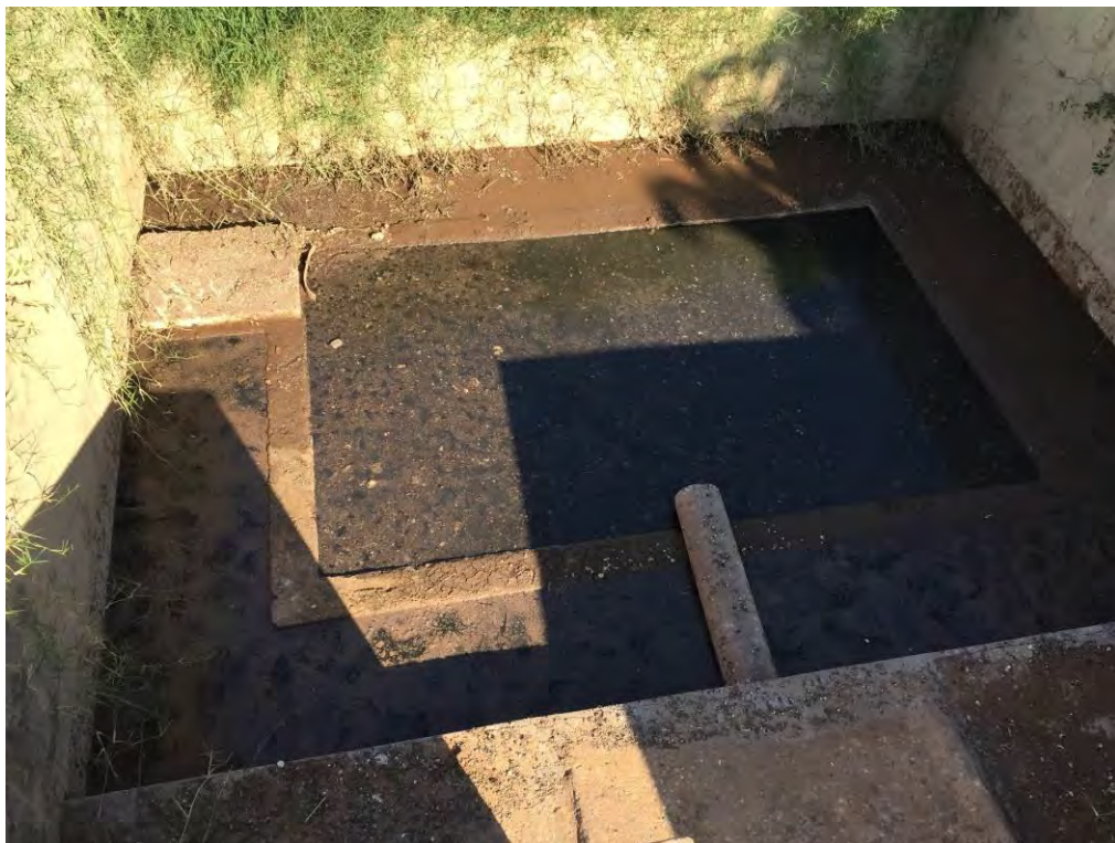
Figura 16: ETE SEAC – Tratamento preliminar – Caixa de areia
