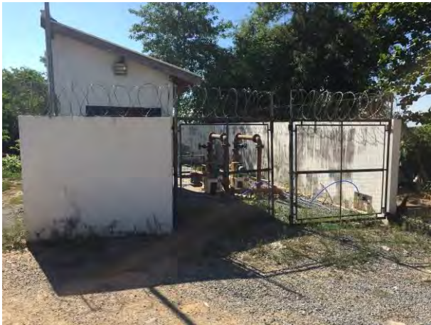
Vista externa / urbanização
