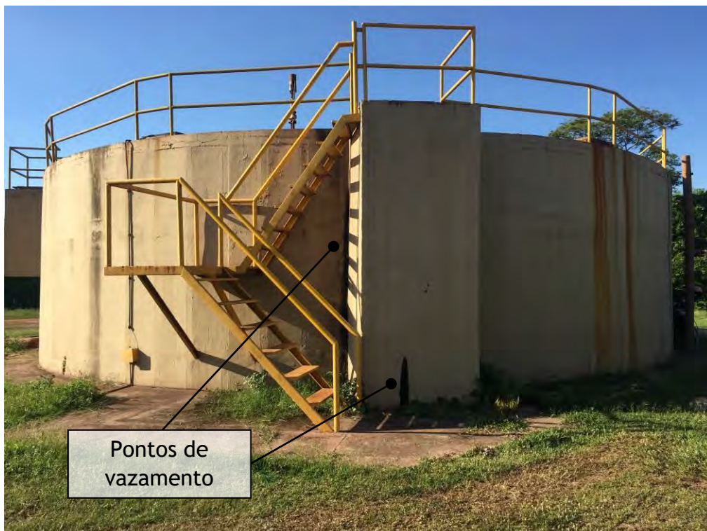
Figura 22: ETE SEAC – Tratamento primário – Vazamentos no UASB
