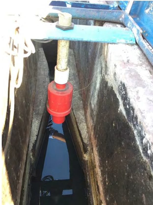
Figura 18: ETE SEAC – Tratamento preliminar – Calha Parshall e medidor ultrassônico
