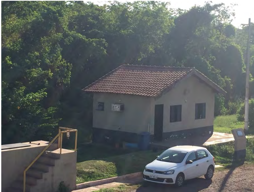
Figura 24: ETE SEAC - Sede operacional
