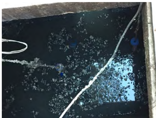
Presença de sólidos grosseiros a jusante do gradeamento
