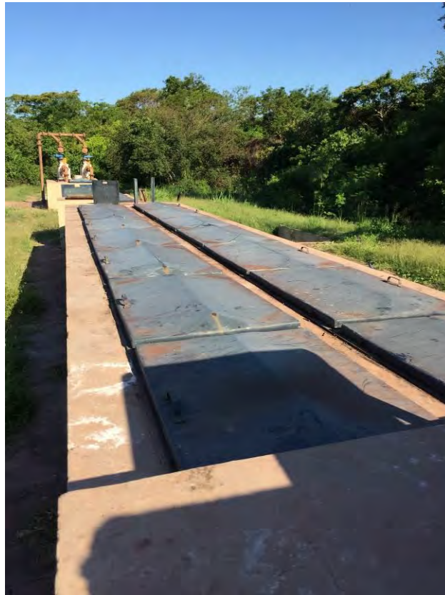
Figura 15: ETE SEAC – Tratamento preliminar – Desarenador
