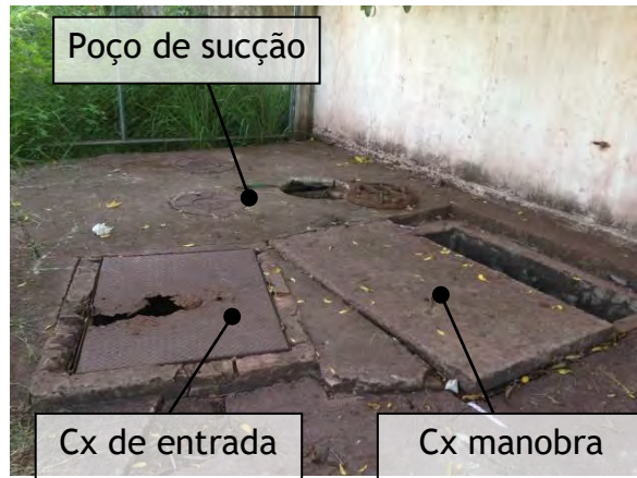
Poço de sucção
