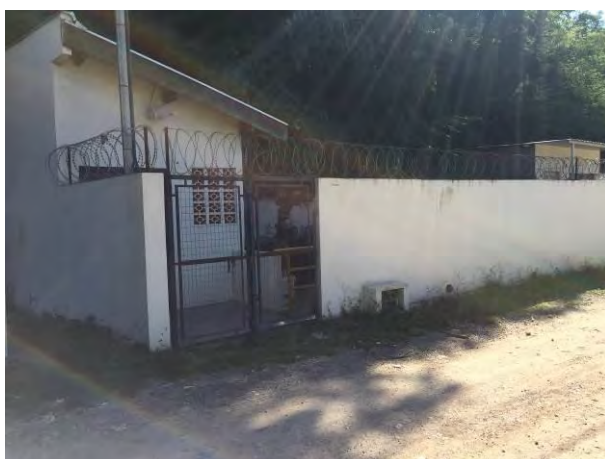
Vista externa / urbanização
