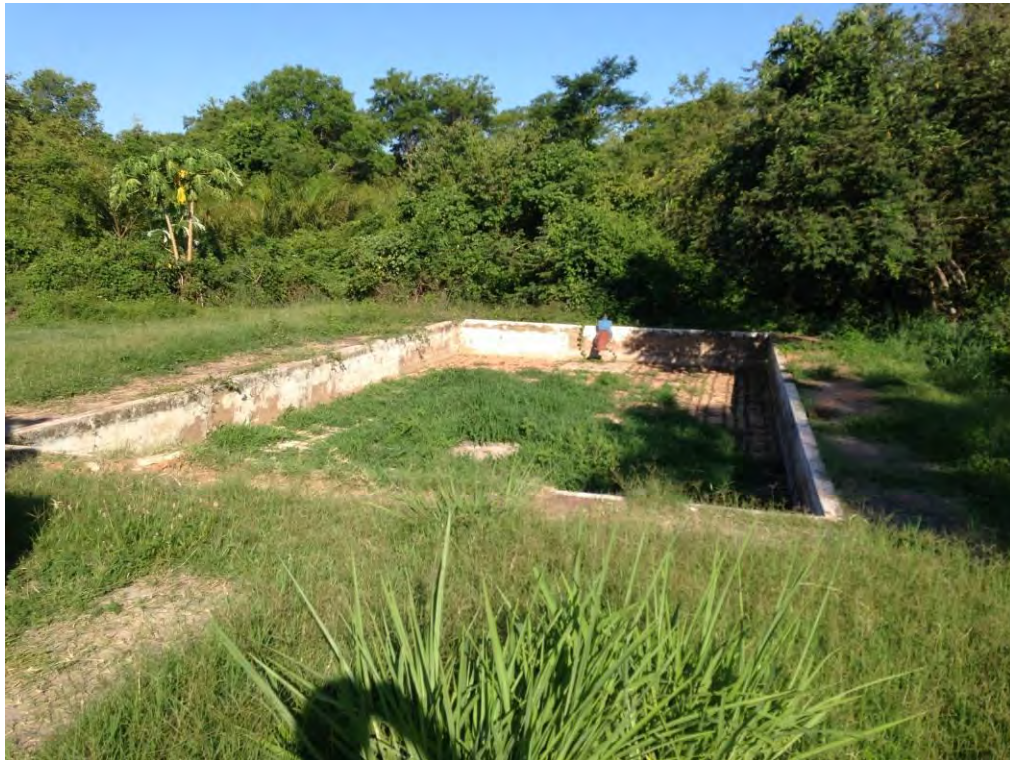
Figura 23: ETE SEAC- Tratamento de lodo e destino final - Leitos de secagem
