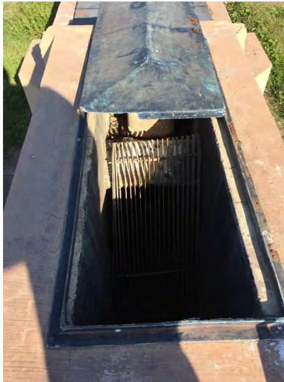
Figura 14: ETE SEAC – Tratamento preliminar - Canal de gradeamento
