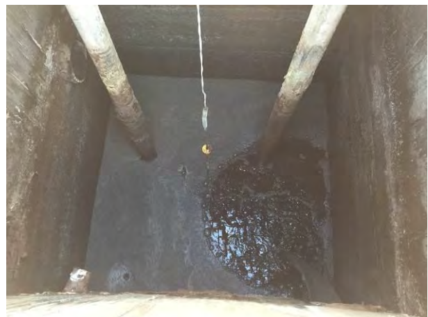
Interior do poço de sucção
