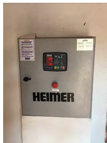
Painel de comando do gerador
