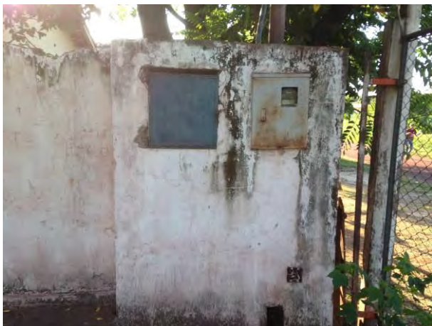
Quadro de comando
