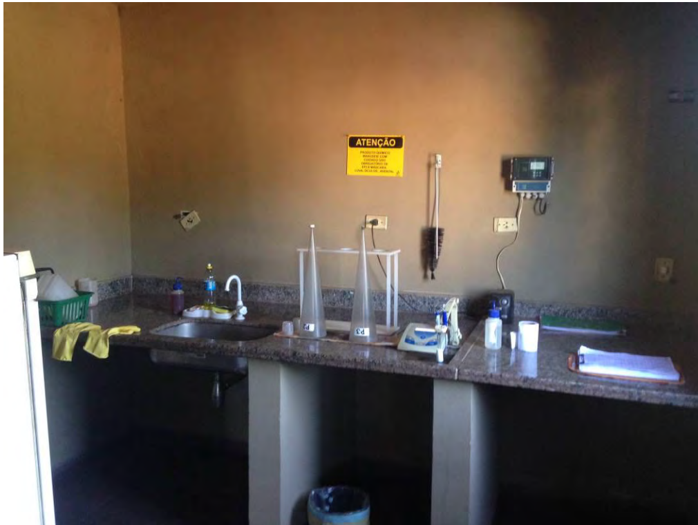
Figura 25: ETE SEAC – Estruturas auxiliares – Laboratório
