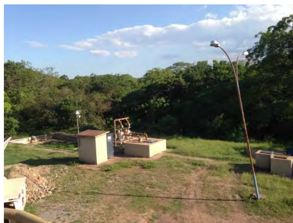
Presença de vegetação em todo o perímetro da ETE
