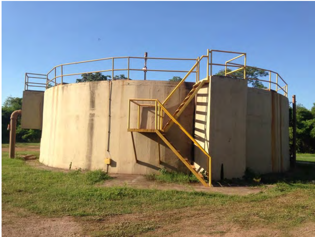
Figura 19: ETE SEAC – Tratamento primário - Vista externa do reator UASB
