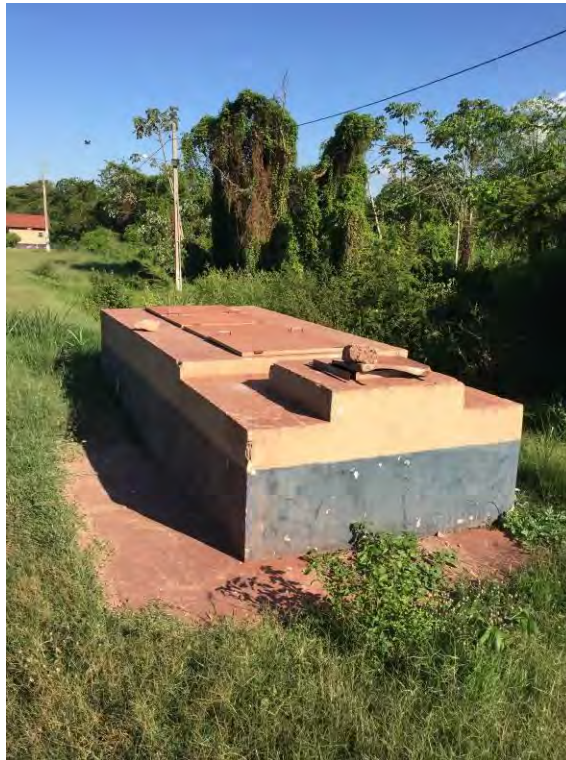
Figura 12: ETE SEAC – Tratamento preliminar – Caixa de recebimento de limpa fossa
