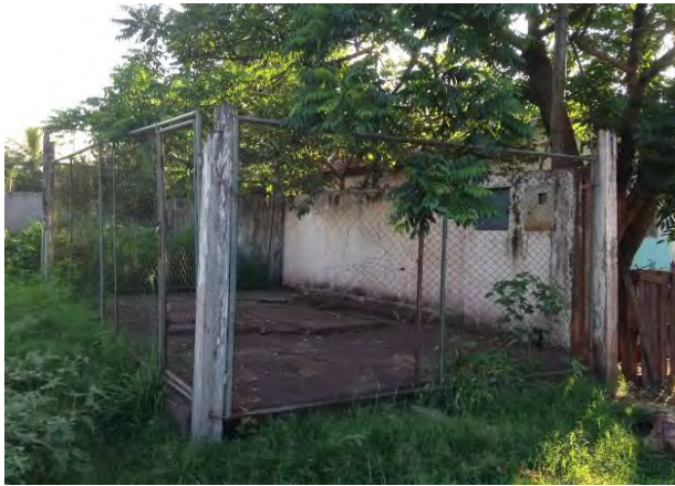
Vista externa / urbanização
