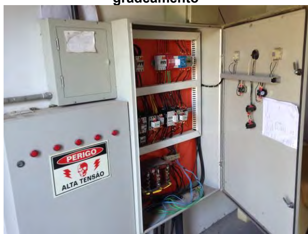
Quadro de comando
