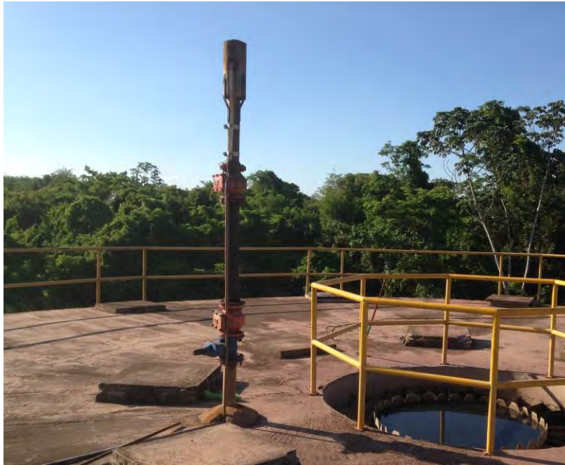
Figura 21: ETE SEAC – Tratamento primário - Queimador de Gás
