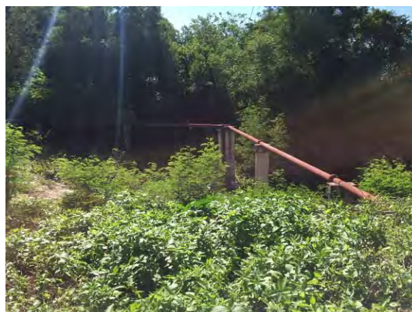
Linha de recalque
