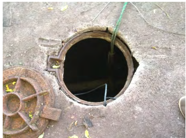
Tampa do poço de sucção
