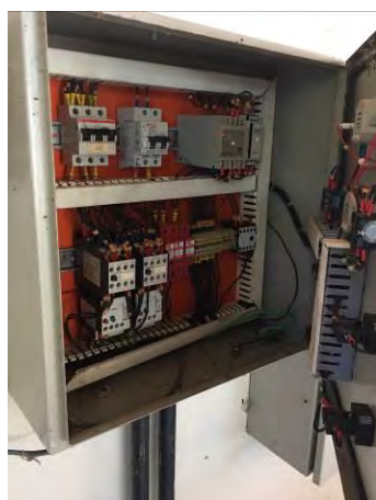
Quadro de comando
