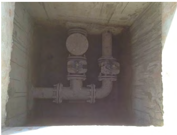
Caixa de manobra (barrilete e descarga)
