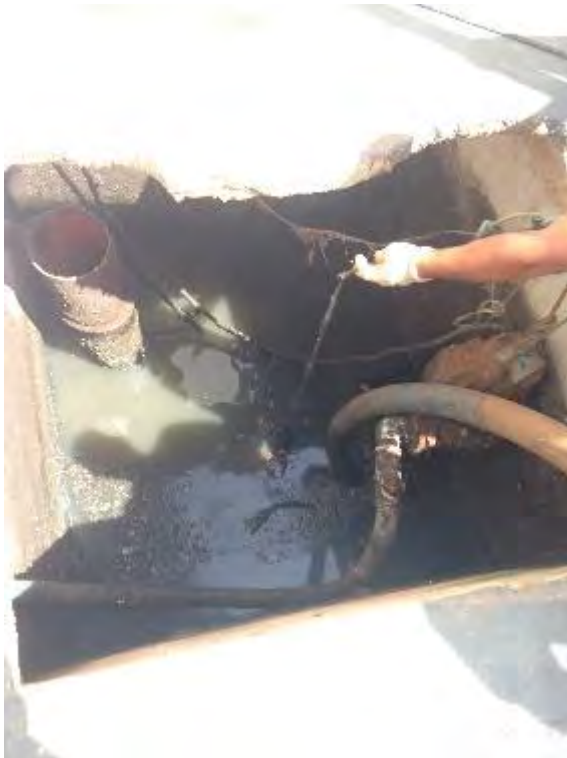
Retirada do cesto coletor
