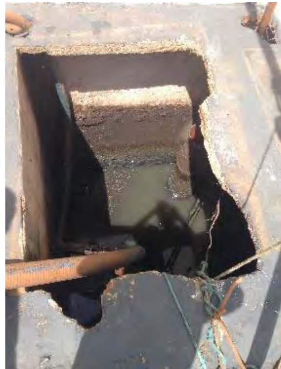
Poço de sucção
