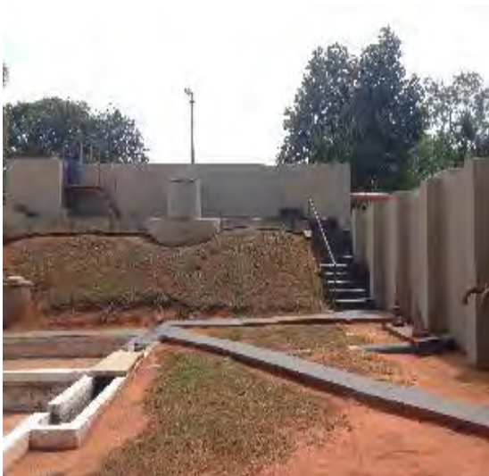
Tratamento preliminar vista lateral
