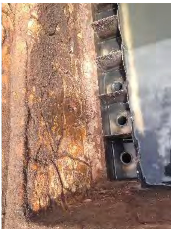
Vertedores triangulares e tubos distribuidores de vazão
