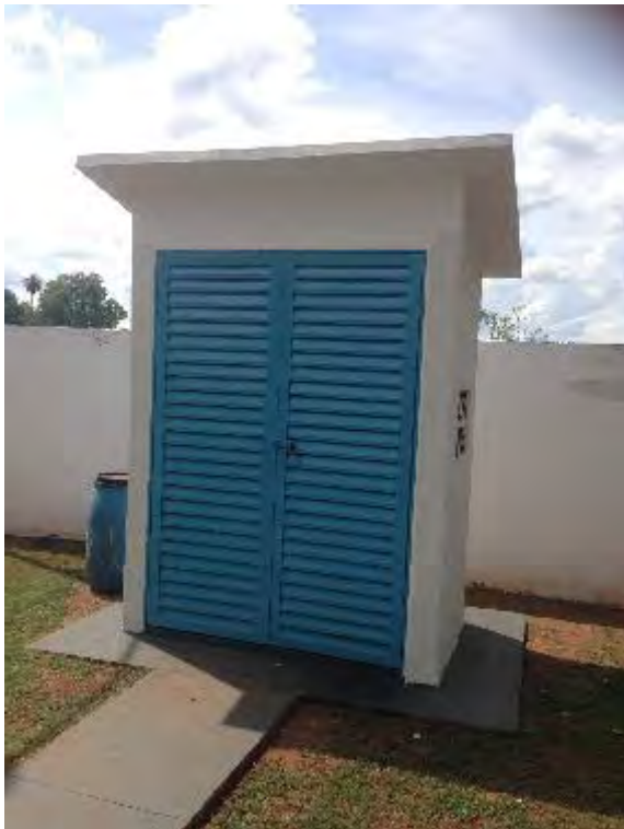
Quadro de Comando
