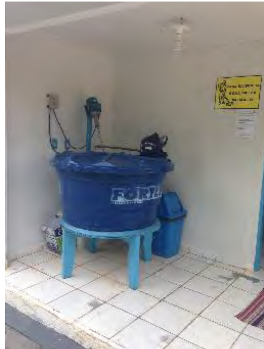
Tanque de mistura da cal
