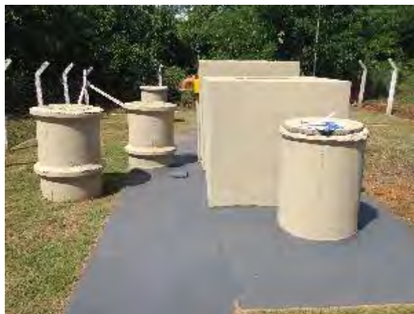
Elevatória sujeita a inundações do Rio Aquidauana
