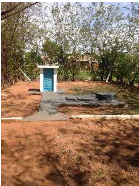
Interno: poço de sucção e abrigo de quadro de comando.
