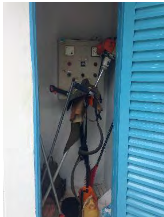
Abrigo de quadro de comando
