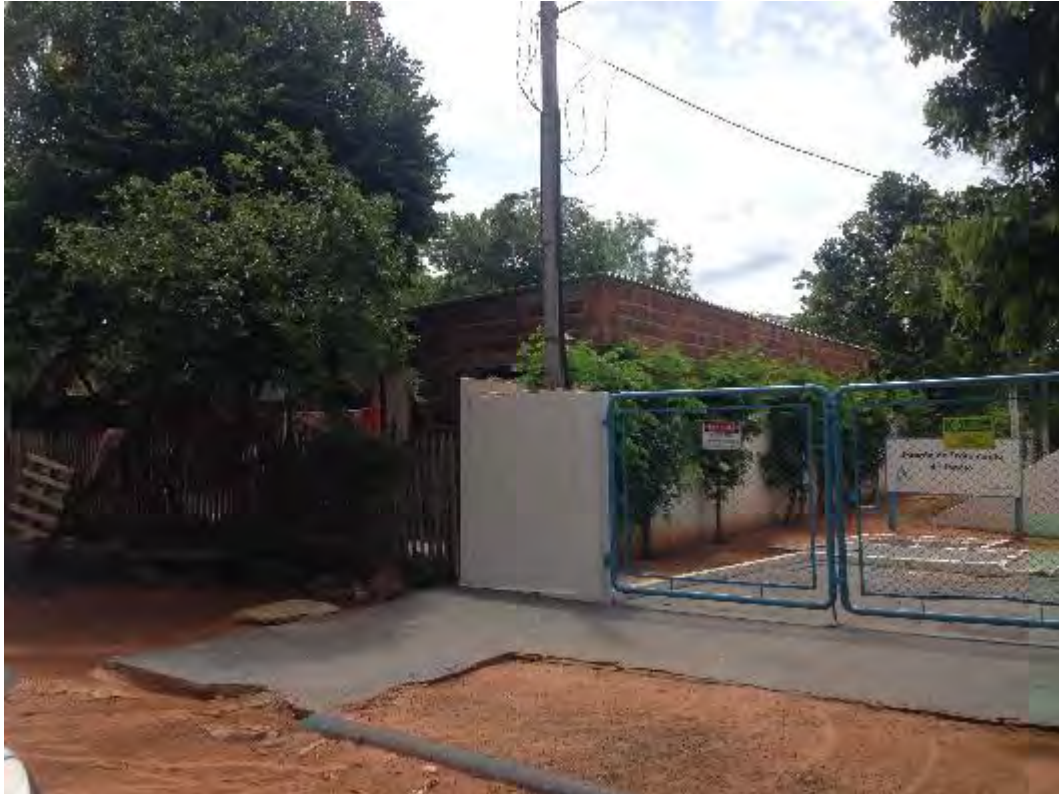
Entrada da ETE Anastácio.
