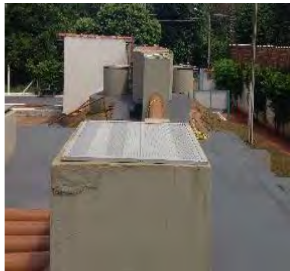
Tratamento preliminar vista frontal
