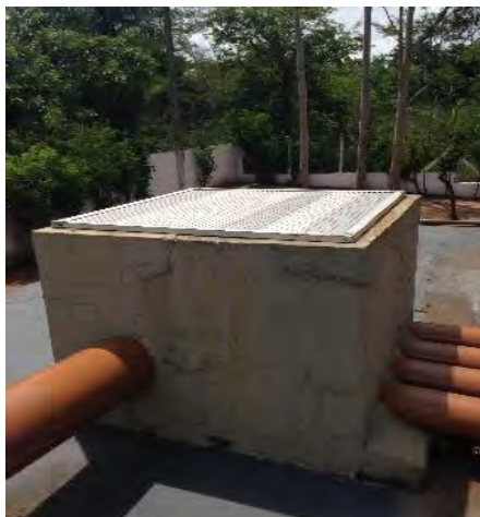
Caixa com vertedores de distribuição (Equalizador de vazão)
