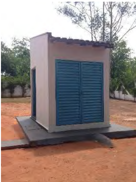
Depósito de apoio
