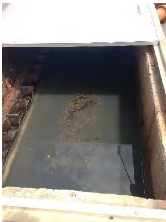
Esgoto parado na câmara de distribuição do reator, evidenciando problema de nivelamento
