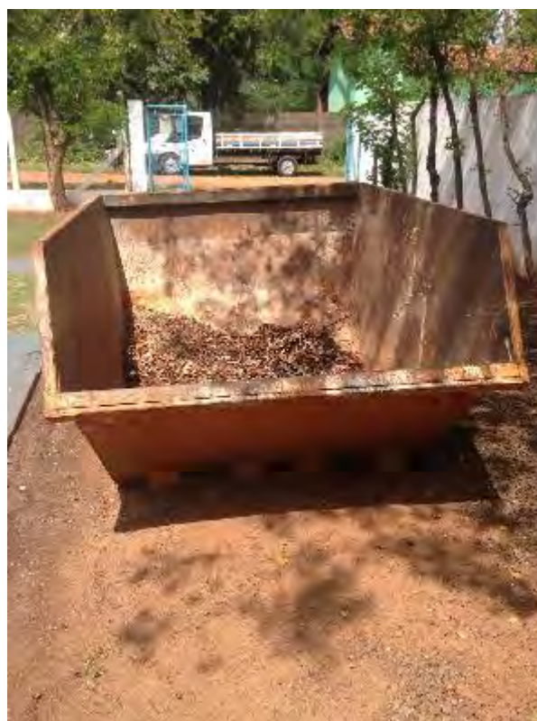
Caçamba para armazenamento dos resíduos retidos no gradeamento
