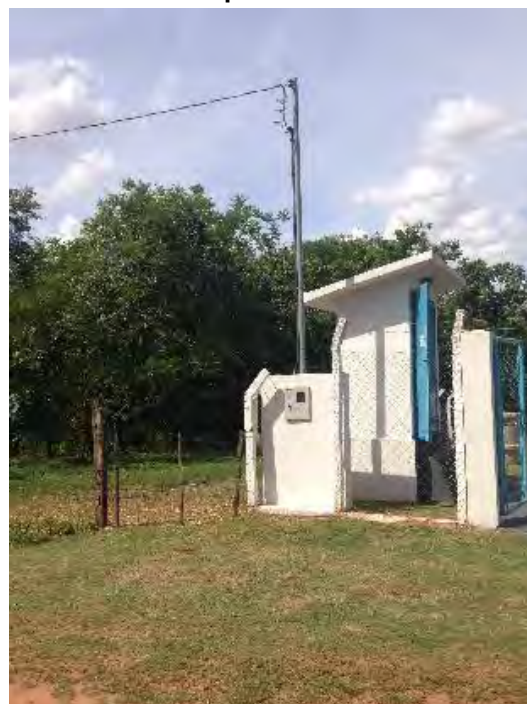
Padrão de entrada de energia
