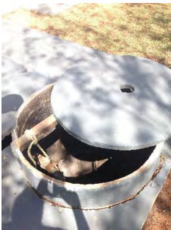
Poço de sucção Ø 0,50m.
