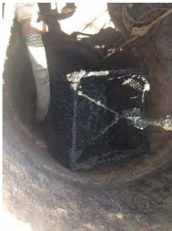
Cesto coletor para retenção dos sólidos grosseiros.
