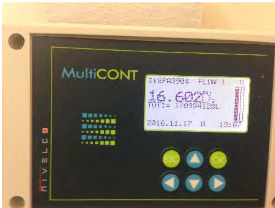
Figura 11: Painel do medidor de vazão ultrassônico da ETE Anastácio demonstra a vazão média afluyente.
