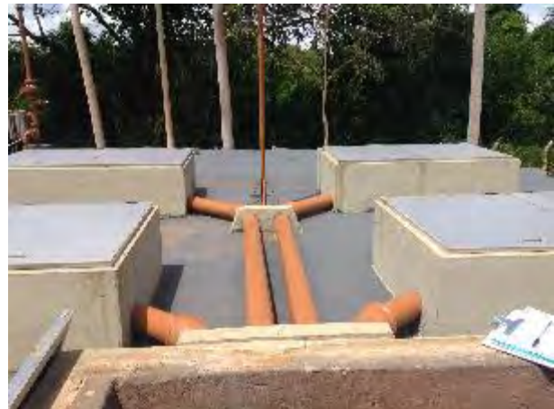
Divisão do esgoto afluente para tratamento no reator
