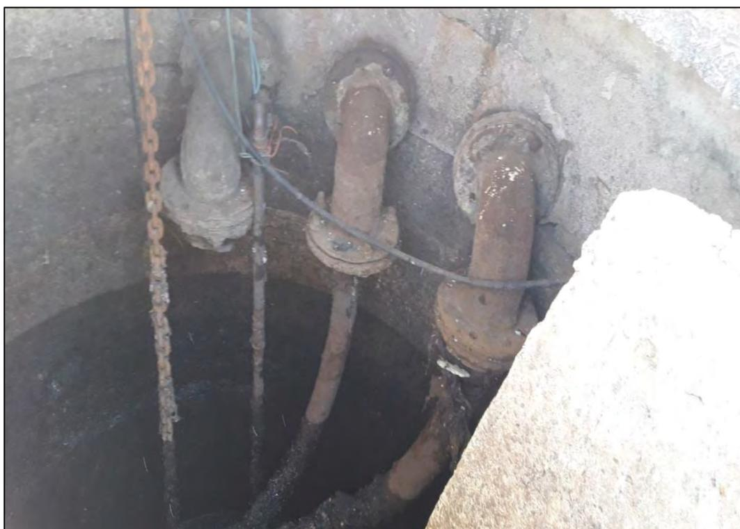
**Figura 12: Tubulação de recalque.**
