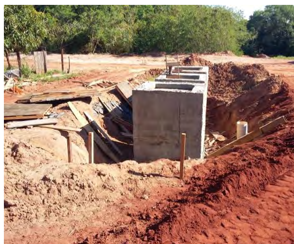
Figura 28: Local da construção EEEB – 001 em Jateí.
