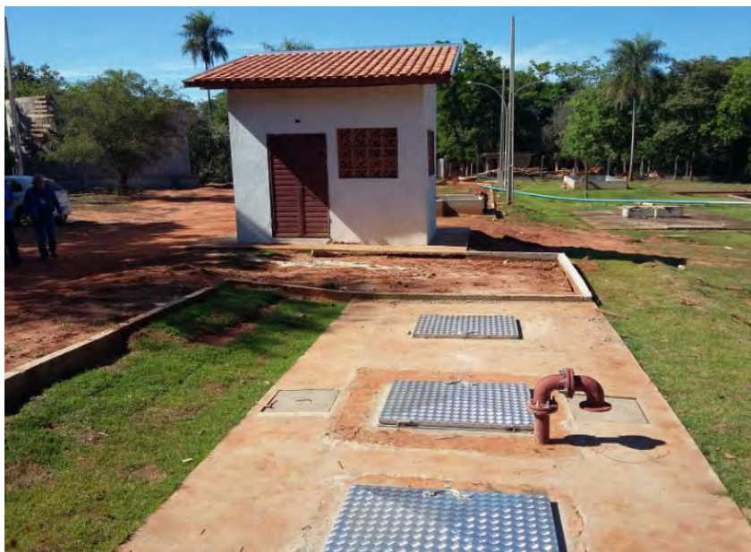
Figura 29: Relatório fotográfico EEEB-002 em fase final de construção, ETE Jateí.
