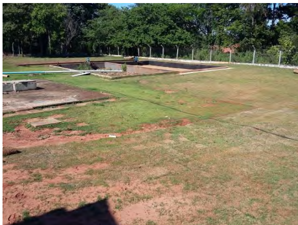
Figura 6: Vista 1 – Área da ETE Jateí.
