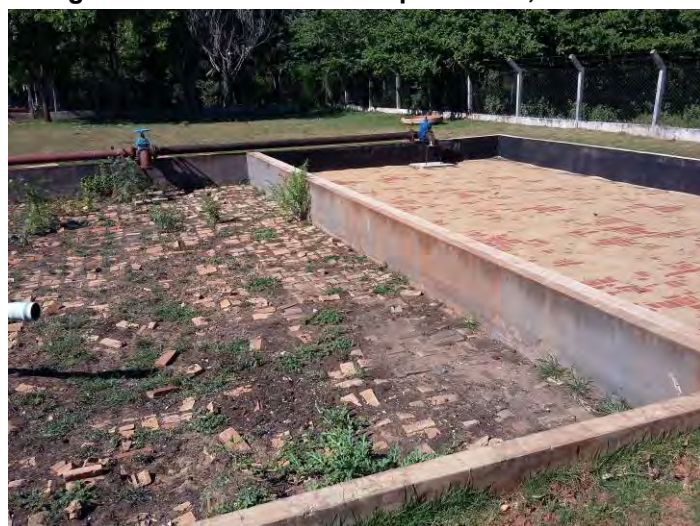
Figura 34: Novo leito de secagem à direita, ETE Jateí.
