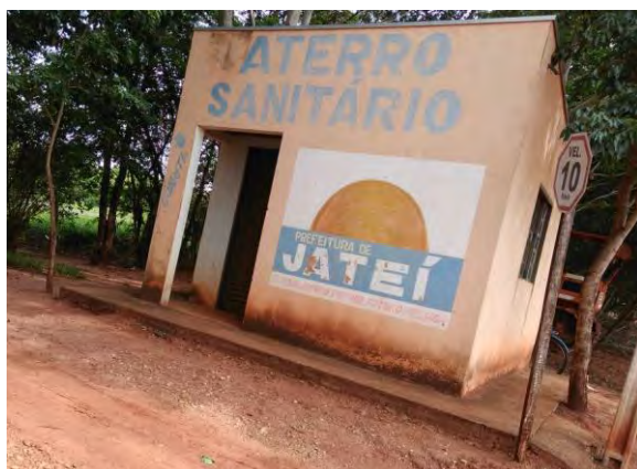
Figura 25: Entrada do aterro sanitário de Jateí.
