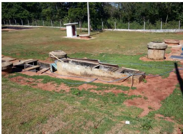
Figura 8: Vista Geral tratamento preliminar existente, ETE Jateí.
