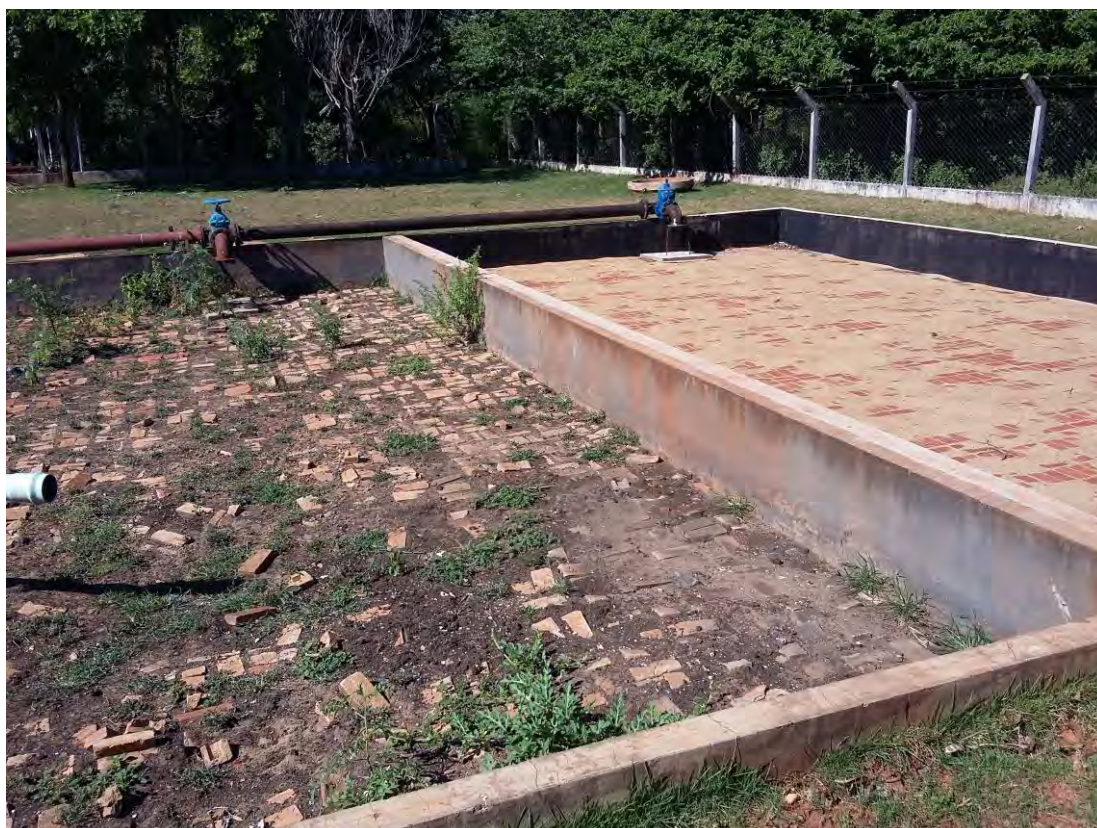
Figura 19: Leito de secagem antigo (à esquerda) e novo (à direita), ETE Jateí.
