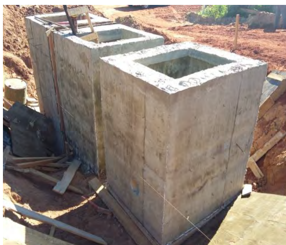
Figura 27: Construção da EEEB – 001 em Jateí.
