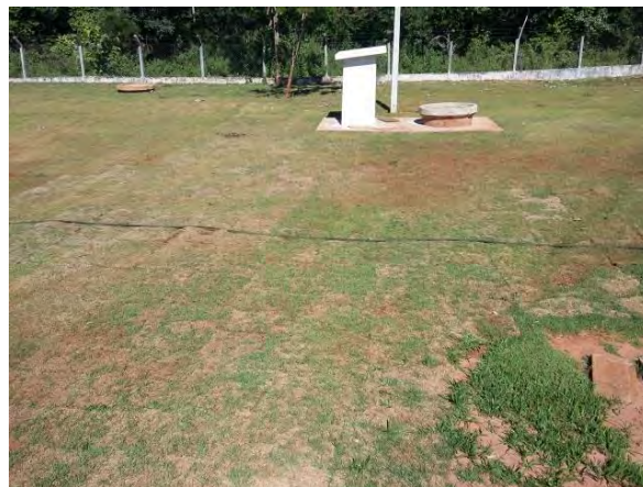
Figura 7: Vista 2 – Área da ETE Jateí.
