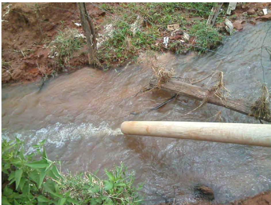
Figura 24: Ponto de lançamento do efluente da ETE Jateí no Córrego Dona Rosa.
