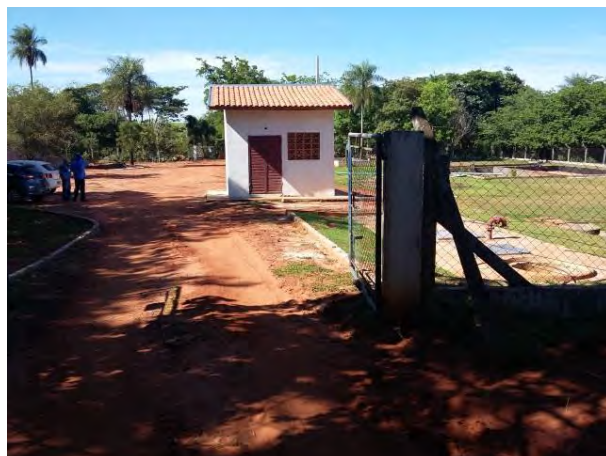
Figura 22: Entrada da ETE Jateí.
