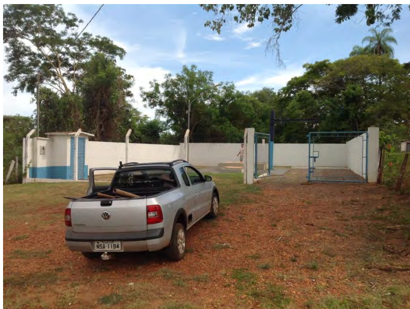
Figura 10: Vista geral – EEEB Centro
