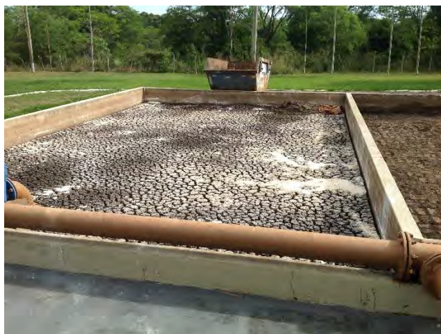
Figura 36: Leitos de secagem
