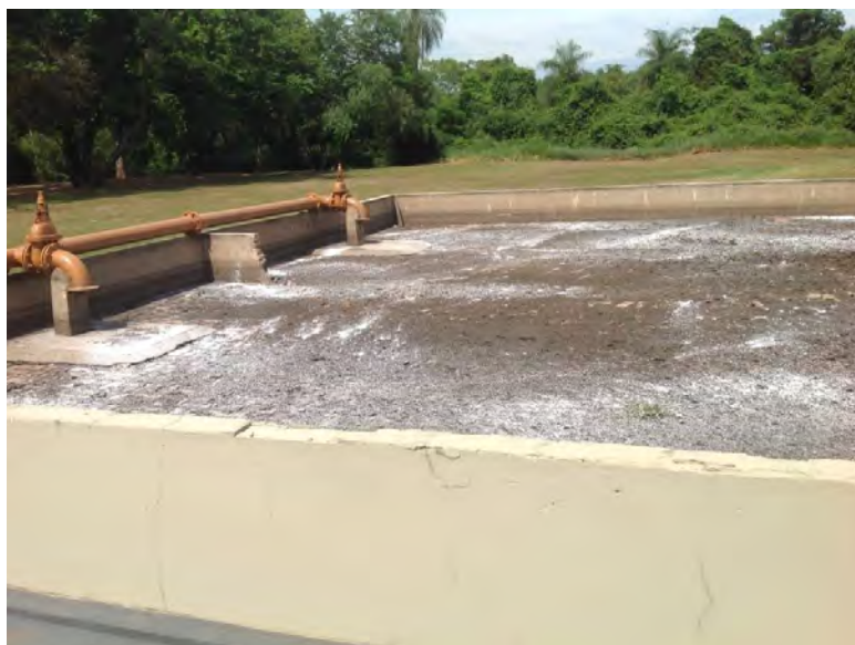
Figura 22: Leito de secagem
