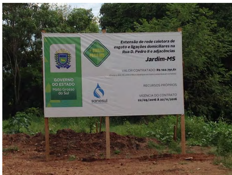
Figura 42: Placa – Obras em andamento
