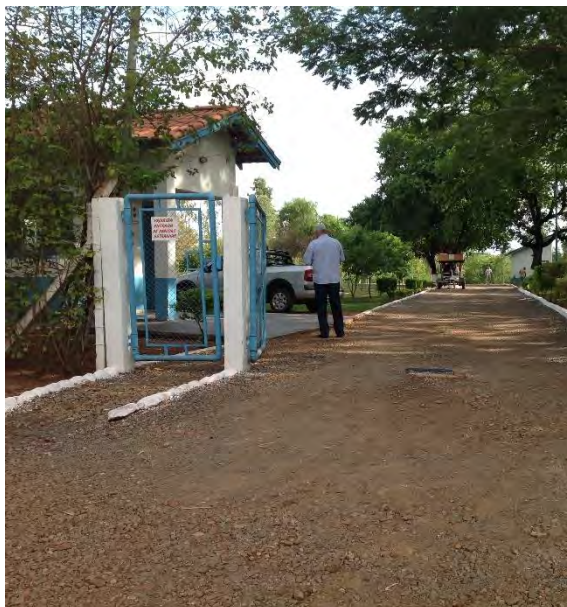
Entrada da ETE
