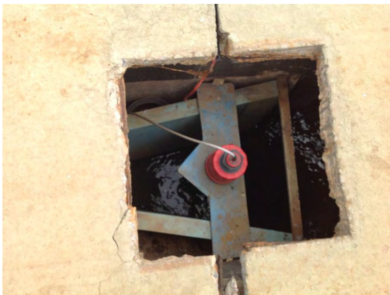
Figura 30: Calha Parshall e medidor de vazão ultrassônico
