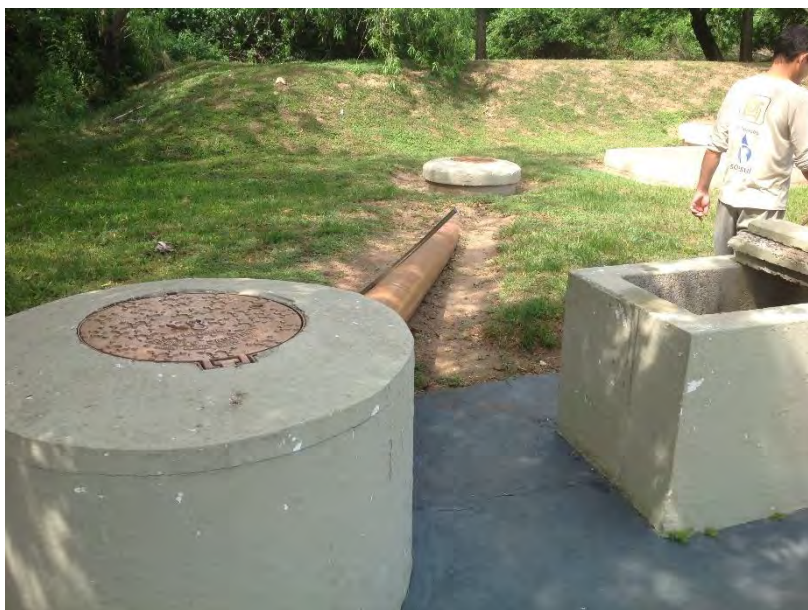
Figura 15: PV de entrada do tratamento preliminar
