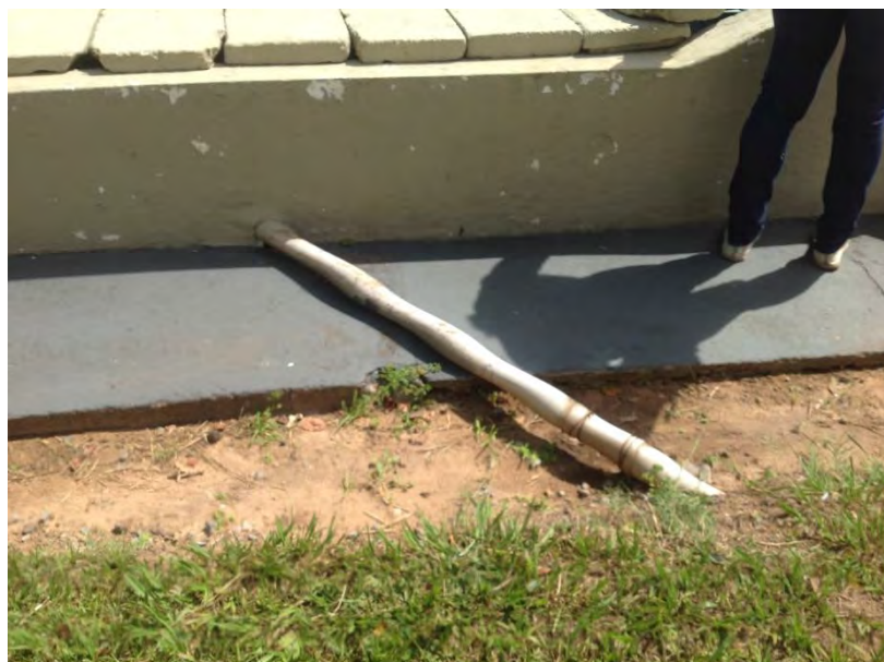
Figura 18: Entrada do líquido de descarga da caixa de areia no desarenador
