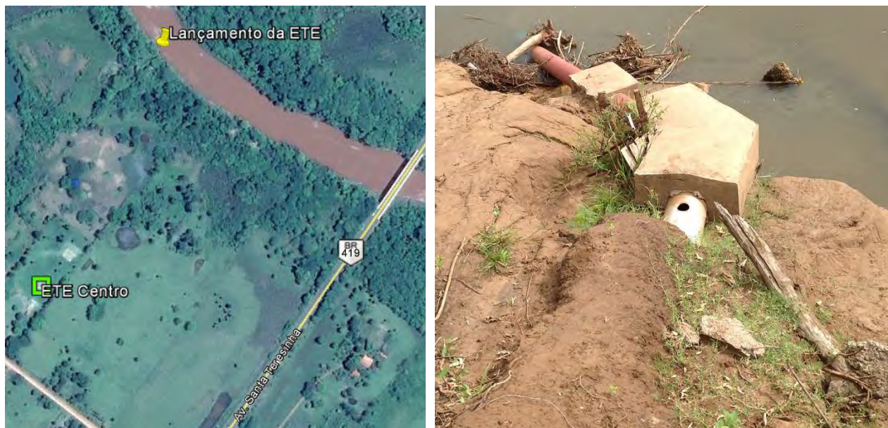
Figura 40: Ponto de lançamento do efluente da ETE Centro
