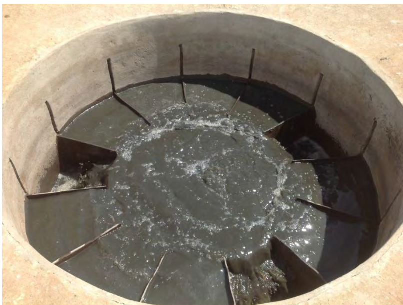
Figura 19: Entrada do reator
