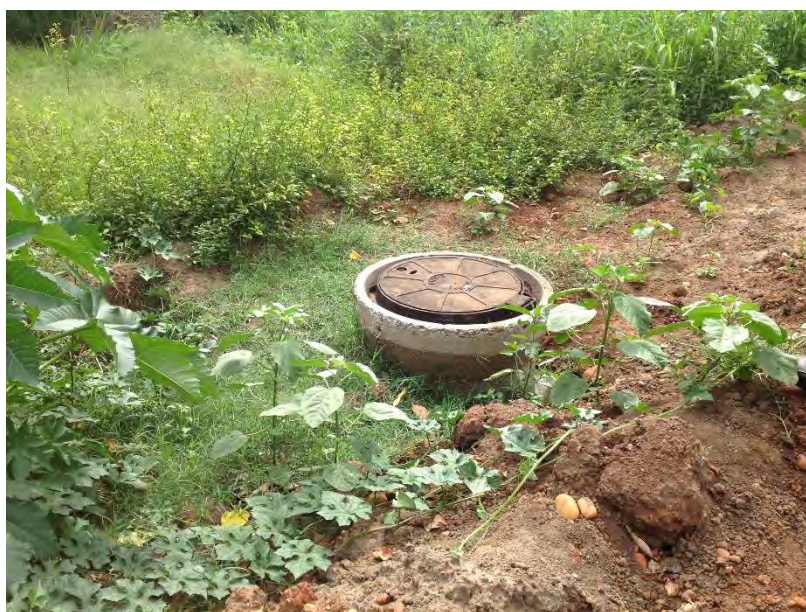
Figura 43: PV de chegada – EEEB-04
