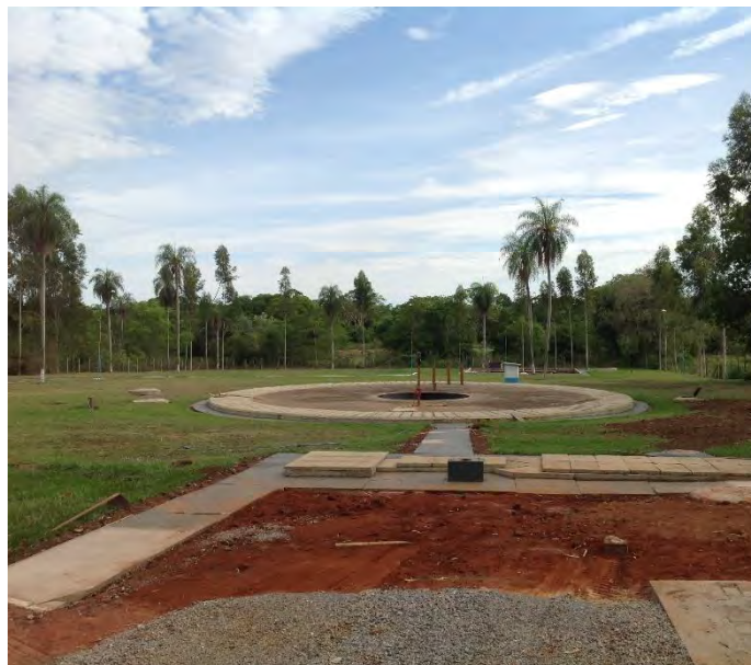
Vista geral do Ralf, cercamento e arborização da área
