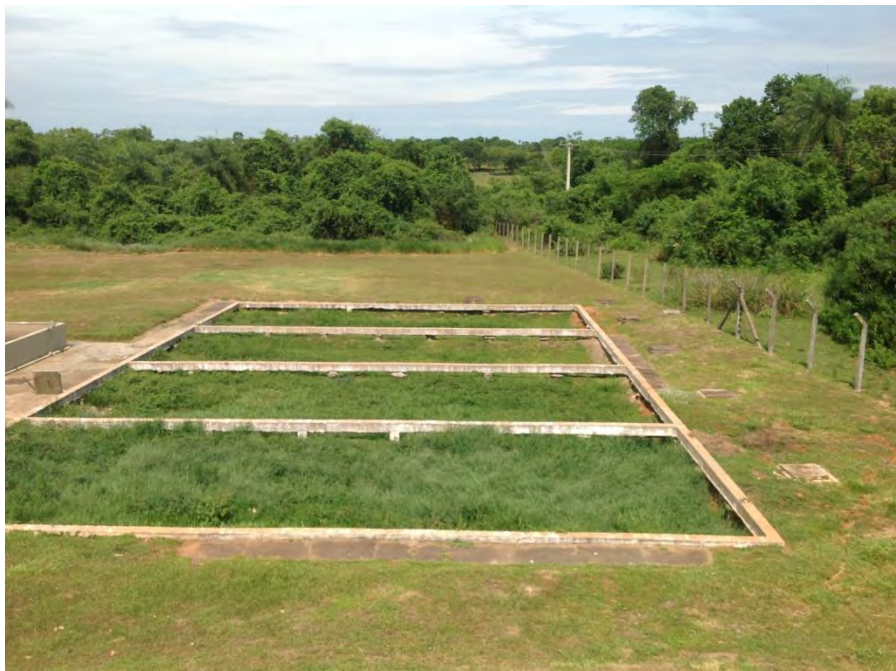
Figura 21: Tratamento complementar com plantas e areia (desativado)
