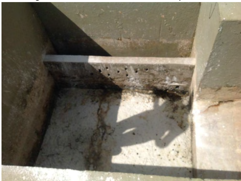
Figura 16: Caixa de areia
