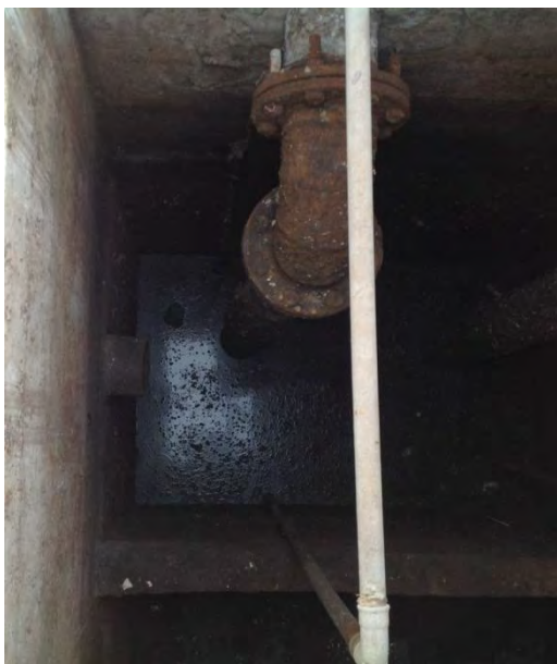
Poço de sucção
