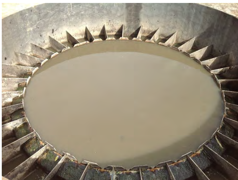
Figura 33: Entrada do reator
