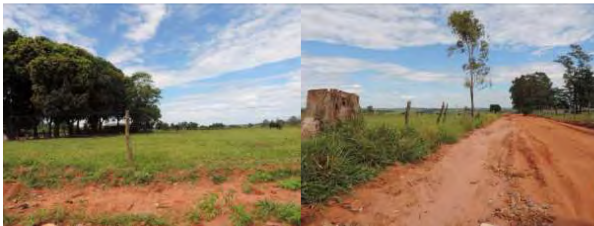
Figura 5: Vista geral da EEEB 001 Projetada, Japorã, MS.
