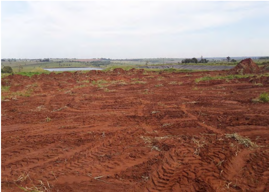
Figura 16: Limpeza do terreno para locação das unidades.
