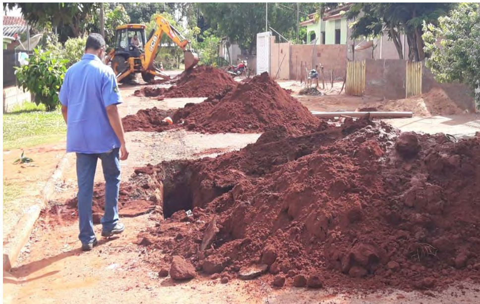
Figura 15: Obras dos ramais e redes coletora de esgoto.
