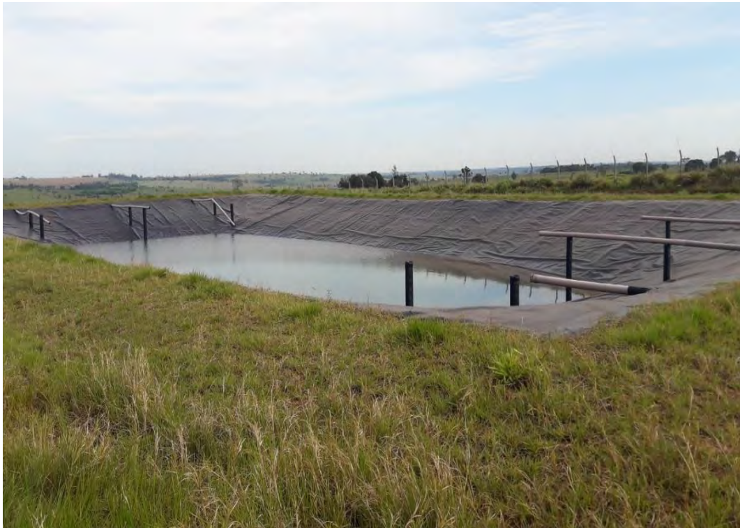
Figura 8: Lagoa Anaeróbia
