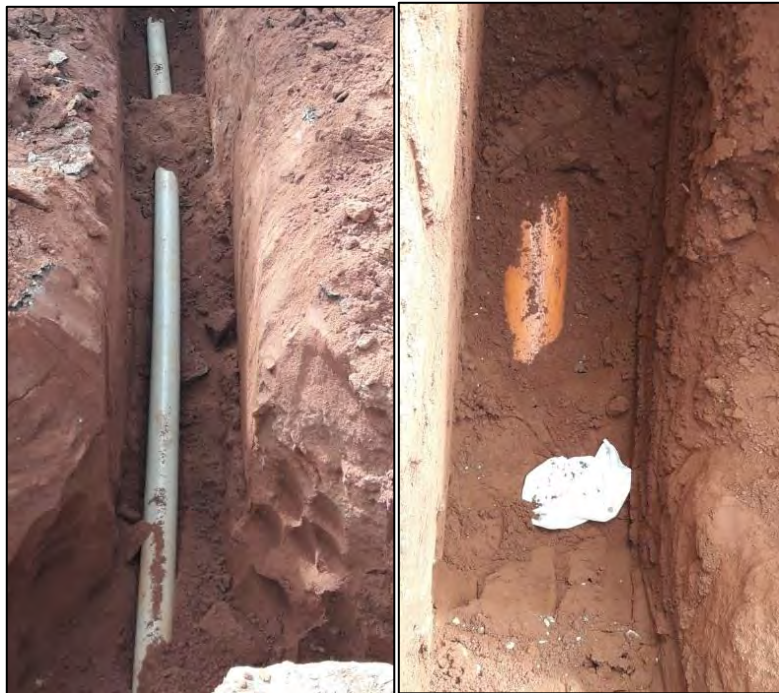
Figura 14: Ramais de ligação e redes de esgotamento sanitário em execução
