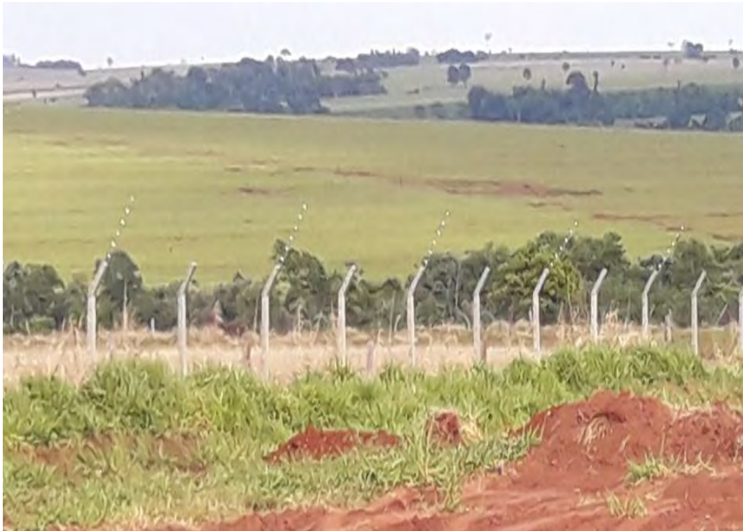
Figura 11: Vista do alambrado de fechamento.
