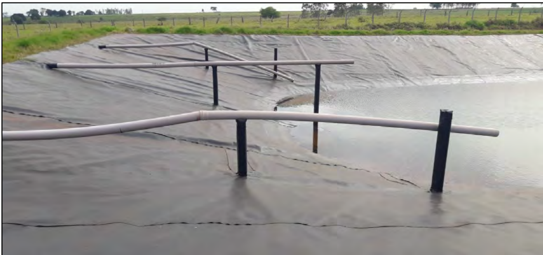
Figura 9: Dispositivos de saída lagoa Anaeróbia.
