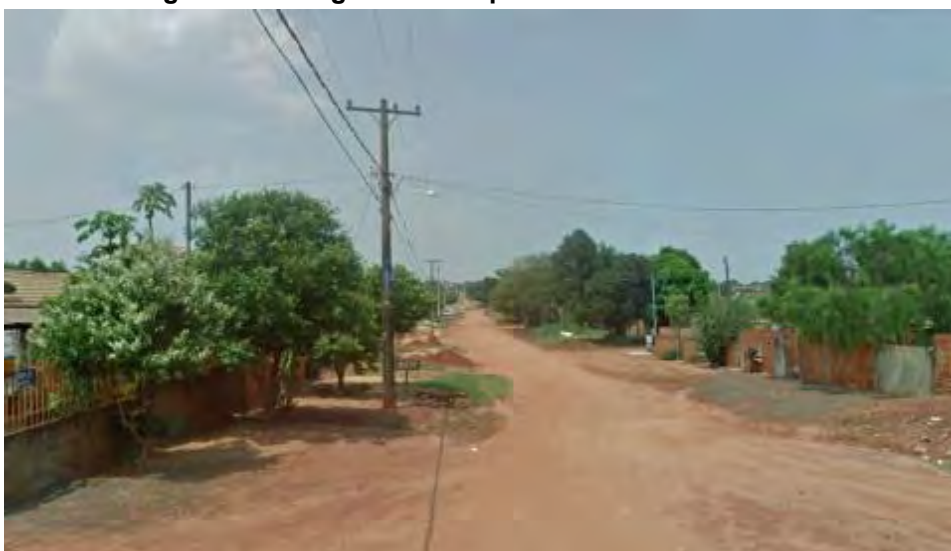
Figura 3: Vista geral da rua sem pavimento em Ivinhema.
