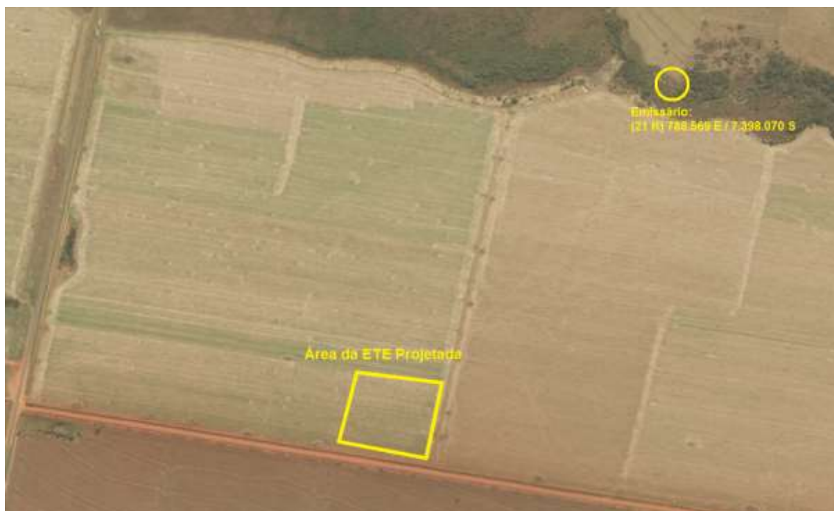
Figura 2: Vista da área pretendida para a ETE Itaquiraí Projetada e entorno, Itaquiraí, MS.
