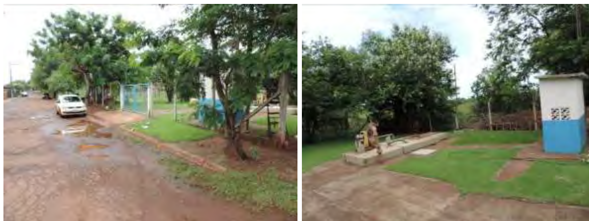
Figura 5: Vista geral da EEEB 007, Itaporã, MS.
