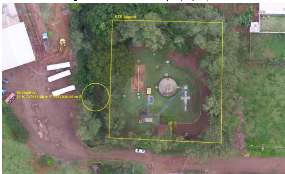
Figura 3: Vista aérea da ETE Itaporã e entorno, Itaporã, MS.
