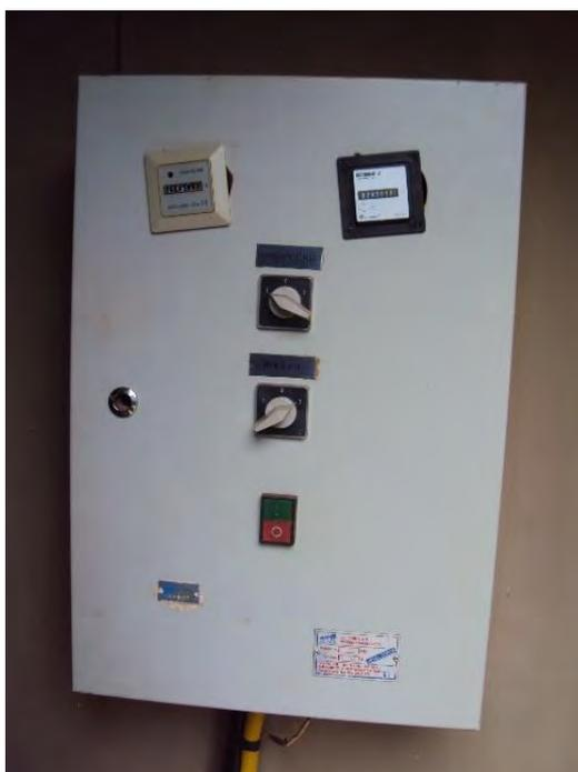
Figura 12: Painel de acionamento da Bomba EEB BNH, em Itaporã.
