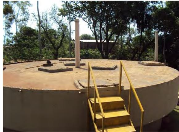
**Figura 28: Vista 2 do reator anaeróbico 5L/s na ETE Itaporã.**
