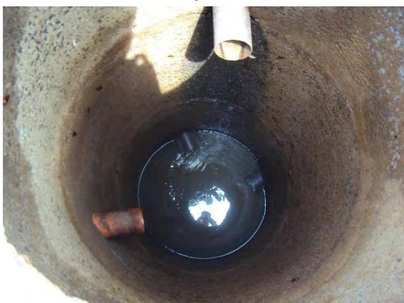
**Figura 15: Poço de visita a montante da EEEB Pátio ETE, em Itaporã.**
