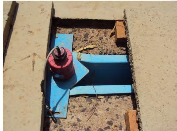
Figura 25: Vista do Medidor de vazão ultrassônico existente na ETE Itaporã.
