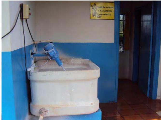
**Figura 21: Vista do agitador e da bomba dosadora de cal, em Itaporã.**
