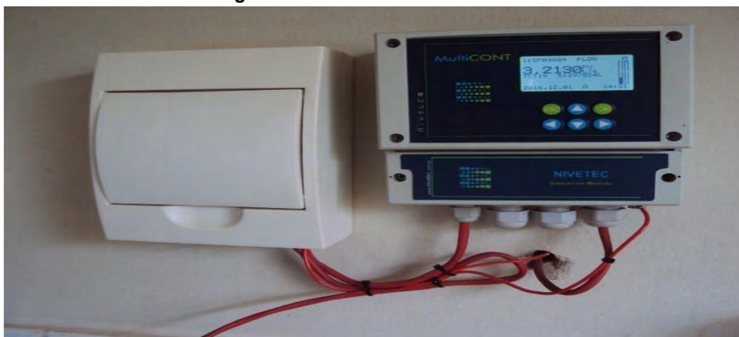
**Figura 32: Vista do medidor de vazão ultrassônico NIVITEC, medindo na hora da visita, 3,21 L/s de vazão de entrada, em Itaporã.**
