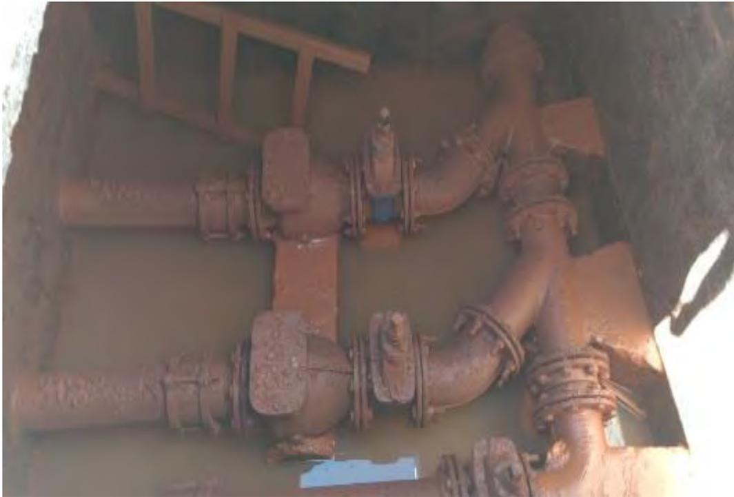
**Figura 8: Caixa do Barrilete com presença de água da chuva.**
