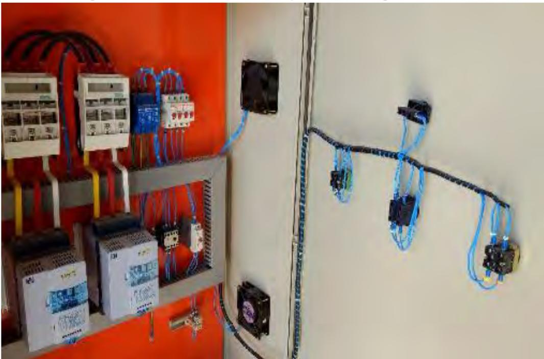
**Figura 9: Quadro de comando com soft starter.**
