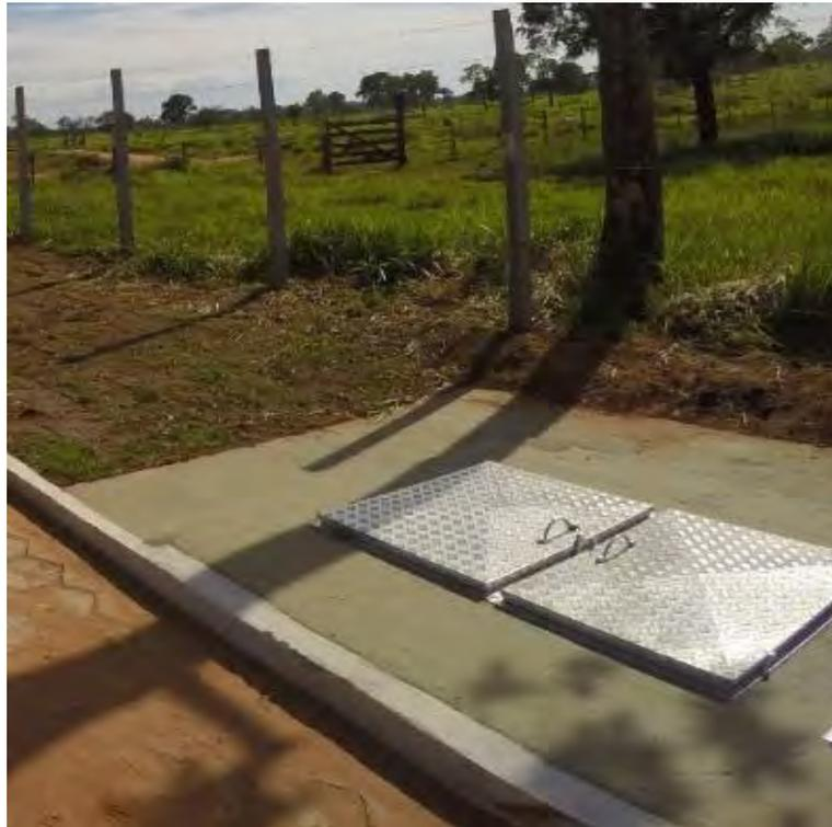
**Figura 13: Caixa para descarga do caminhão limpa fossa.**
