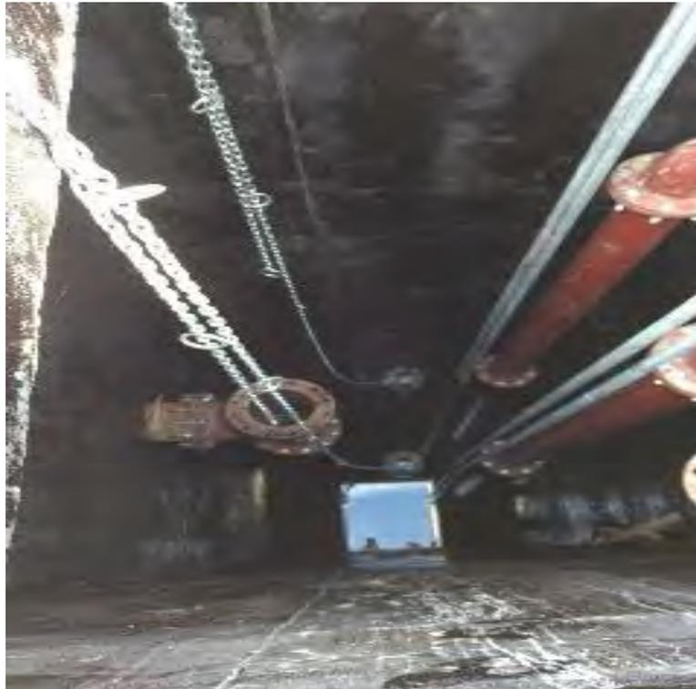
**Figura 15: Poço de Sucção.**
