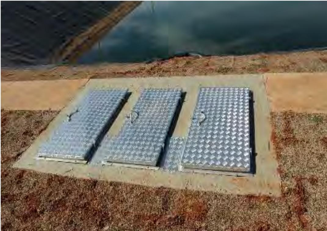
**Figura 24: Caixa de Distribuição para a Lagoa Anaeróbia.**
