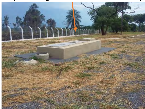
Figura 21: Caixa Auto-fossa na ETE Guia Lopes da Laguna.
