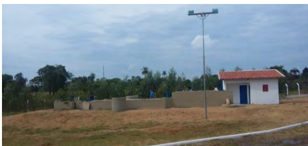
Figura 11: Vista do tratamento preliminar e estrutura auxiliar na ETE Guia Lopes da Laguna.
