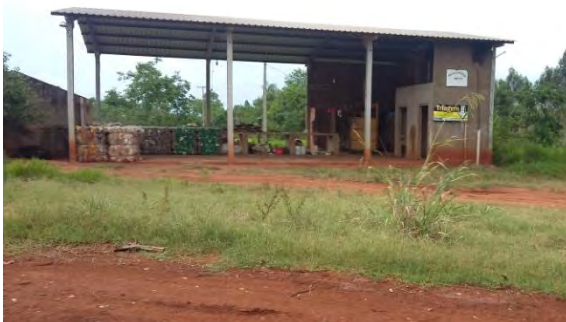
Figura 27: Área para compactação do aterro controlado de Guia Lopes da Laguna.
