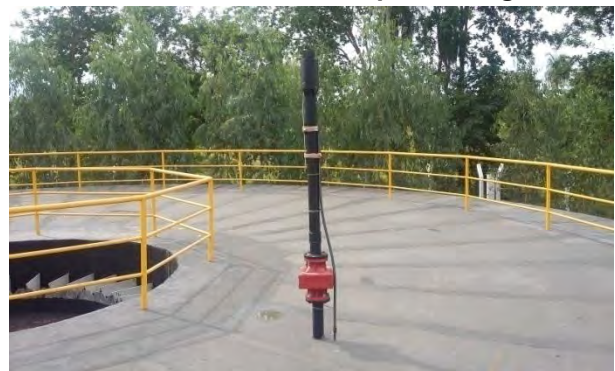
Figura 15: Queimador do RALF na ETE Guia Lopes da Laguna.
