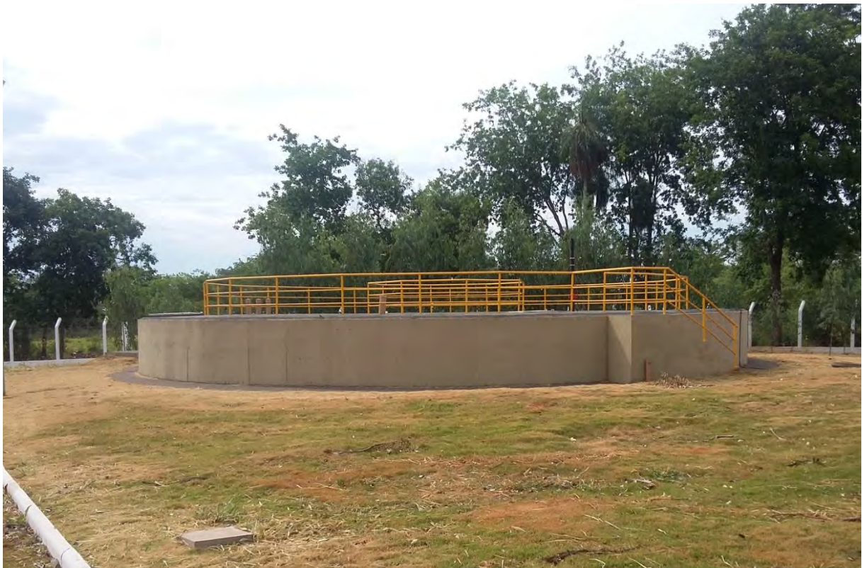
Figura 13: Reator Anaeróbico de Lodo Fluidizado – RALF na ETE Guia Lopes da Laguna.
