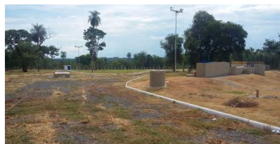
Figura 12: Tratamento preliminar ao lado direito, na ETE Guia Lopes da Laguna.
