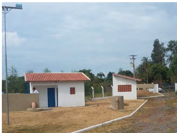
Figura 17: A esquerda a estrutura para o Laboratório, e a direita o abrigo para o grupo gerador da ETE Guia Lopes da Laguna.
