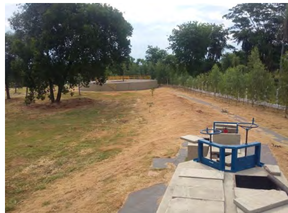
Figura 10: Calha Parshall e caminhamento para o RALF na ETE Guia Lopes da Laguna.
