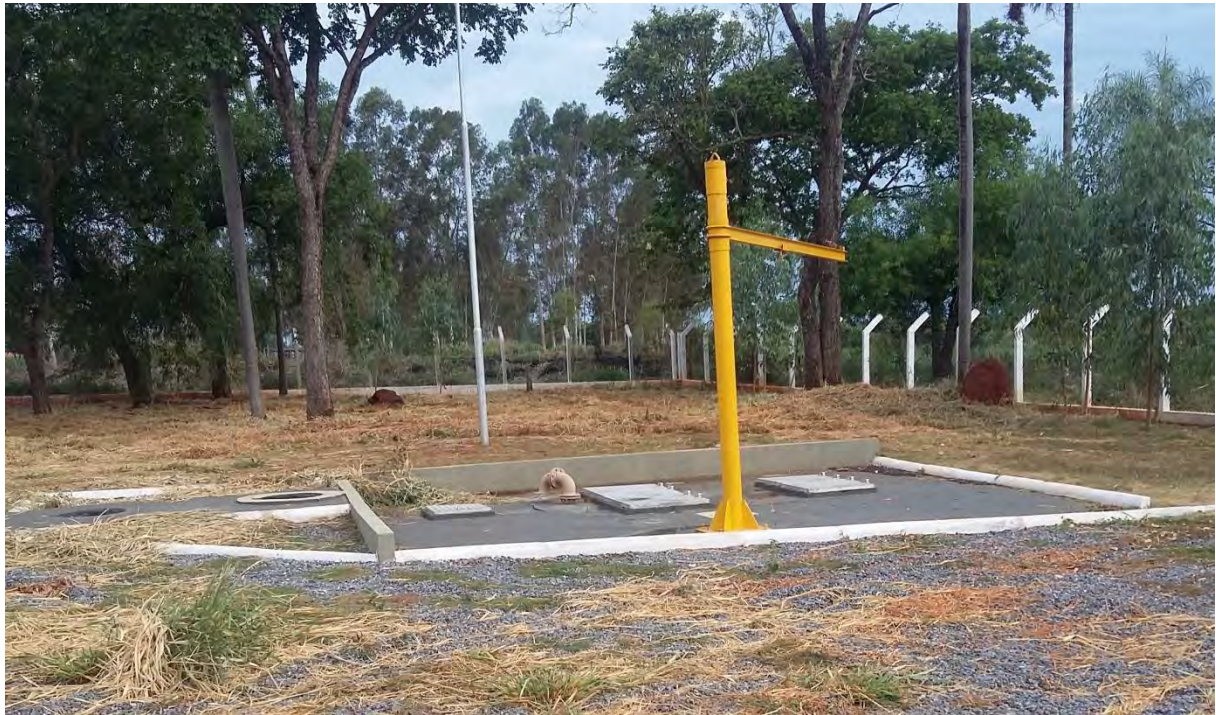
Figura 4: Vista da Estação Elevatória final na área da ETE Guia Lopes da Laguna.
