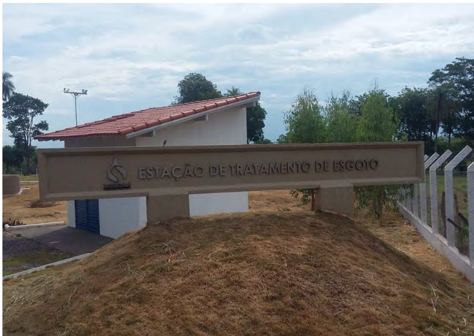
Figura 5: Entrada da ETE – Guia Lopes da Laguna.
