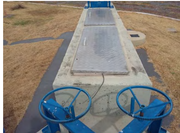
Figura 8: Stop-Log entre a caixa de entrada e os desarenadores na ETE Guia Lopes da Laguna.
