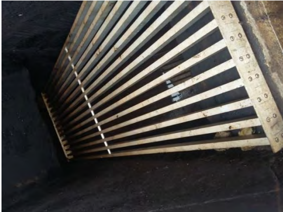
Figura 7: Gradeamento da caixa divisora de vazão na ETE Guia Lopes da Laguna.
