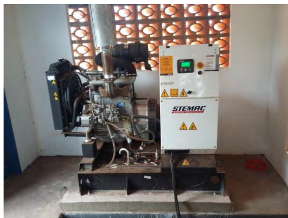
Figura 20: Grupo Gerador instalado na ETE Guia Lopes da Laguna.
