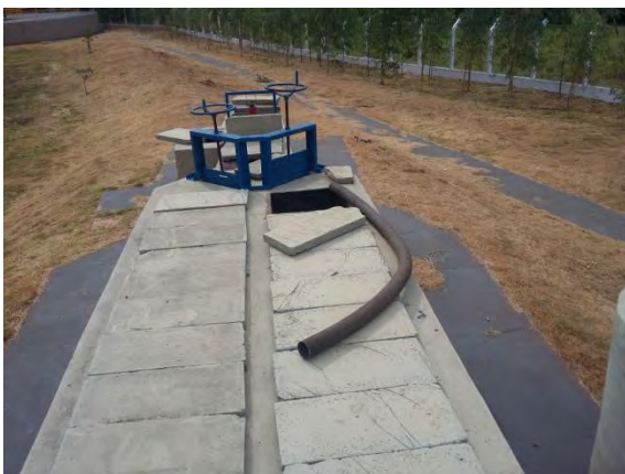
Figura 9: Desarenadores e Stop-Log entre calha Parshall e os desarenadores na ETE Guia Lopes da Laguna.
