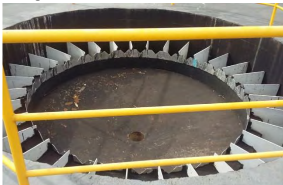
Figura 14: Vertedor Central do RALF na ETE Guia Lopes da Laguna.
