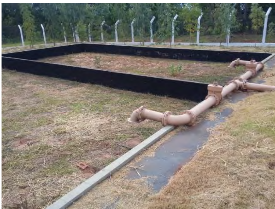
Figura 16: Leitos de Secagem na ETE Guia Lopes da Laguna.
