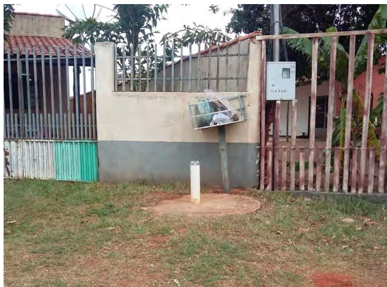
Figura 2: Vista de uma Fossa no passeio da cidade de Guia Lopes da Laguna.
