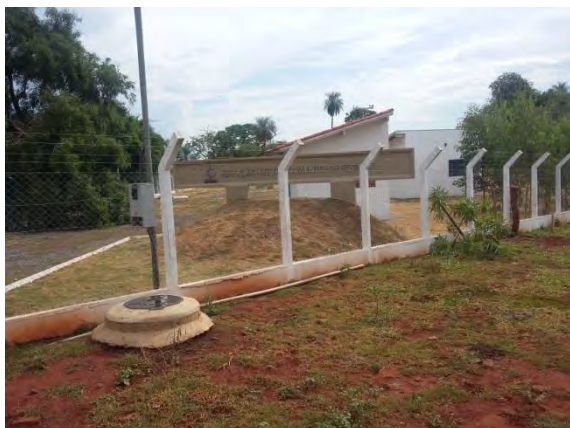
Figura 22: Cercado da área da ETE Guia Lopes da Laguna.
