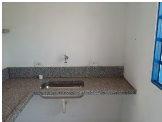
Figura 18: Interior do Laboratório da ETE Guia Lopes da Laguna.
