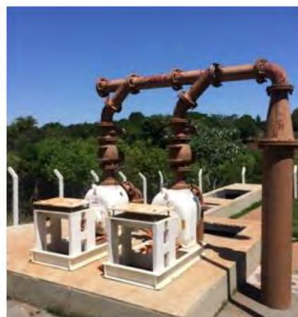
**Poço de Sucção / Bombas Re-Autoescorvantes / Barrilete de recalque**
