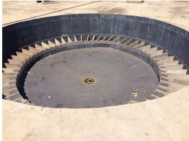
**Figura 35: Câmara central divisora de vazão (RALF)**
