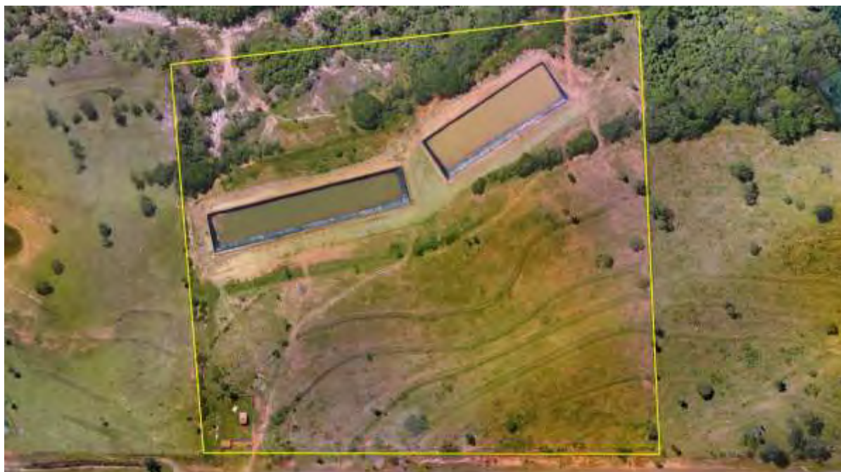
Figura 2: Vista aérea da ETE Figueirão, Figueirão, MS.
