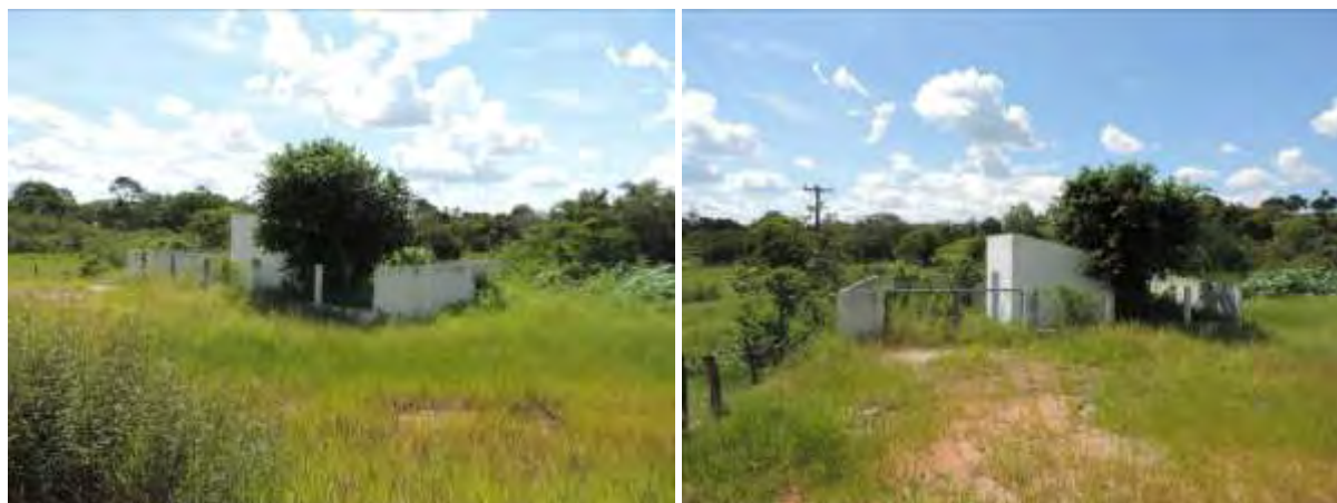
Figura 5: Vista geral da EEEB 001, Figueirão, MS.
