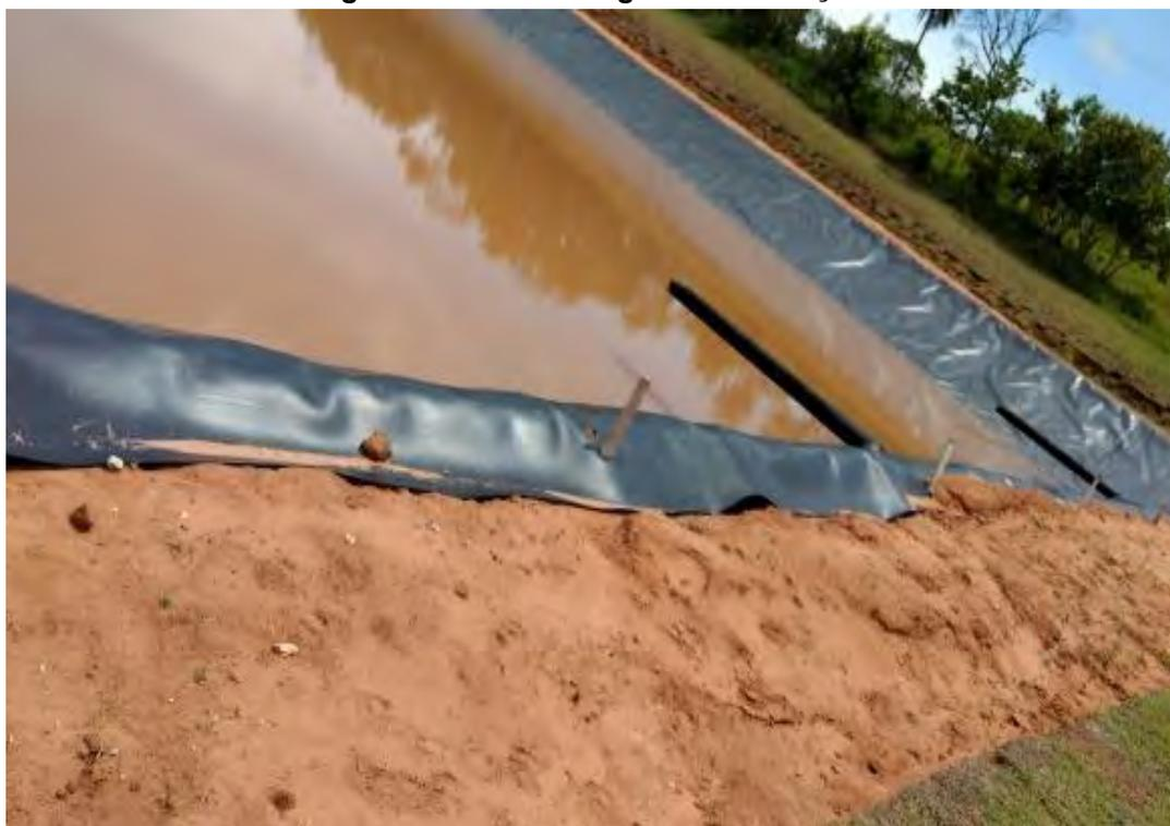
**Figura 17: Detalhe da fixação da manta PEAD.**
