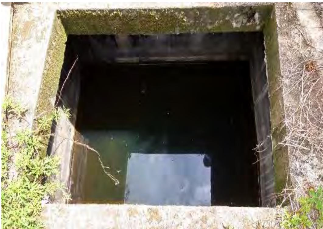
**Figura 6: Acumulo de água no poço da EEEB.**
