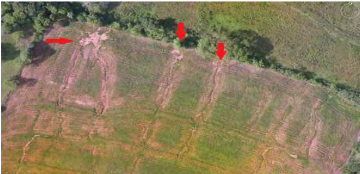
Figura 11: Início de processos erosivos na área pretendida para a ETE Fátima do Sul Projetada, Fátima do Sul, MS.
