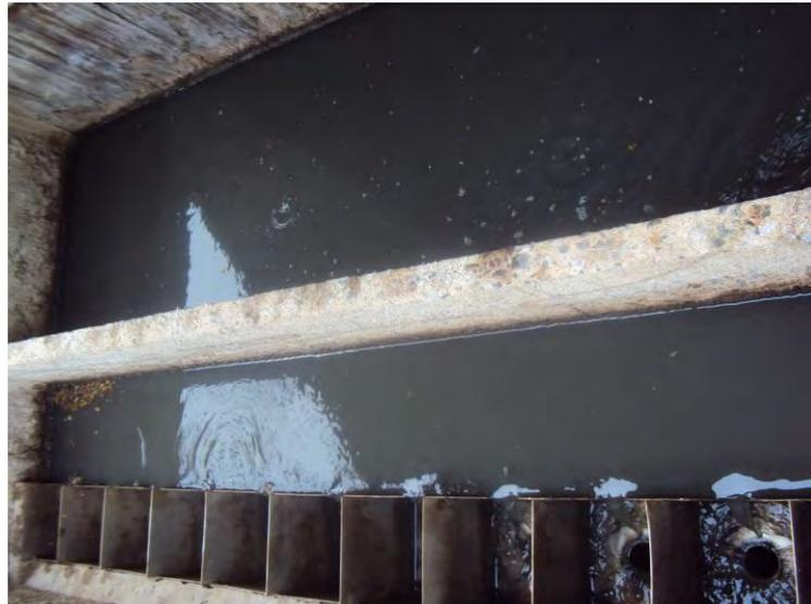
**Figura 20: Vertedores do reator anaeróbio da ETE de Fátima do Sul.**
