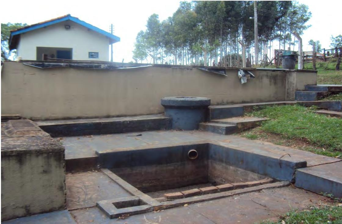
**Figura 23: Caixa de areia e Laboratório (ao fundo) – ETE Fátima do Sul.**
