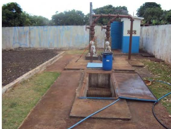
**Figura 9: Vista do gradeamento, barrilete e abrigo de quadro de comando.**
