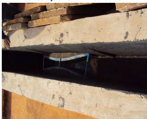
Figura 21: Detalhe da calha Parshall em instalação na ETE Douradina.
