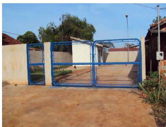
Figura 5: EEEB - 001 de Douradina - portão de acesso.
