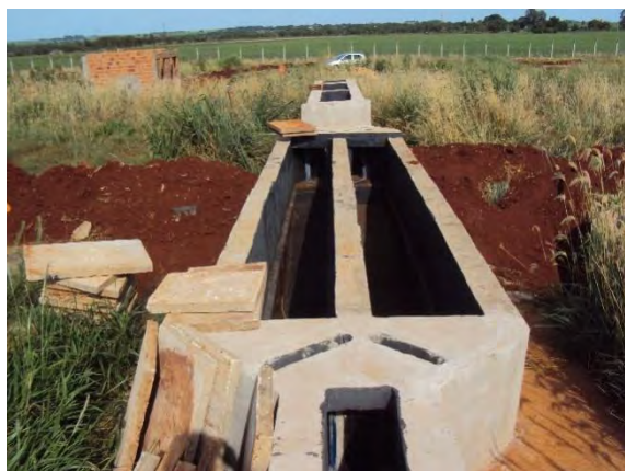
Figura 19: Vista do desarenador em construção na ETE Douradina.
