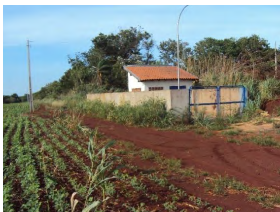
Figura 13: Vista geral EEEB 002 em Douradina.
