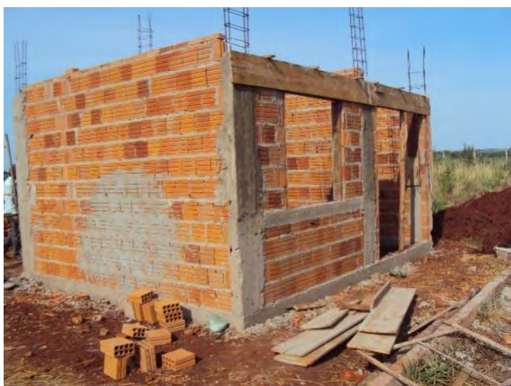
Figura 27: Vista da construção do novo laboratório da ETE Douradina.
