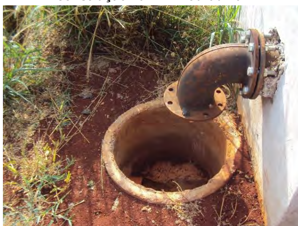
Figura 22: Vista de poço de descarga de areia na ETE Douradina.
