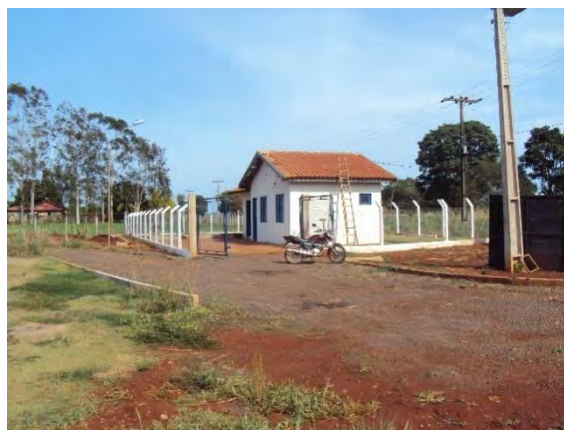
Figura 28: Vista do laboratório existente na ETE Douradina.
