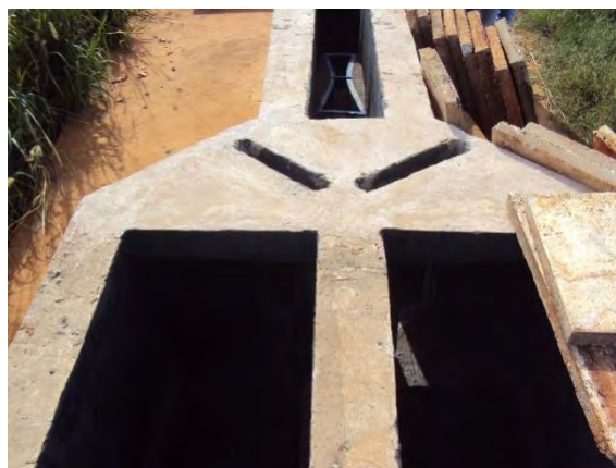
Figura 20: Detalhe do desarenador em construção na ETE Douradina.
