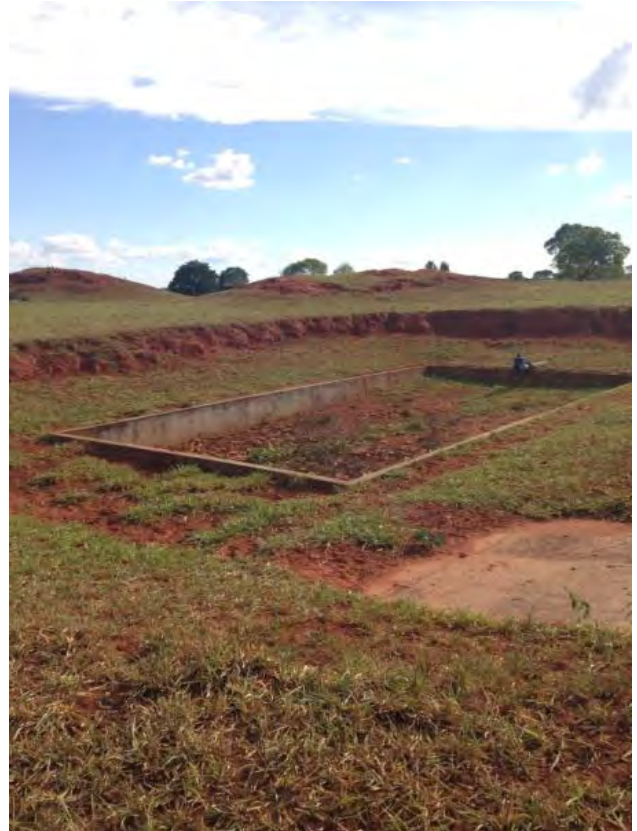
Inclinação de taludes 45° favorece o acúmulo de água estagnada.
