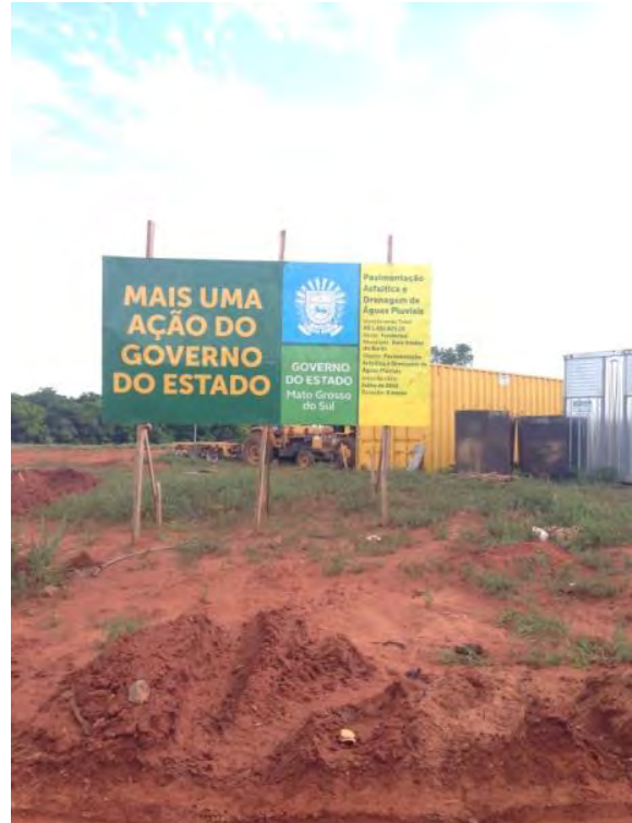
Placa de Obras de Pavimentação & Drenagem
