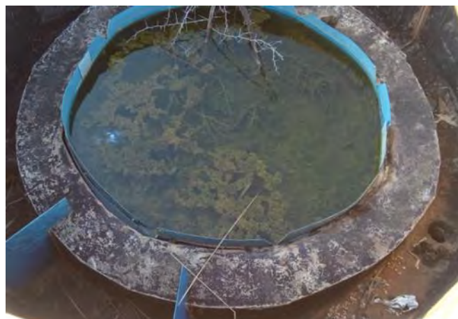
Vertedor central danificado
