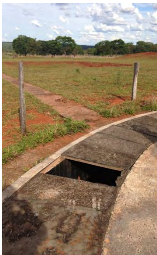
Placas de fechamento em concreto
