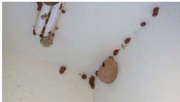
Foco de insetos (abelhas) no teto
