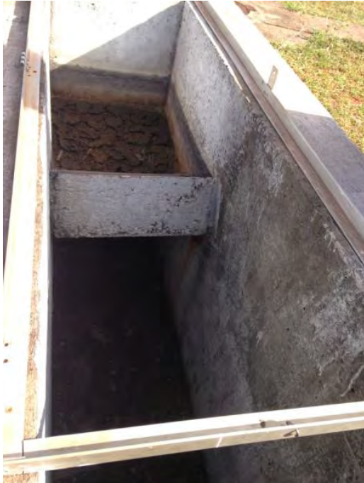
Gradeamento: ausência de grades
