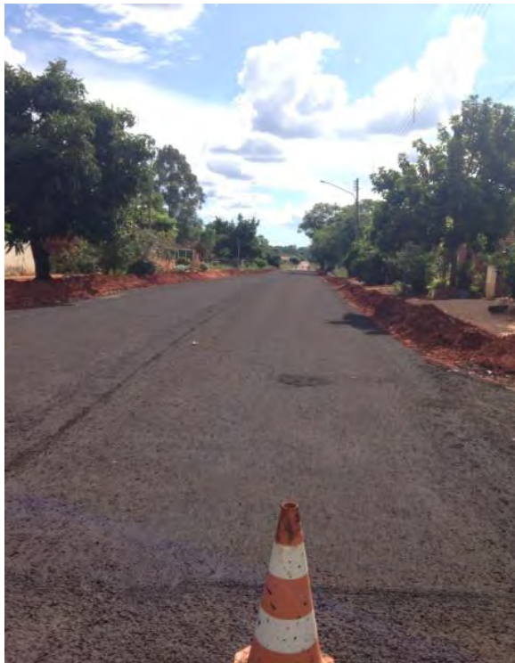
Obras de pavimentação e drenagem em andamento.
