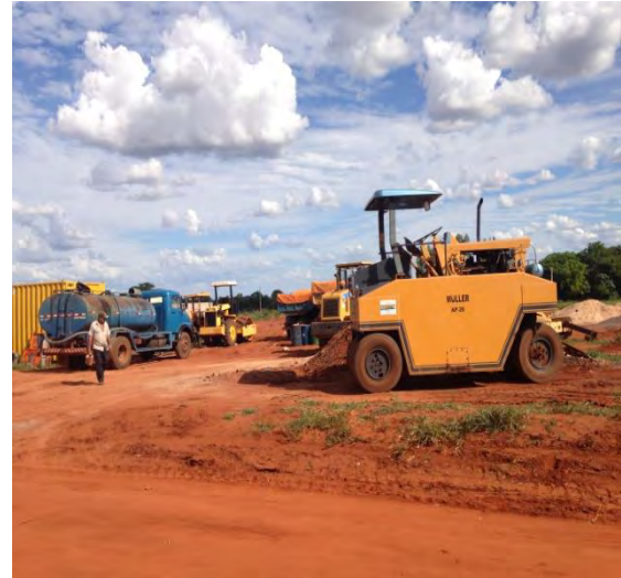
Canteiro de obras pavimentação
