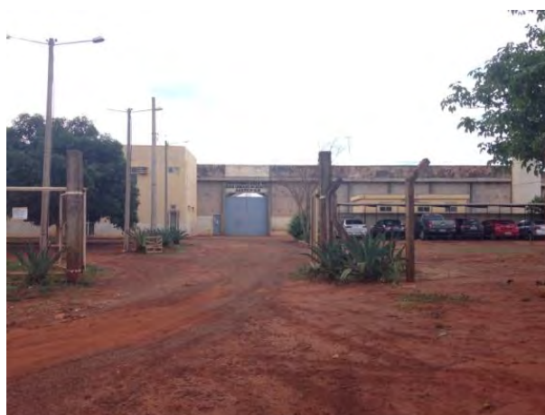
Fachada do presídio
