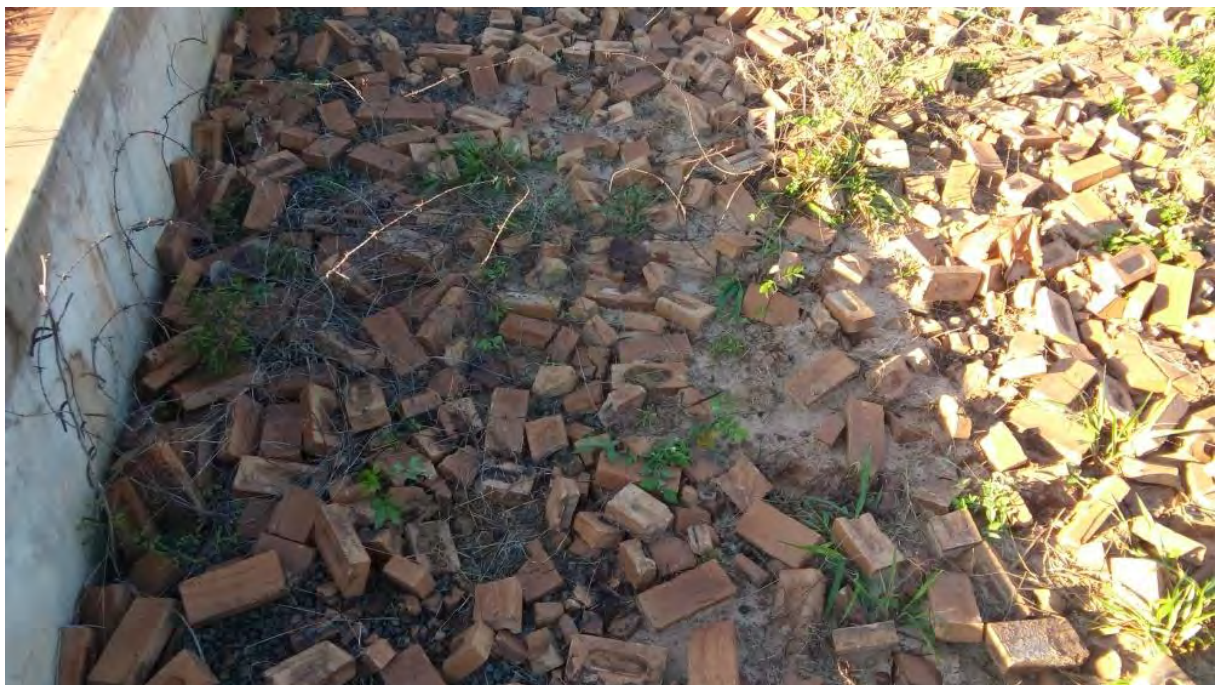
Leito de secagem, estado de conservação deficiente
