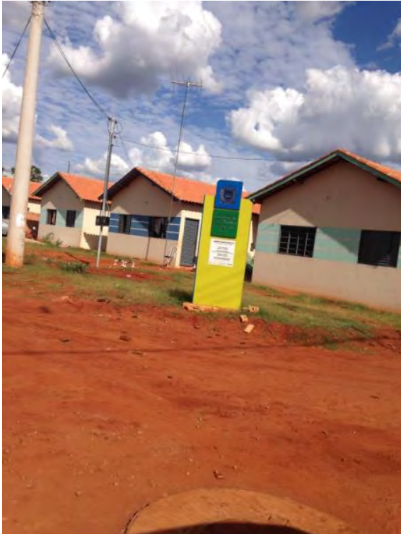
Obra do Conjunto Habitacional Jardim Aeroporto II
