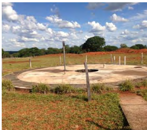
Reator RALF, cilíndrico, enterrado
