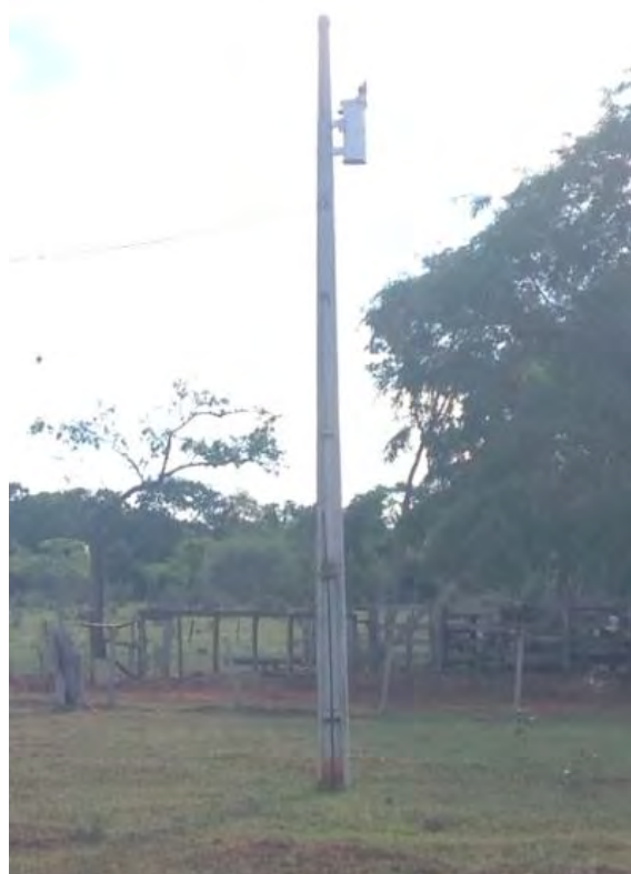
Rede elétrica da ETE Dois Irmãos do Buriti
