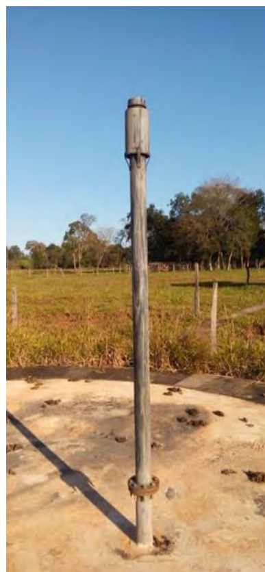
Queimador de gás em estado de oxidação
