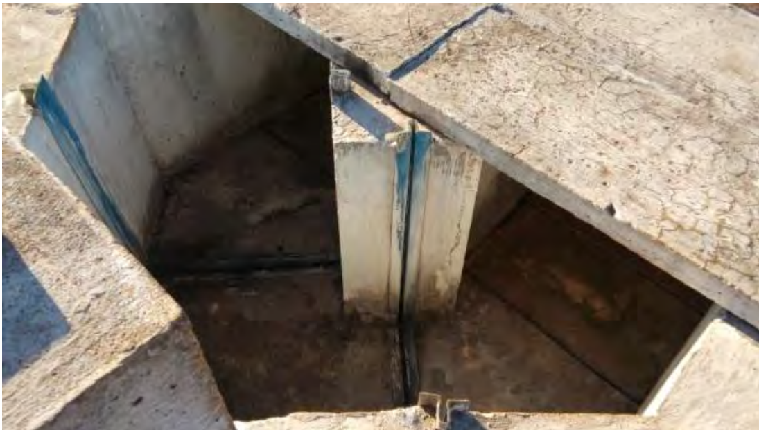
Saída do desarenador, ausência de comportas
