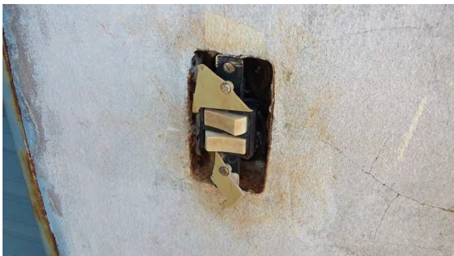
Instalações elétricas em más condições.
