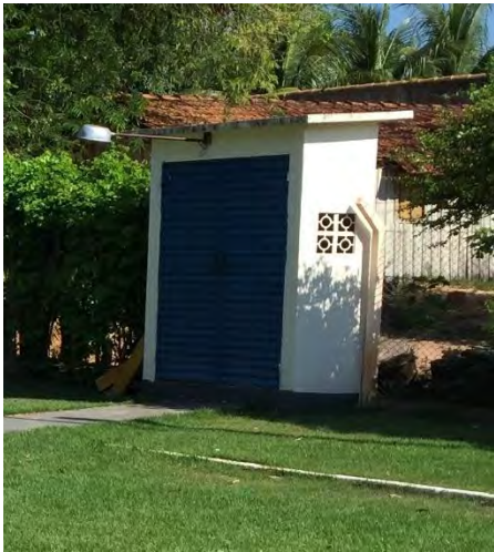
Quadro de comando (Vista externa)
