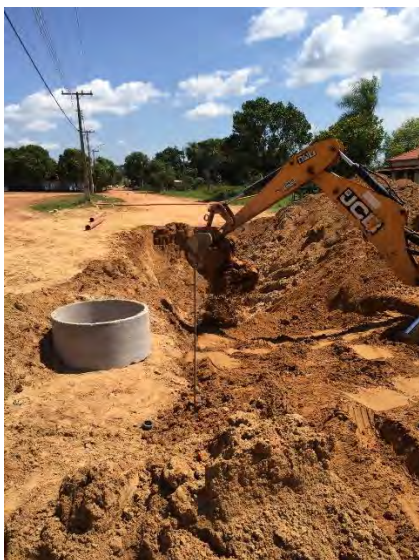
Obra de rede coletora na Vila São Paulo.
