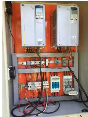
Quadro de comando (Vista interna)
