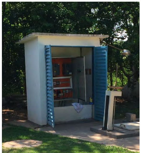
Quadro de comando (Vista externa)
