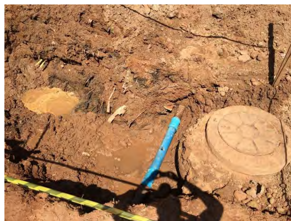
Chegada da linha de recalque em frente a EEEB Lagoa Dourada.
