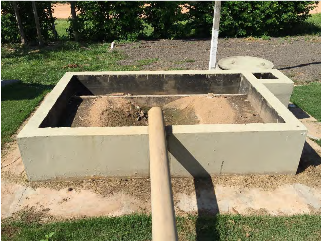
Figura 10: Caixa para acúmulo e secagem de areia.
