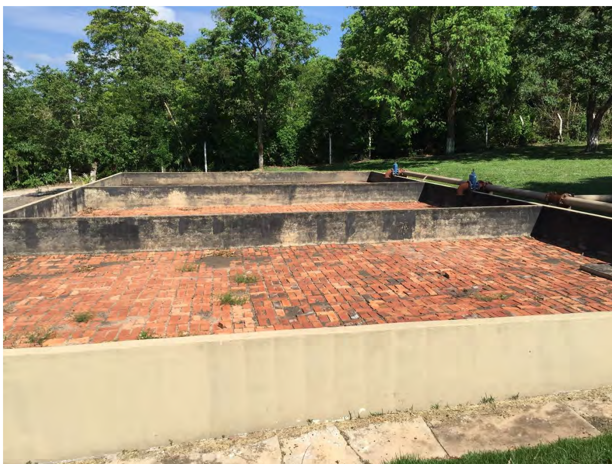
Figura 14: Leitos de secagem
