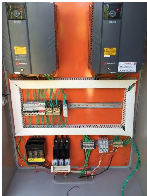
Quadro de comando (Vista interna)
