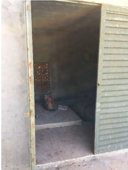
Vista interna abrigo do gerador (EEEEB Lagoa Dourada)
