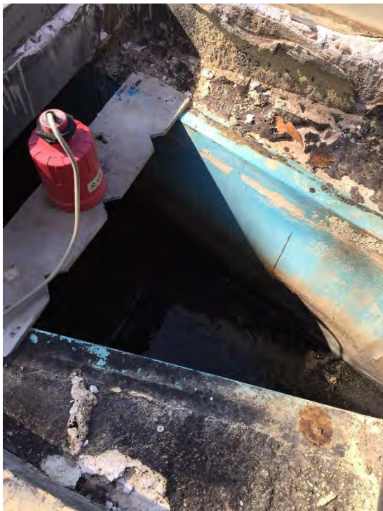
Calha parshall com medidor ultrassônico
