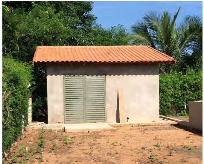
Vista externa abrigo do gerador (EEEEB Santa Maria)
