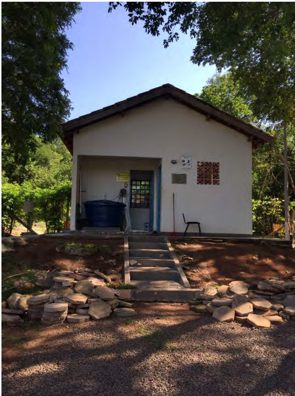
Figura 15: Sala de operação
