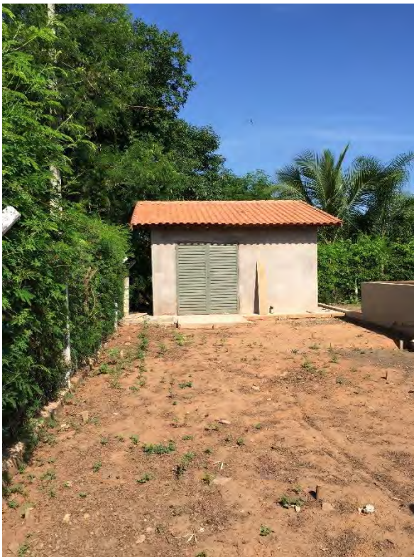
Abrigo do gerador (em implantação)
