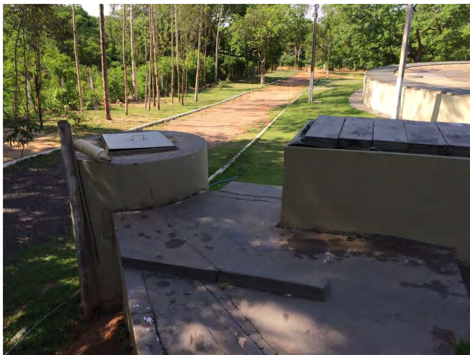
Figura 8: PV de entrada da ETE Coxim.
