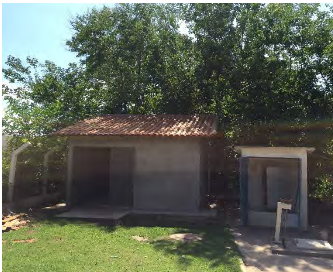
Abrigo do gerador (em implantação)
