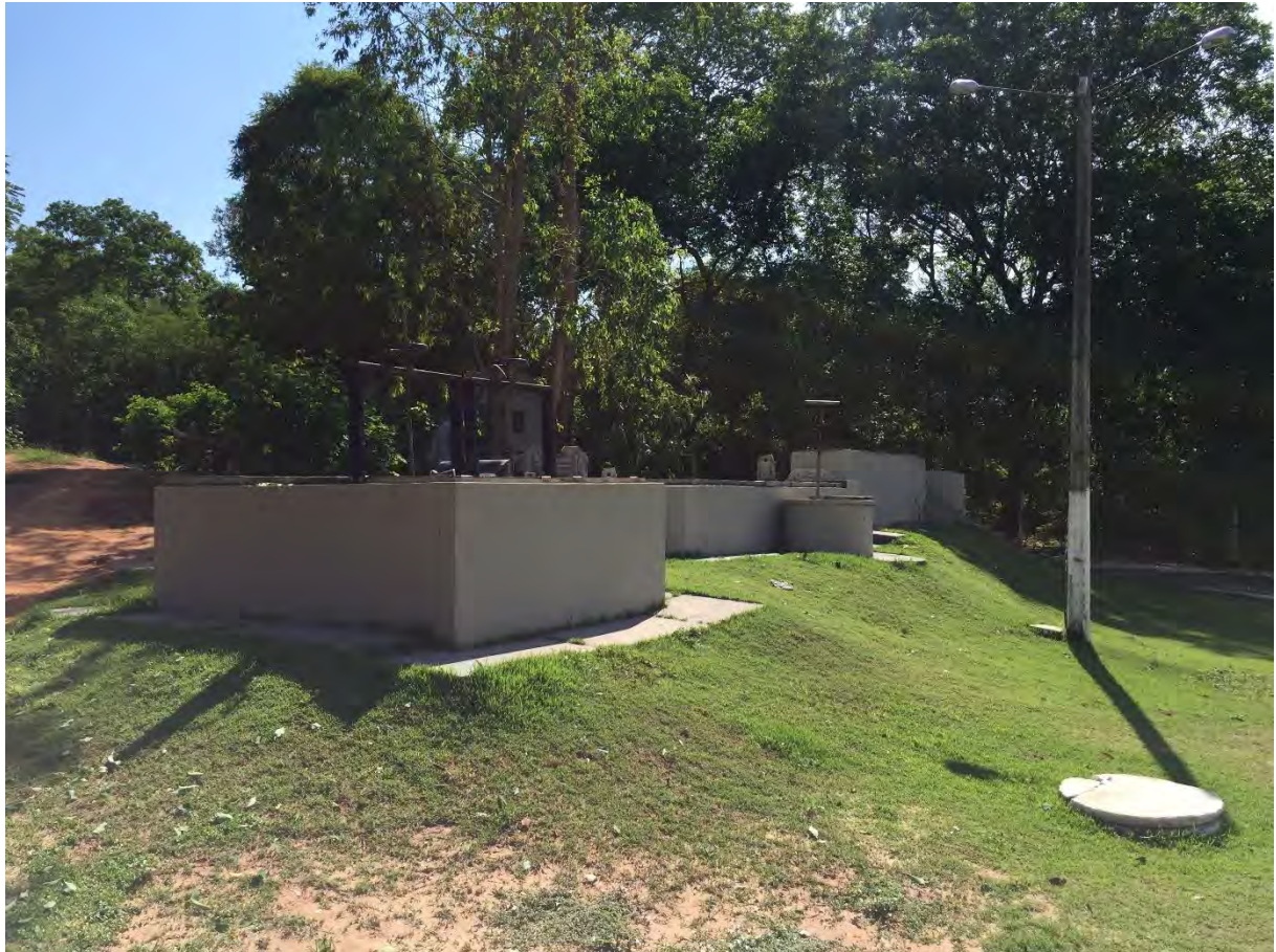
Figura 11: Caixa para acúmulo e secagem de areia.
