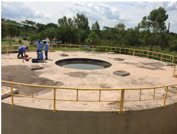
Queimador de gases em manutenção.
