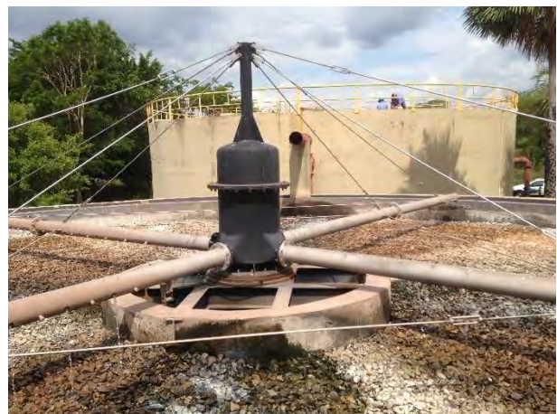
Detalhe da camada suporte e distribuidor de vazão.
