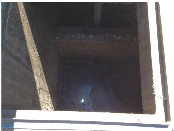
Vista interna do poço de sucção
