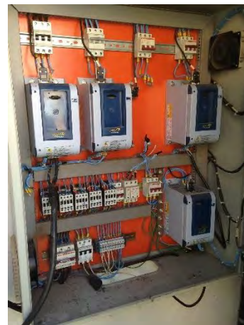
Painel de comando
