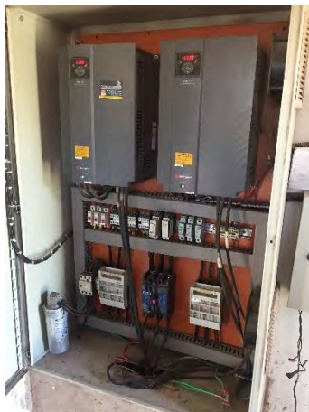
Quadro de comando
