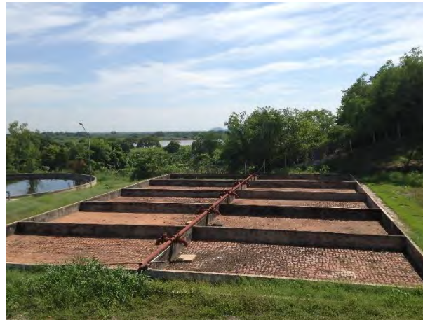
Figura 36: Vista superior do leito de secagem.
