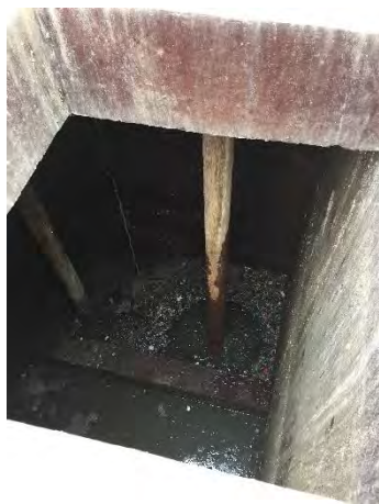
Vista interna do poço de sucção
