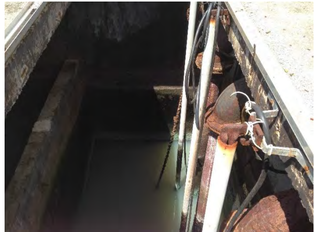
Vista interna do poço de sucção
