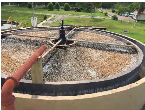
Vista superior do FBP – distribuidor de vazão está estático no momento da foto.
