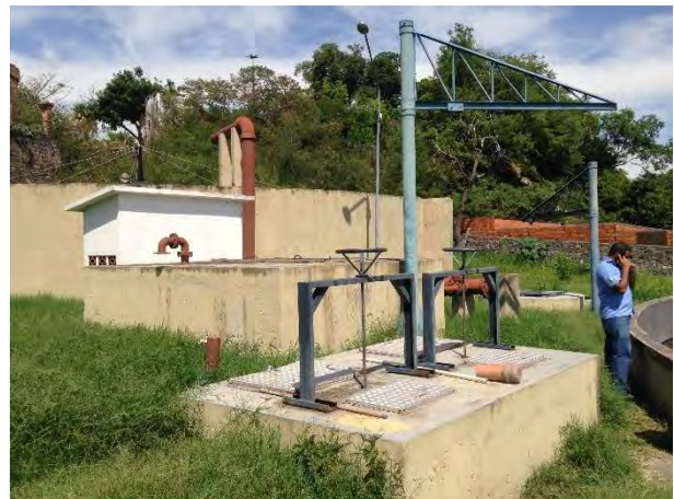
Detalhe da caixa divisora de fluxo
