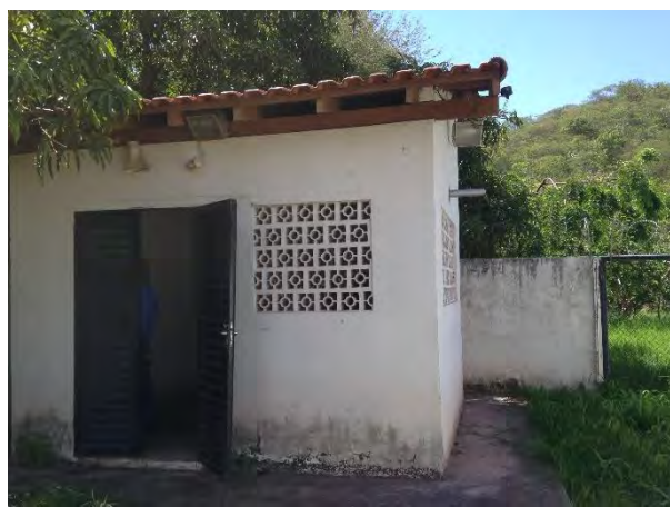
Abrigo do gerador e quadro de comando
