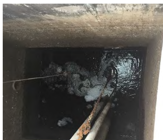
Vista interna do poço de sucção.
