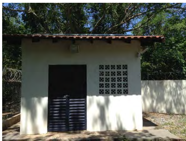
Abrigo do gerador e quadro de comando
