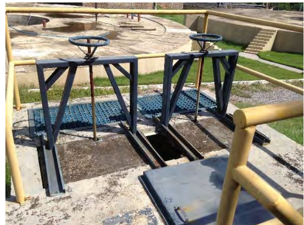
Distribuidor de vazão
