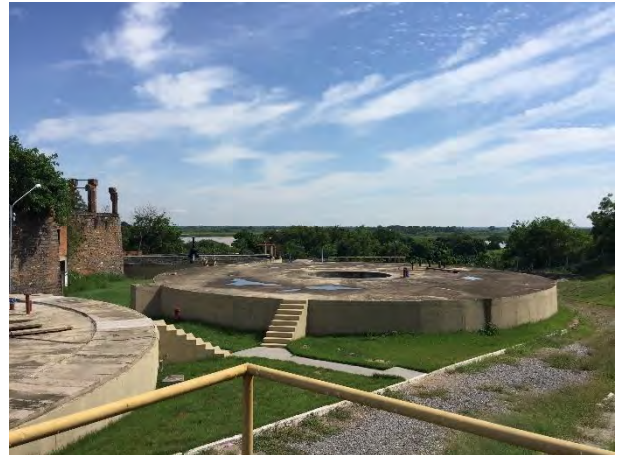
Vista superior do UASB.
