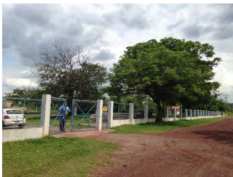
Figura 28: Urbanização da ETE Maria Leite.
