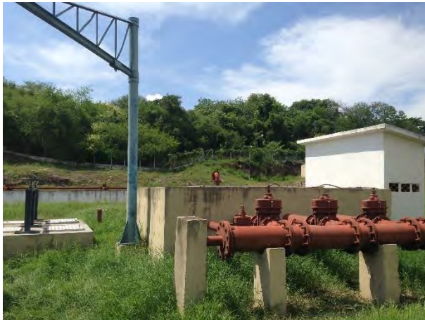
Estação elevatória de esgoto
