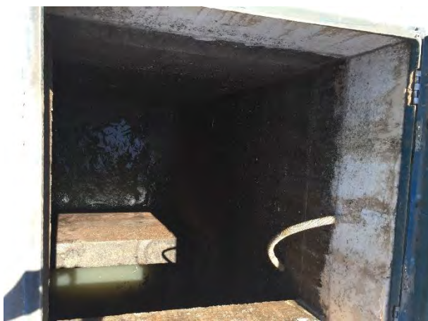
Vista interna do poço de sucção
