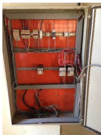
Quadro de comando
