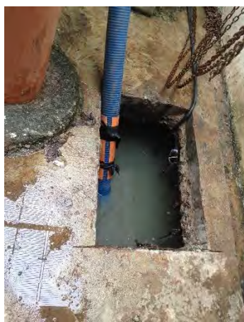
Vista interna do poço de sucção
