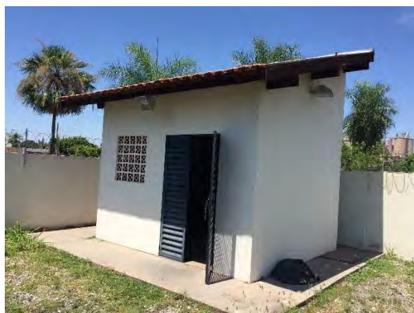
Abrigo do gerador e quadro de comando
