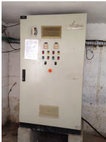
Quadro de comando
