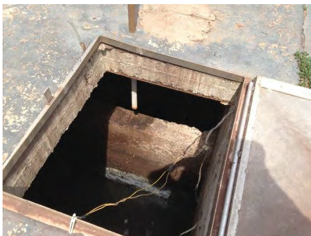
Vista interna do poço de sucção
