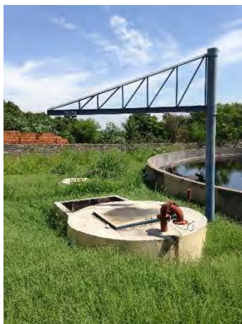
Elevatória de lodo – vista superior Elevatória de Lodo – poço de Sucção
