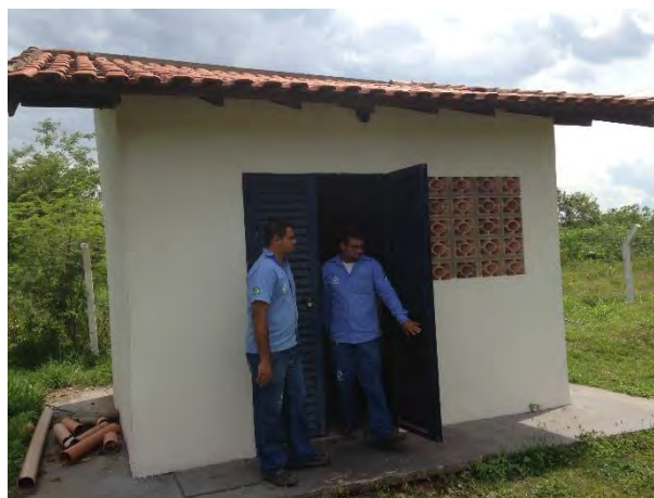
Abrigo do gerador e quadro de comando
