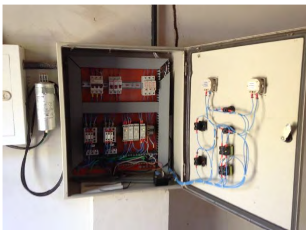
Quadro de comando
