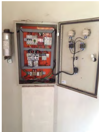
Quadro de comando
