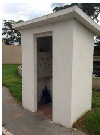
Quadro de comando
