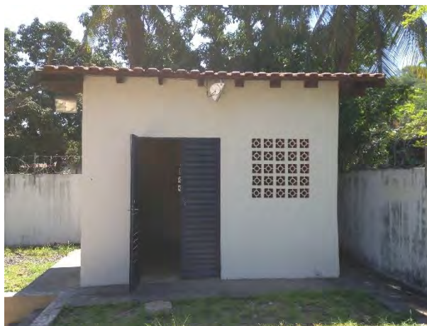
Abrigo do gerador e quadro de comando
