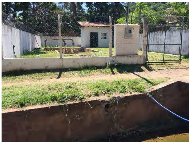
Vista externa / saída do extravasador
