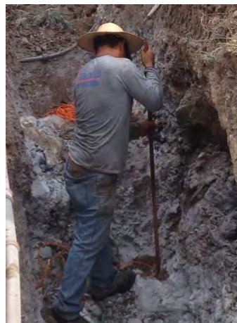
Desmonte com explosivos
