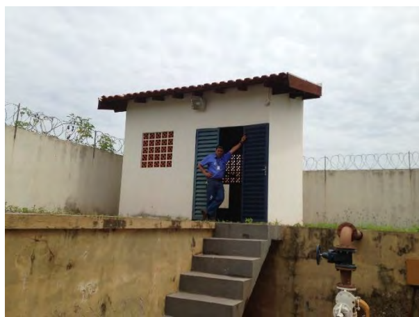
Abrigo do gerador e quadro de comando
