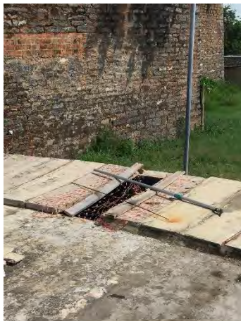
Placa de concreto danificada
