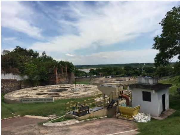
Vista geral do tratamento.
