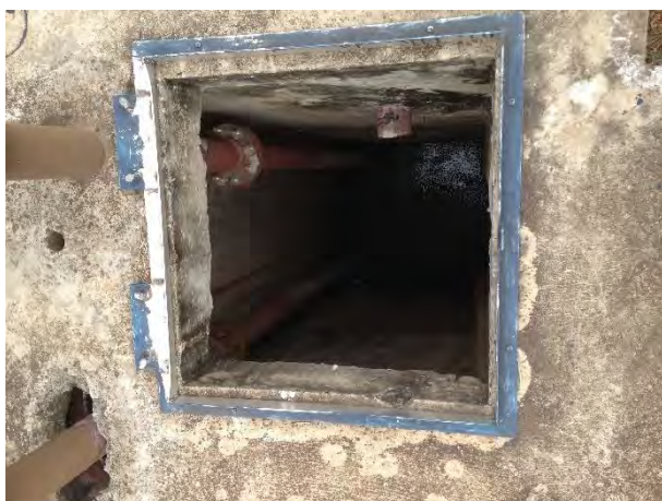
Vista interna do poço de sucção
