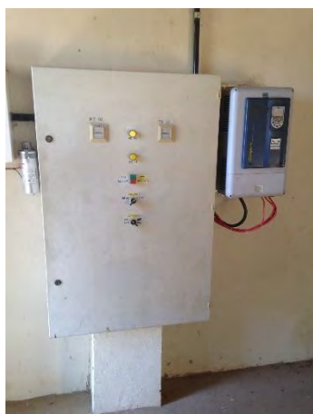
Quadro de comando
