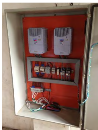
Quadro de comando
