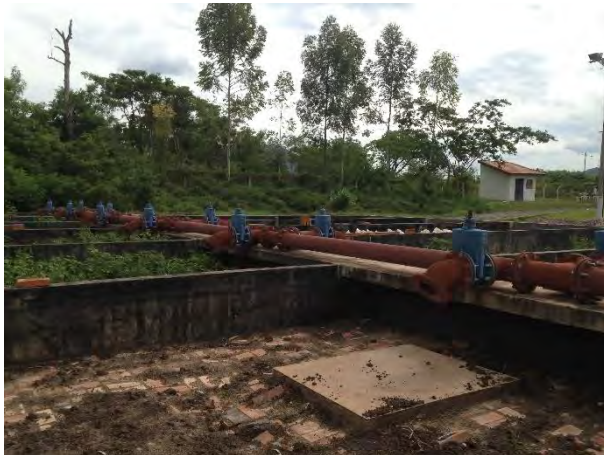
Elevatória de lodo – vista superior
