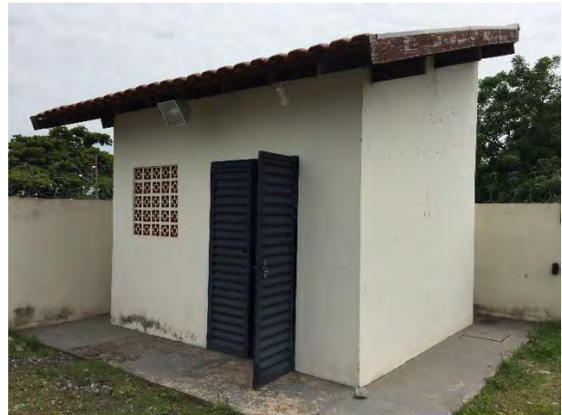
Abrigo para gerador e quadro de comando
