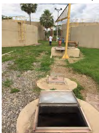
Poço de reunião de espuma e poço de reunião de lodo do DS.
