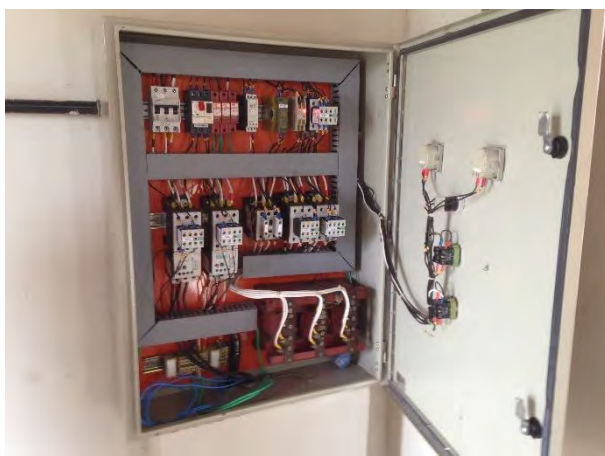
Quadro de comando
