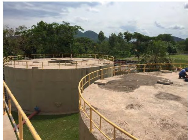
Vista superior do UASB.
