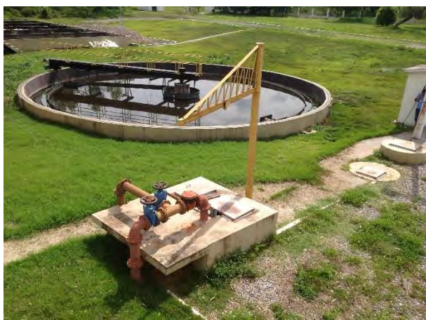
Elevatória de lodo – vista superior
