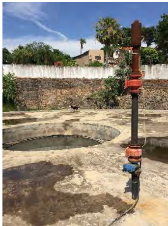
Queimador de gases em manutenção.
