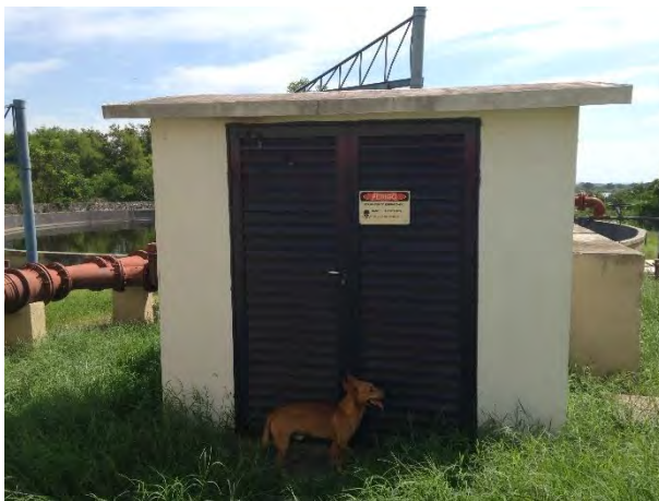
Abrigo do quadro de comando.
