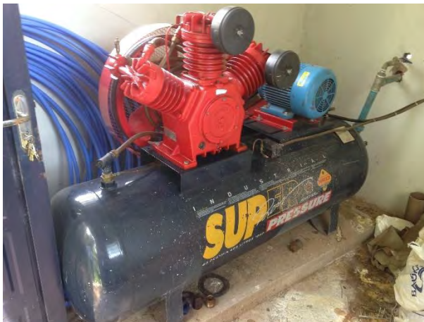
Abrigo para soprador
