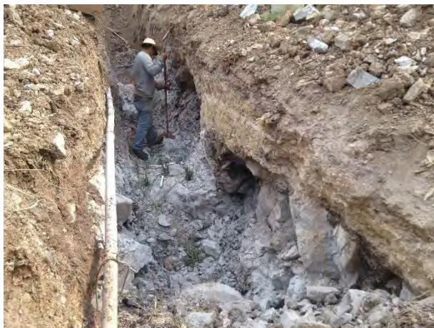
Horizonte de solo em vala
