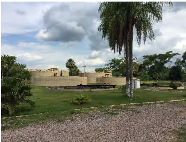
Vista geral do tratamento.
