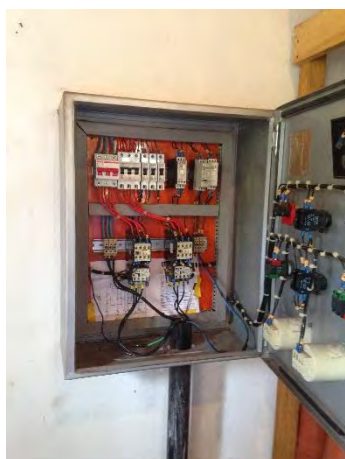
Quadro de comando
