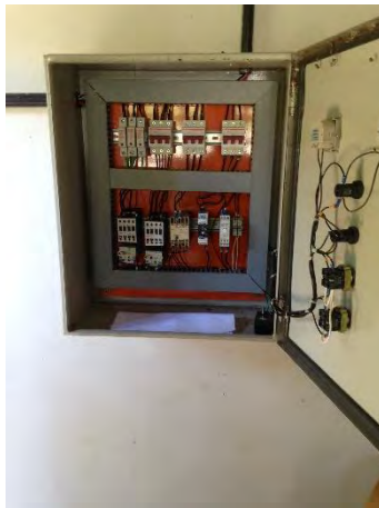
Quadro de comando
