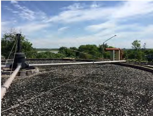
Camada suporte do FBP e distribuidor de vazão. Detalhe do canal coletor de vazão.
