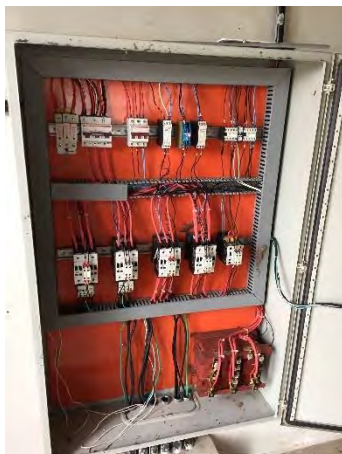
Quadro de comando
