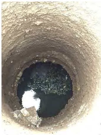
Vista interna do poço de sucção
