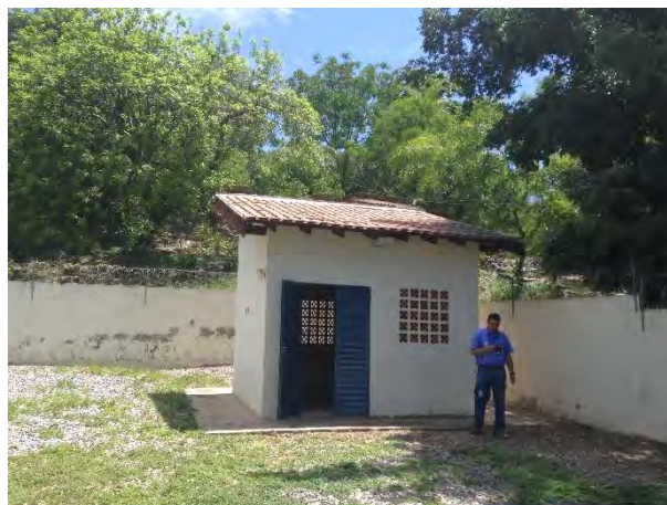
Abrigo do gerador e quadro de comando
