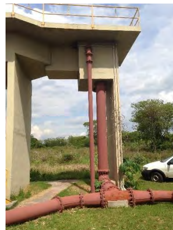
Saída para UASB
