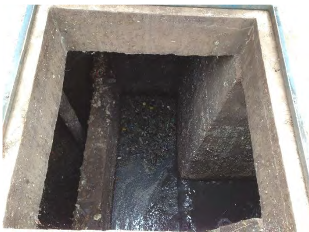
Vista interna do poço de sucção
