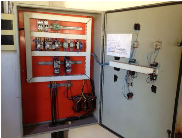
Quadro de comando
