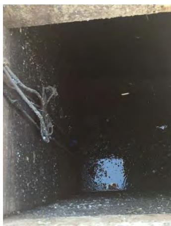
Vista interna do poço de sucção
