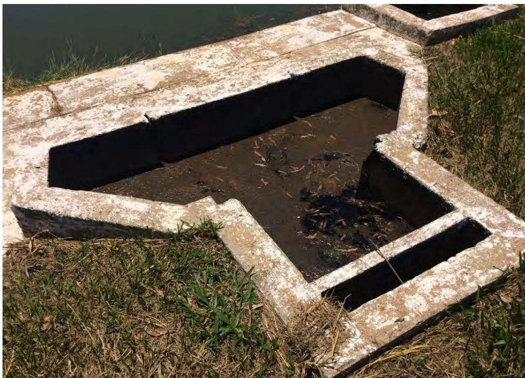
Figura 46: Caixa de Distribuição para a Lagoa Anaeróbia.
