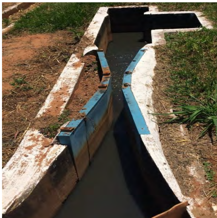
Figura 45: Calha Parshall da ETE Lagoa.
