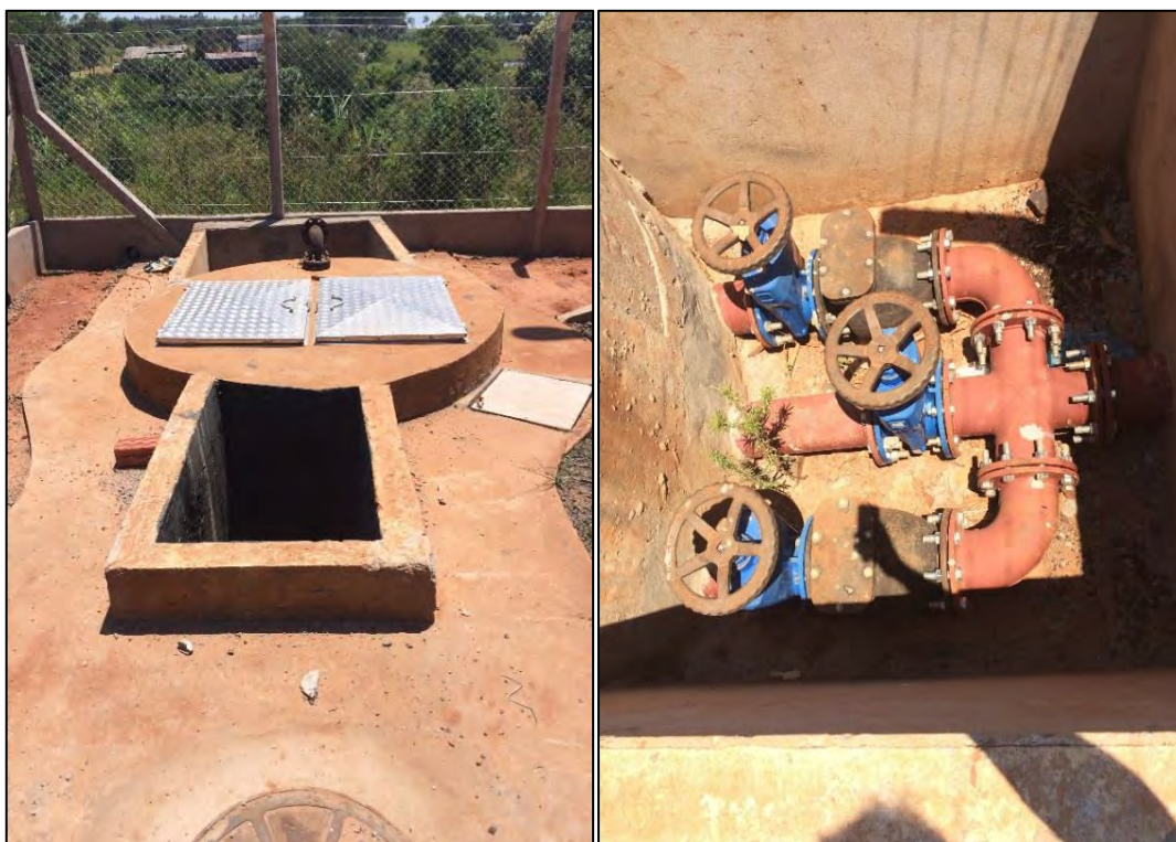
Figura 15: Estrutura da EEEB Vila Nova I e barrilete.
