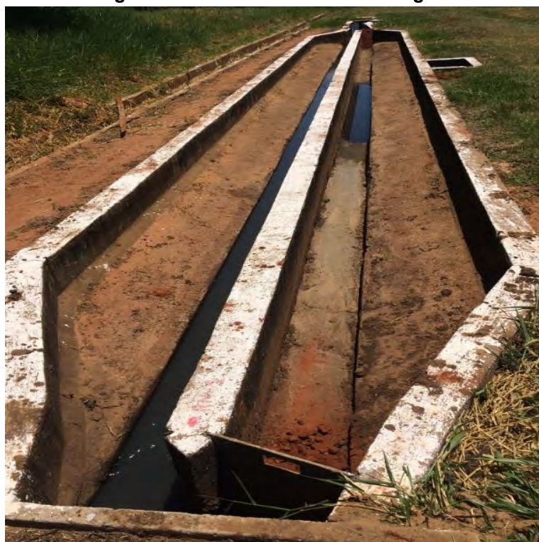
Figura 44: Desarenador da ETE Lagoa.
