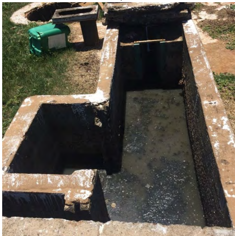
Figura 33: Tratamento Preliminar (Medidor de vazão e caixa de saída).
