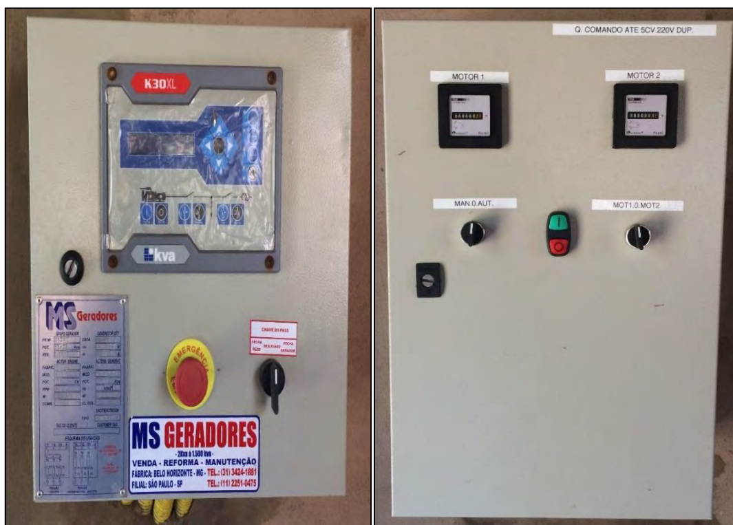
Figura 26: Painel elétrico e do gerador da EEEB Industrial.
