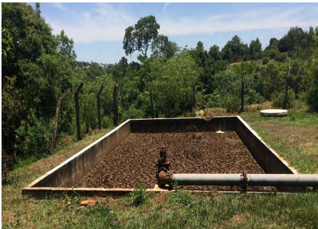
Figura 36: Desidratação de Lodo.
