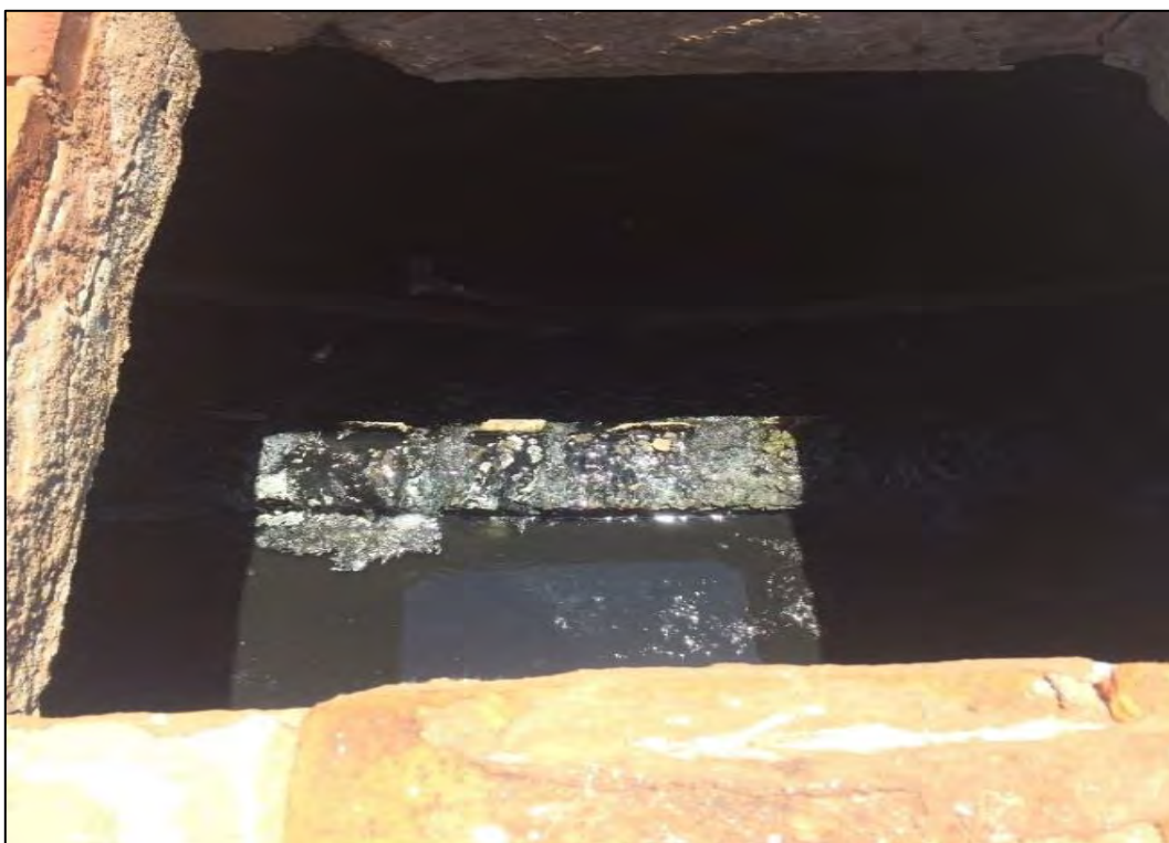
Figura 35: UASB (vertedores de coleta).
