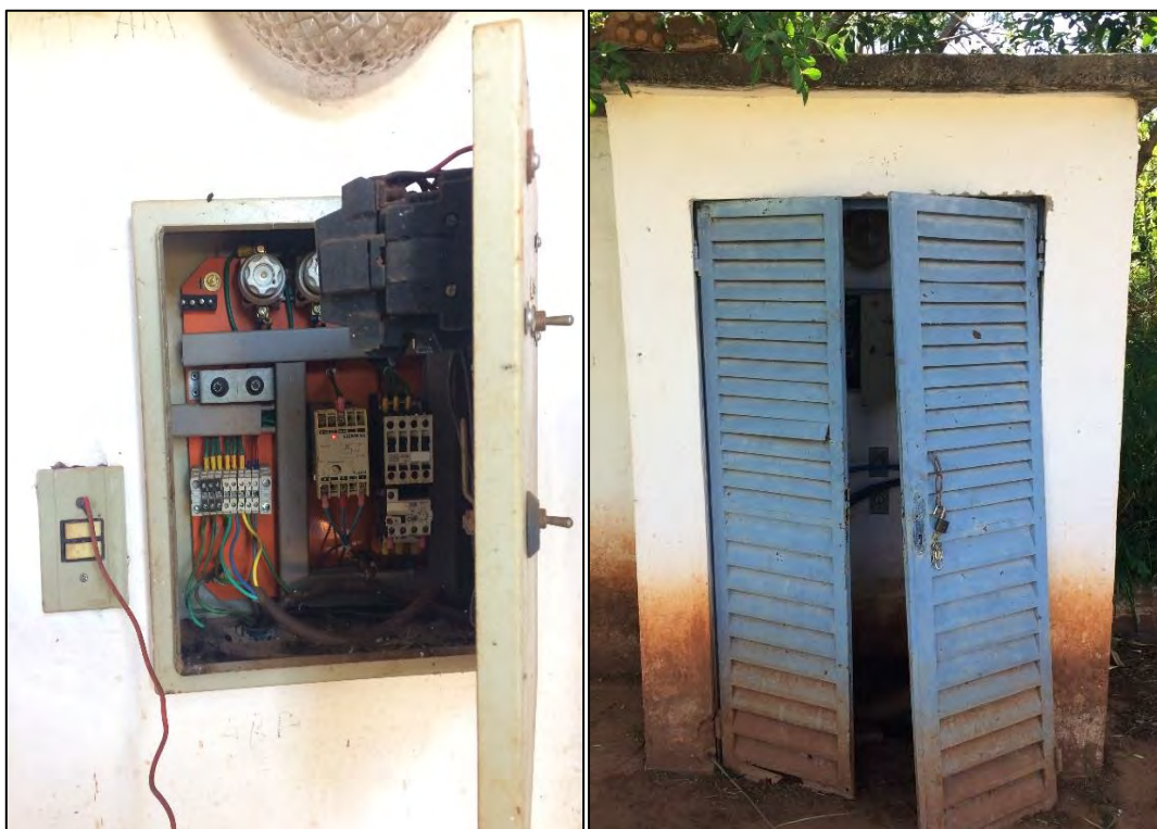
Figura 29: Abrigo do painel e painel elétrico da EEB Jardim das Palmeiras.
