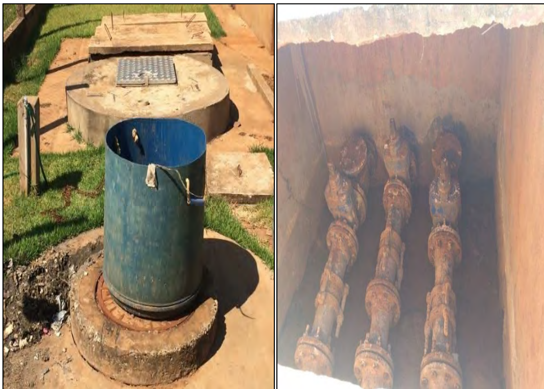
Figura 11: Estrutura da EEBB NHU Verá e barrilete.
