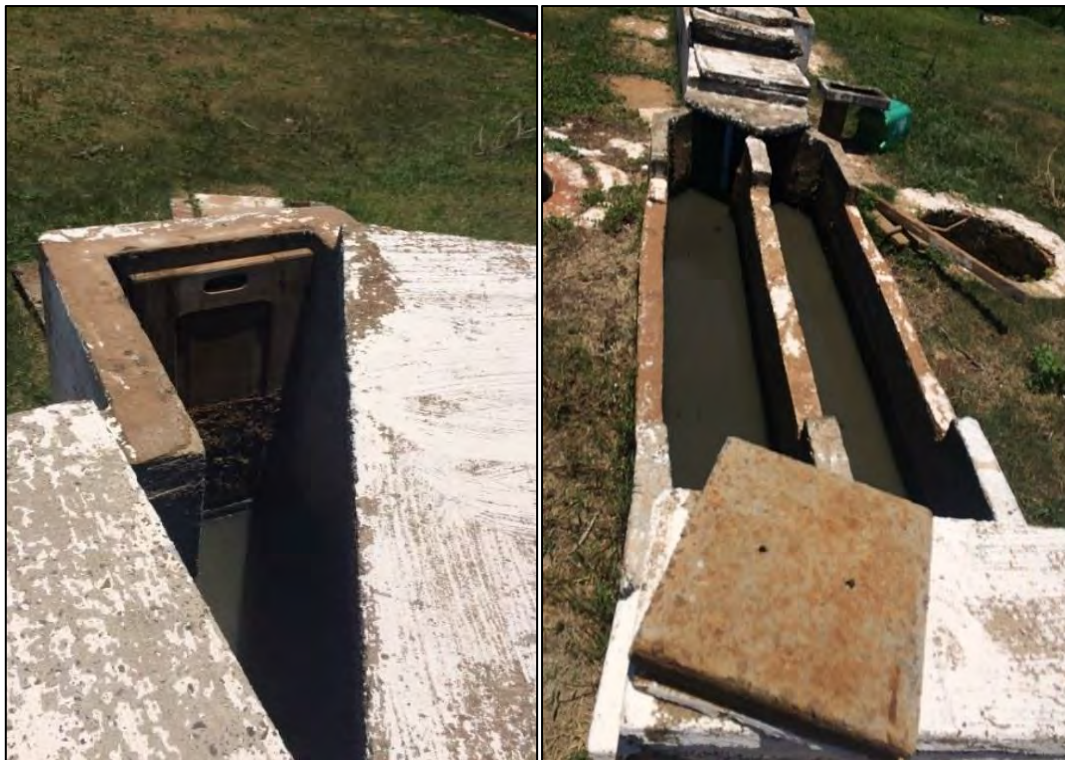
Figura 32: Tratamento Preliminar (Caixa de entrada e Desarenador).
