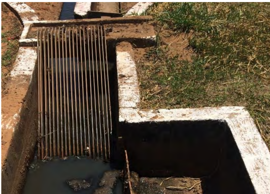
Figura 43: Gradeamento da ETE Lagoa.
