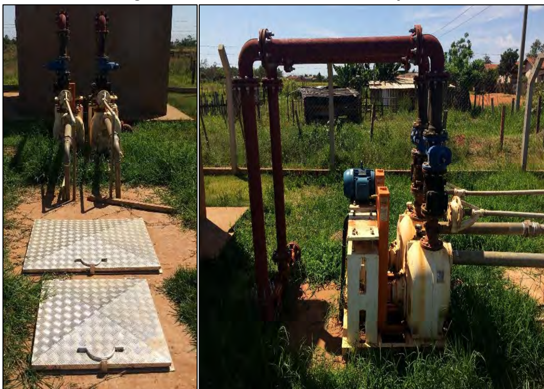
Figura 20: Estrutura da EEBB Mate Laranjeira e barrilete.
