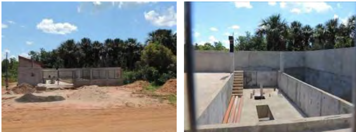
Figura 5: Vista geral da EEEB 001 em implantação, Alcinoópolis, MS.
