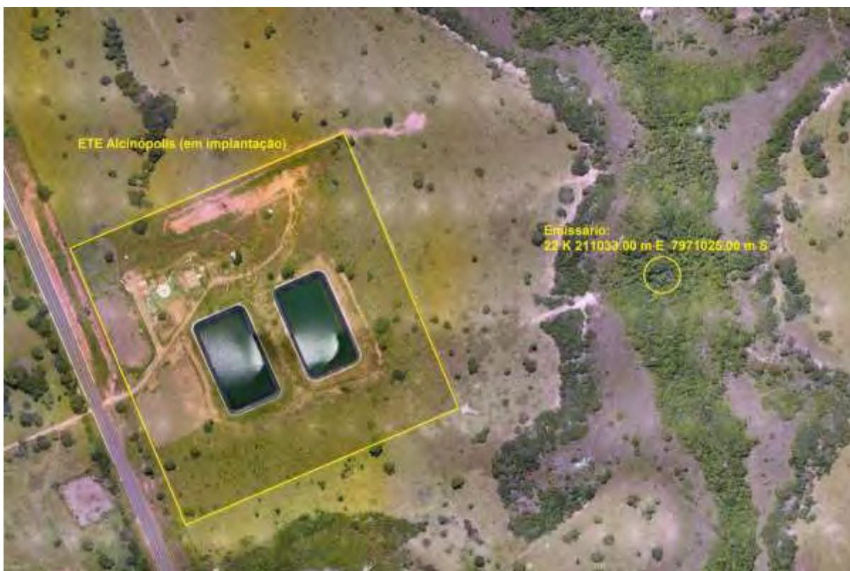
Figura 3: Vista aérea da ETE Alcínópolis em implantação e entorno, Alcínópolis, MS.
