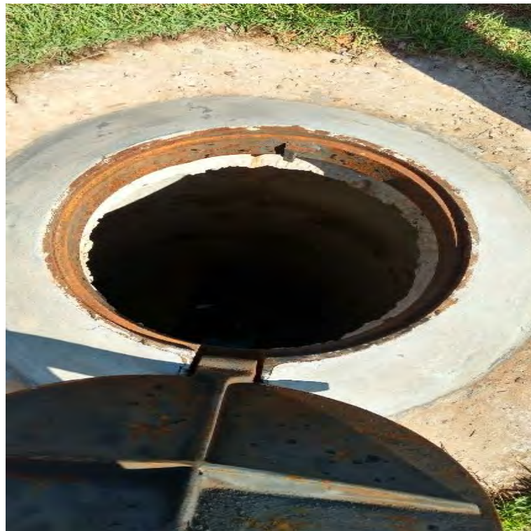
Figura 15: PV de entrada da EEBB.
