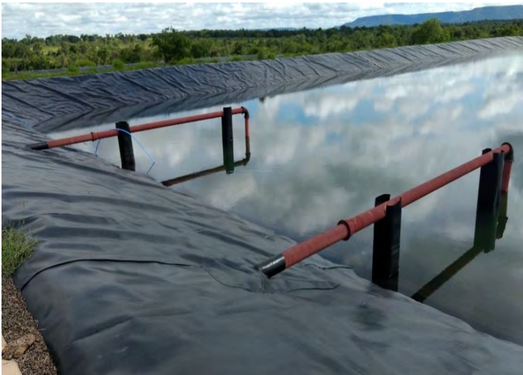
Figura 20: Lagoa Facultativa finalizada.
