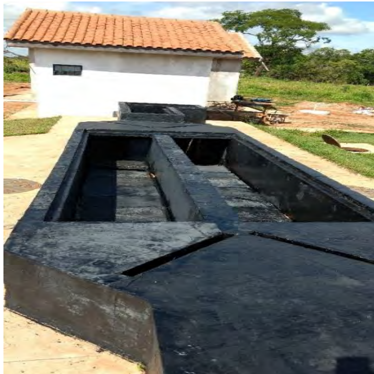
Figura 17: Estrutura Tratamento Preliminar.
