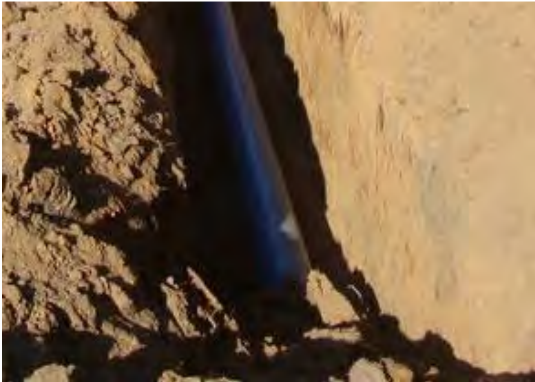
Figura 16: Linha de Recalque instalada.
