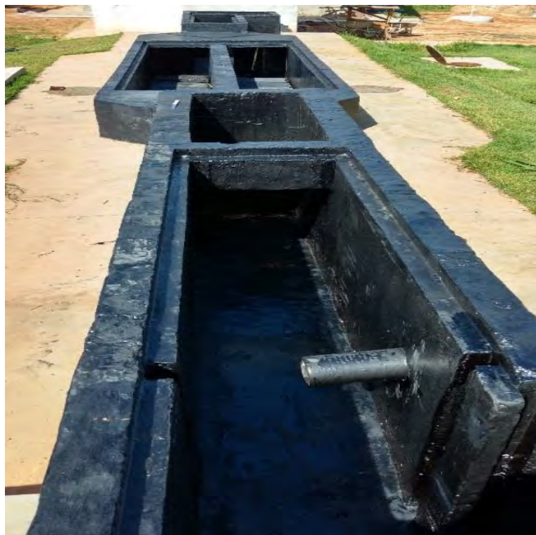
Figura 7: Vista geral tratamento preliminar.
