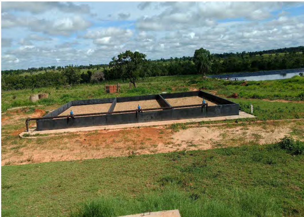
Figura 11: Leitos de secagem de lodo.
