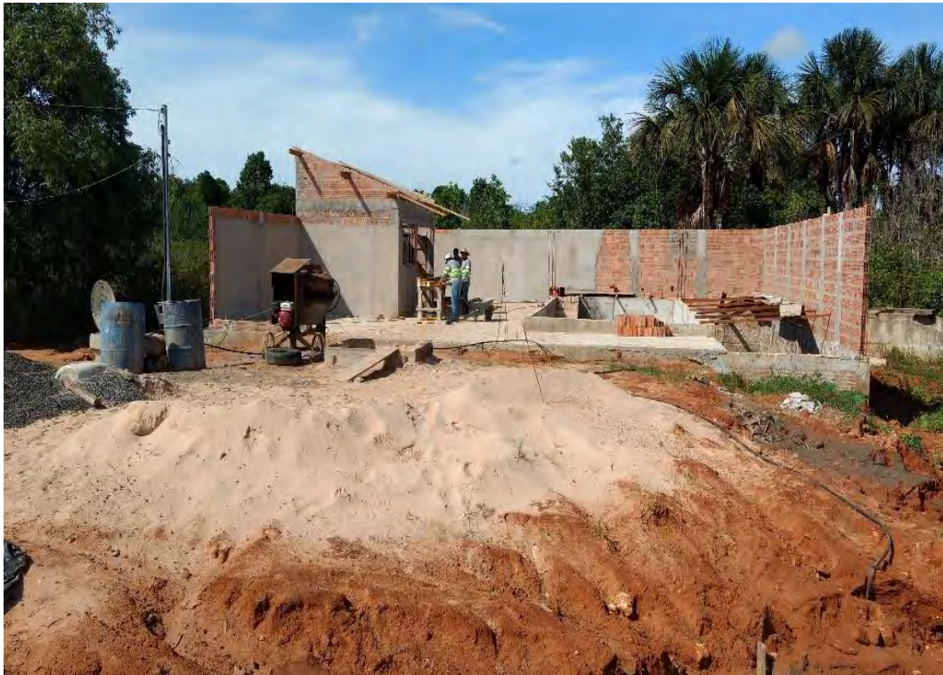
Figura 14: Fachada da EEBB.
