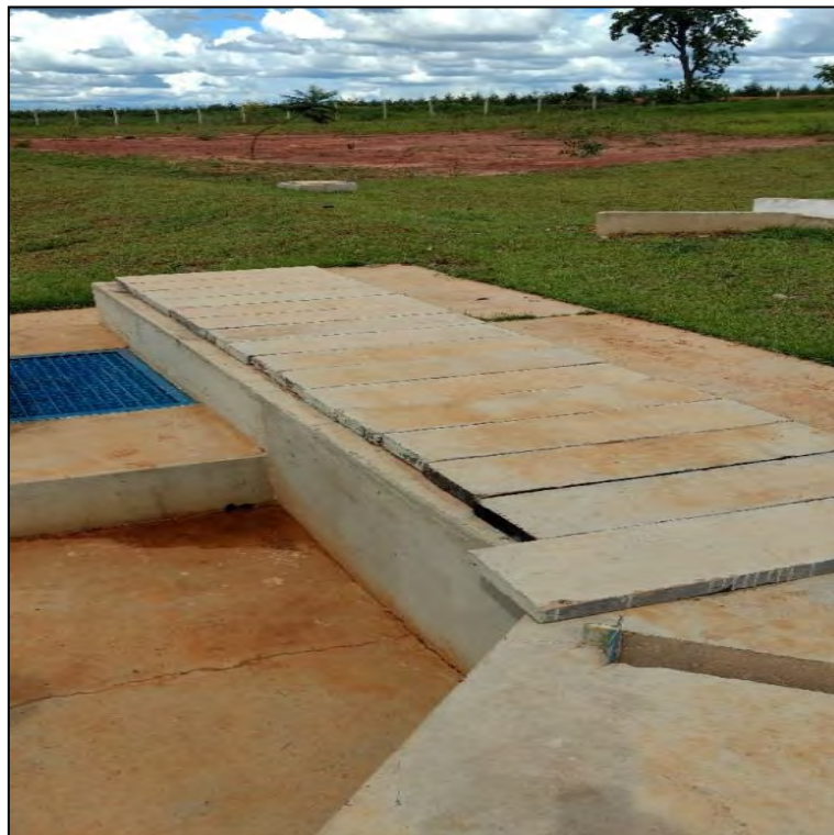
Figura 17: Canal Calha Parshall.
