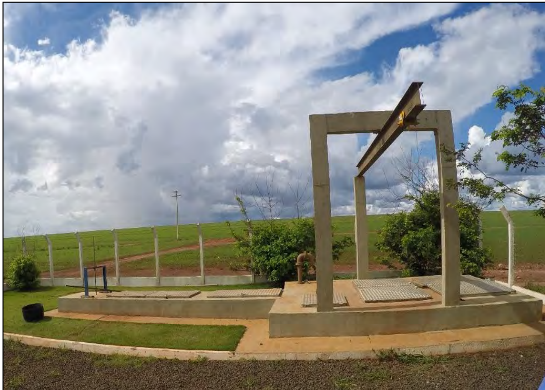
Figura 9: Vista geral da EEEB.
