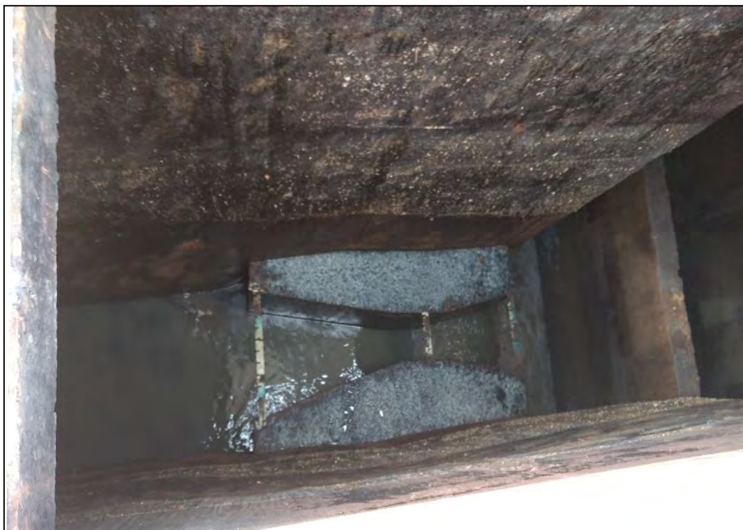
Figura 5: Calha Parshall.
