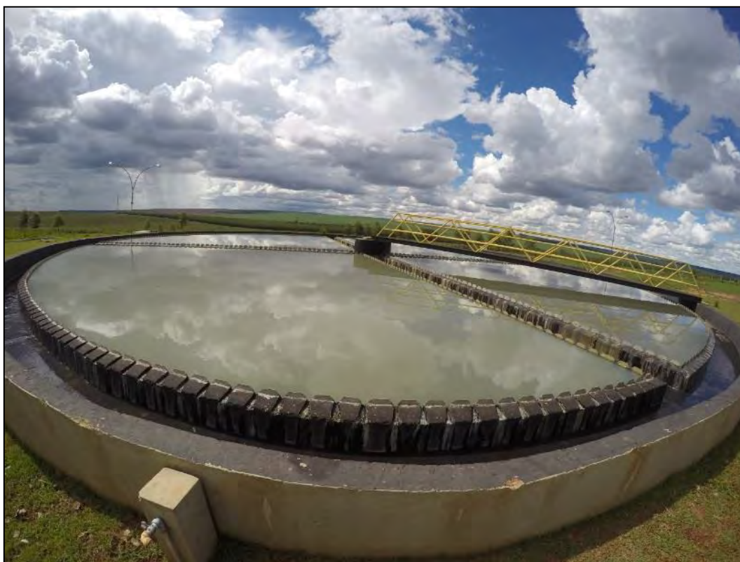
Figura 22: Vista geral filtro anaeróbio de fluxo ascendente.
