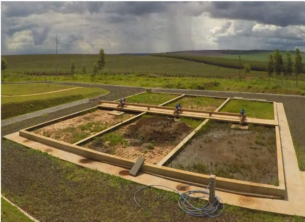
Figura 24: Leitos de Secagem Vista 2.
