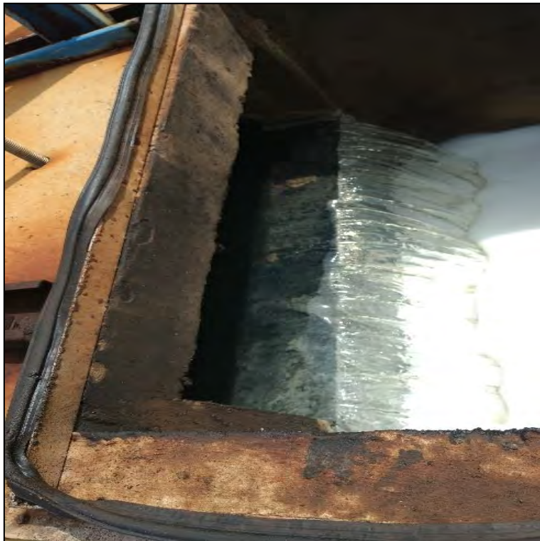
Figura 21: Saída do efluente para o filtro anaeróbio.
