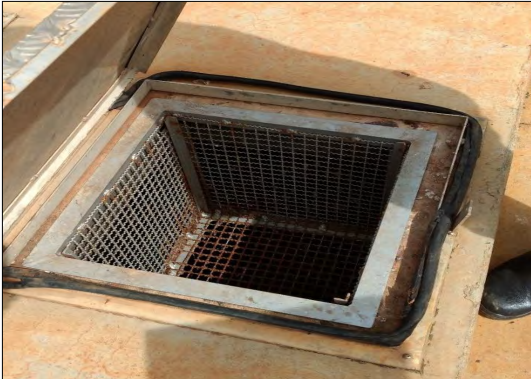
Figura 18: Ponto de descarte do caminhão esgota fossa.
