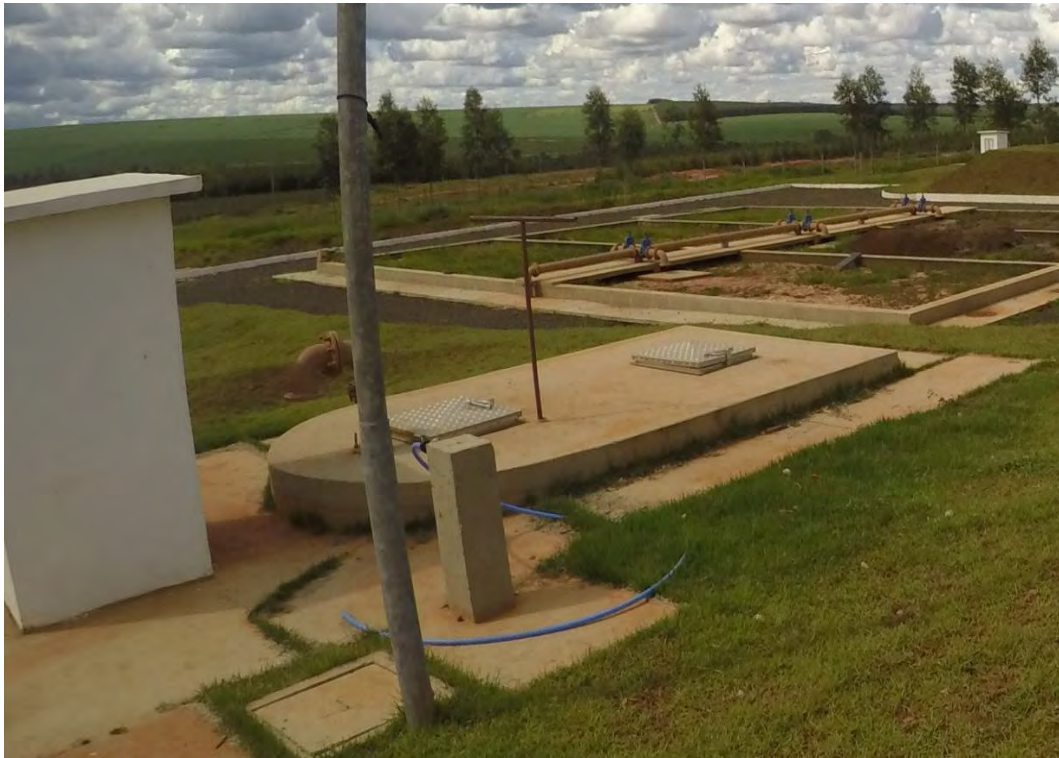
Figura 25: Elevatória de Recirculação de Lodo.
