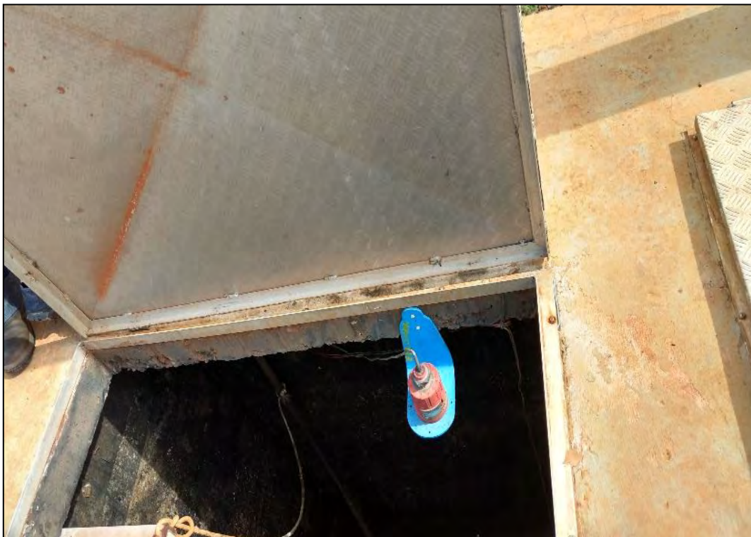
Figura 7: Medidor de nível ultrassônico poço de sucção.
