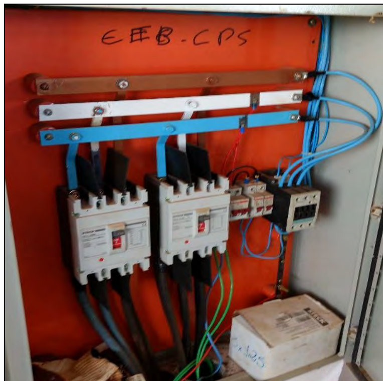
Figura 11: Quadro de Comando.
