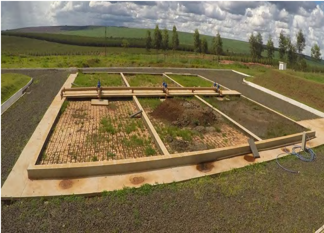
Figura 23: Leitos de Secagem Vista 1.
