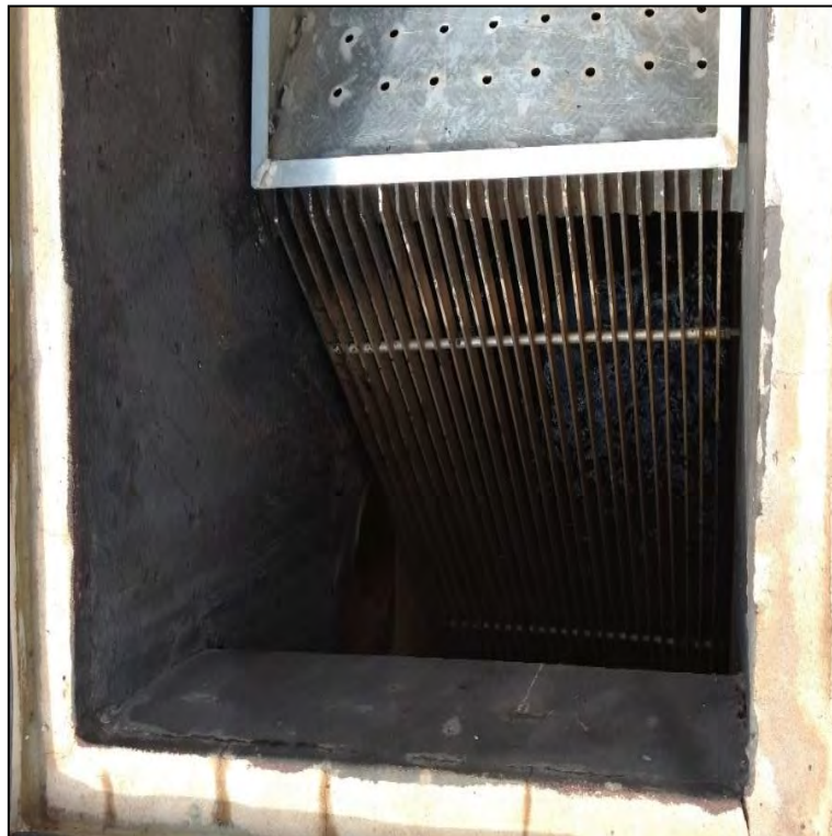
Figura 15: Grade metálica ETE Aporé.
