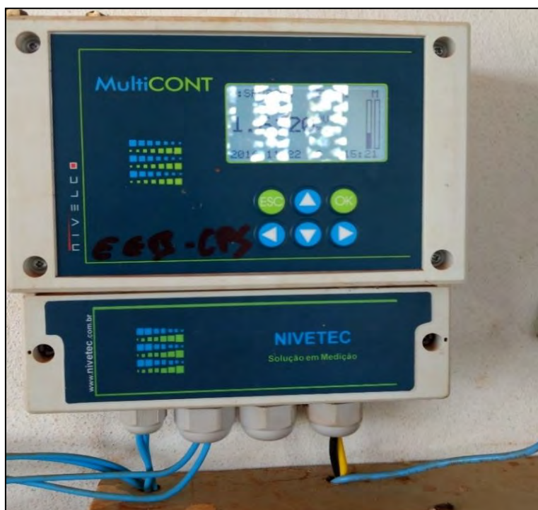
Figura 12: Display do medidor de nível ultrassônico.
