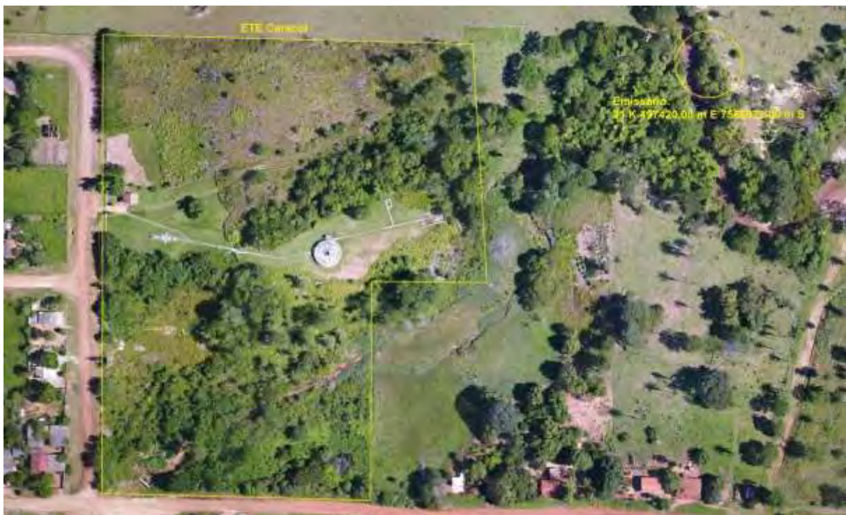
Figura 3: Vista aérea da ETE Caracol e entorno, Caracol, MS.
