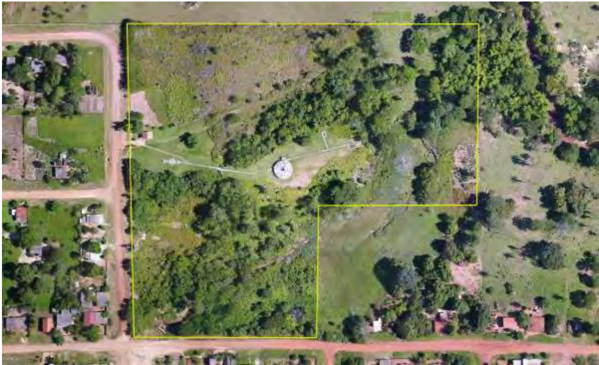
Figura 2: Vista aérea da ETE Caracol, Caracol, MS.
