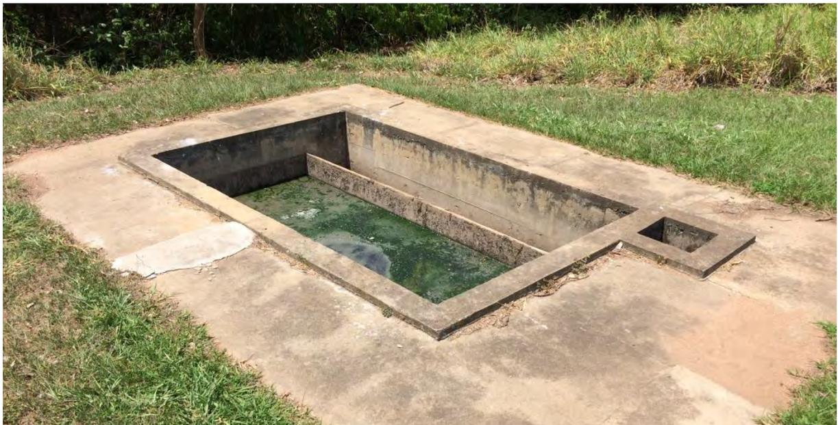
**Figura 10: Caixa de areia para descarga de resíduos do desarenador da ETE Caracol.**
