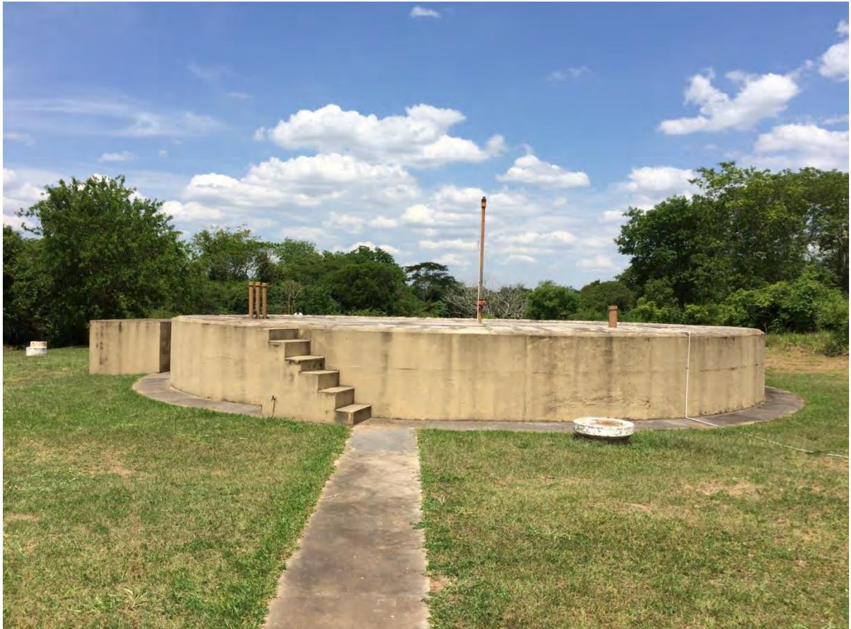
Figura 11: Vista do Reator Anaeróbio de Leito Fluidizado (RALF) - capacidade de 10 L/s.
