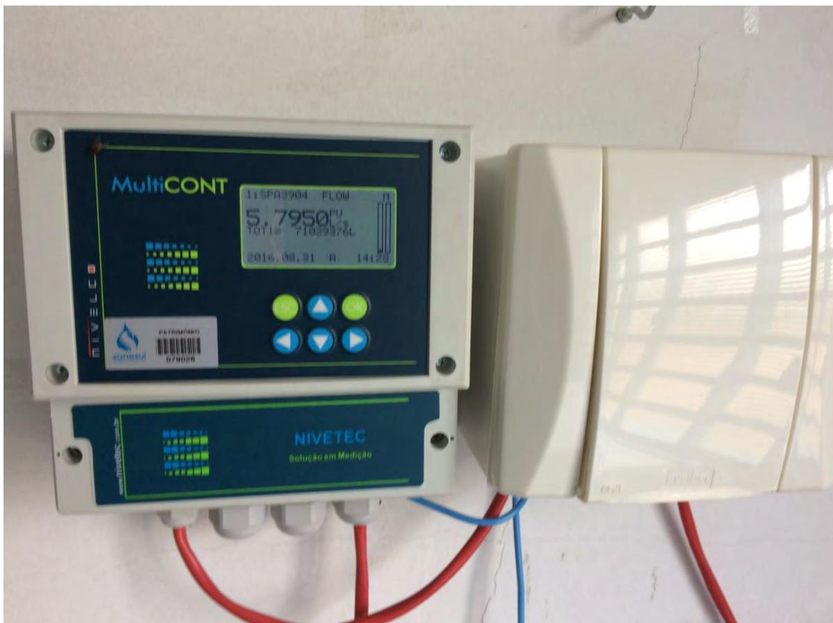
**Figura 18: Vista do display do sensor ultrassônico da marca Nivetec instalado recentemente no mês de outubro, onde é realizada a leitura da vazão instantânea de entrada na calha Parshall do desarenador da ETE Caracol.**
