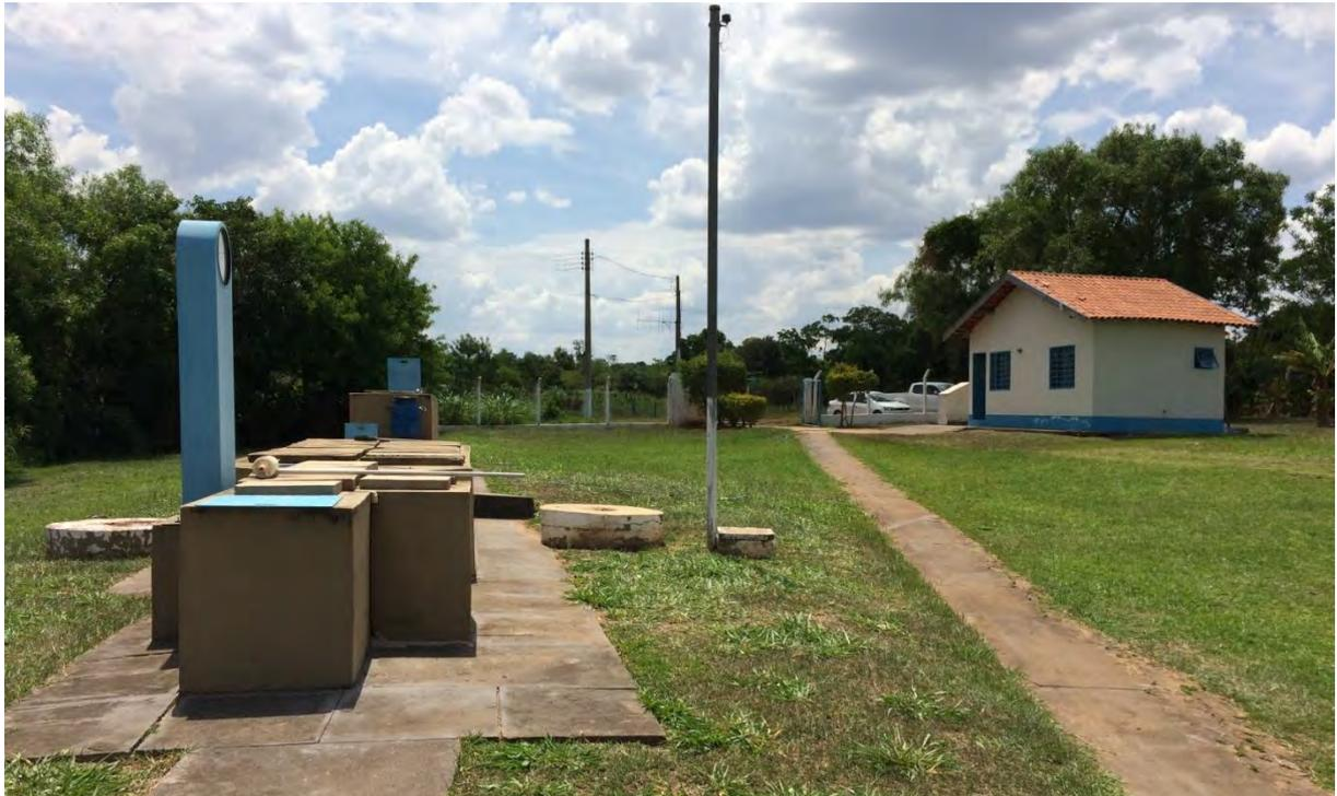
**Figura 9: Vista em primeiro plano do desarenador, e ao fundo o laboratório na entrada da ETE Caracol.**
