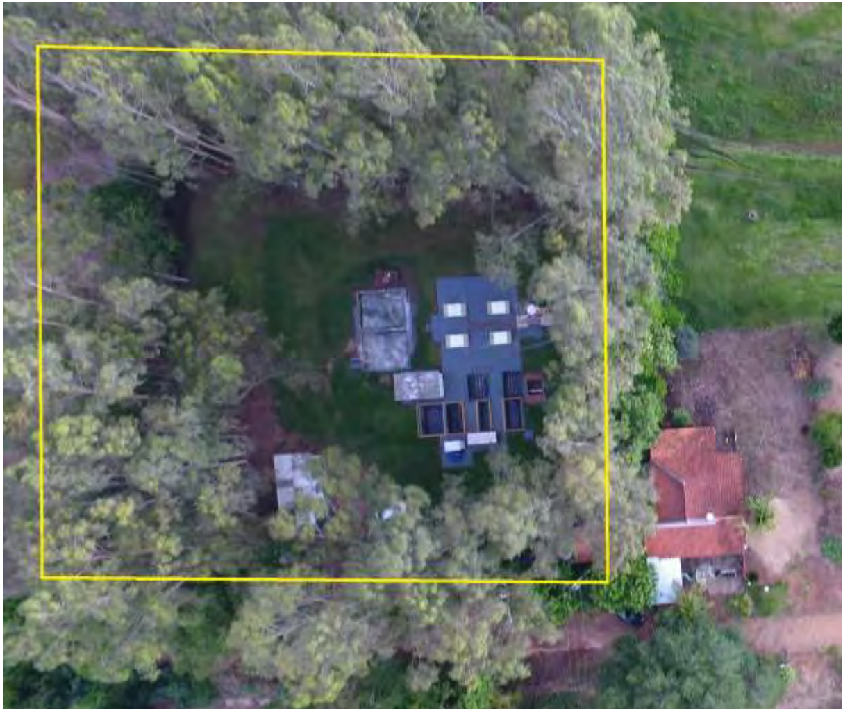
Figura 2: Vista aérea da ETE Camapuã, Camapuã, MS.
