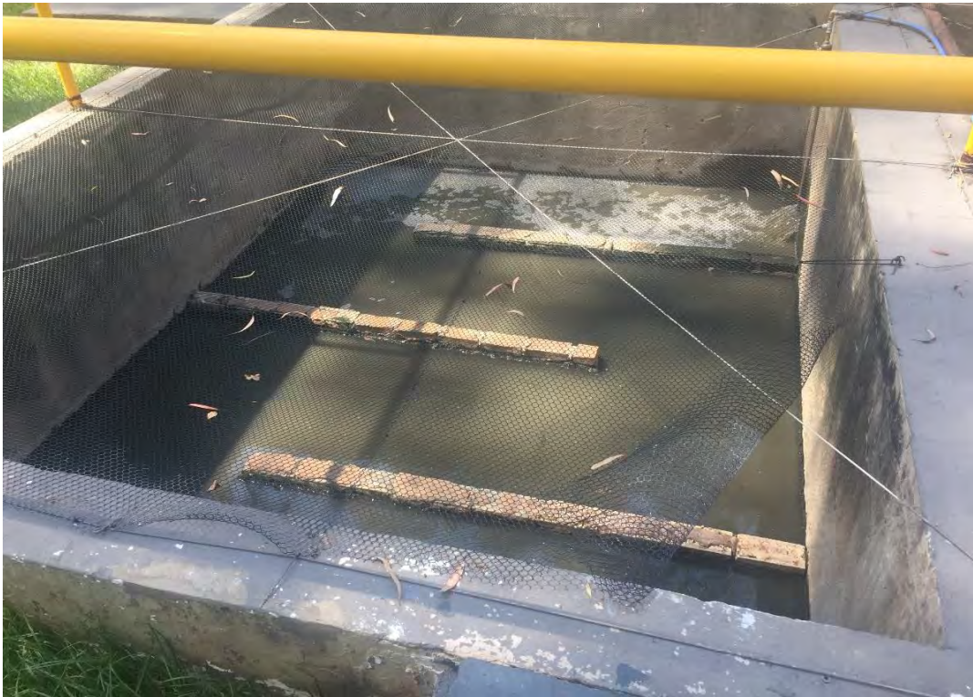
Figura 33: Tanque de contato.
