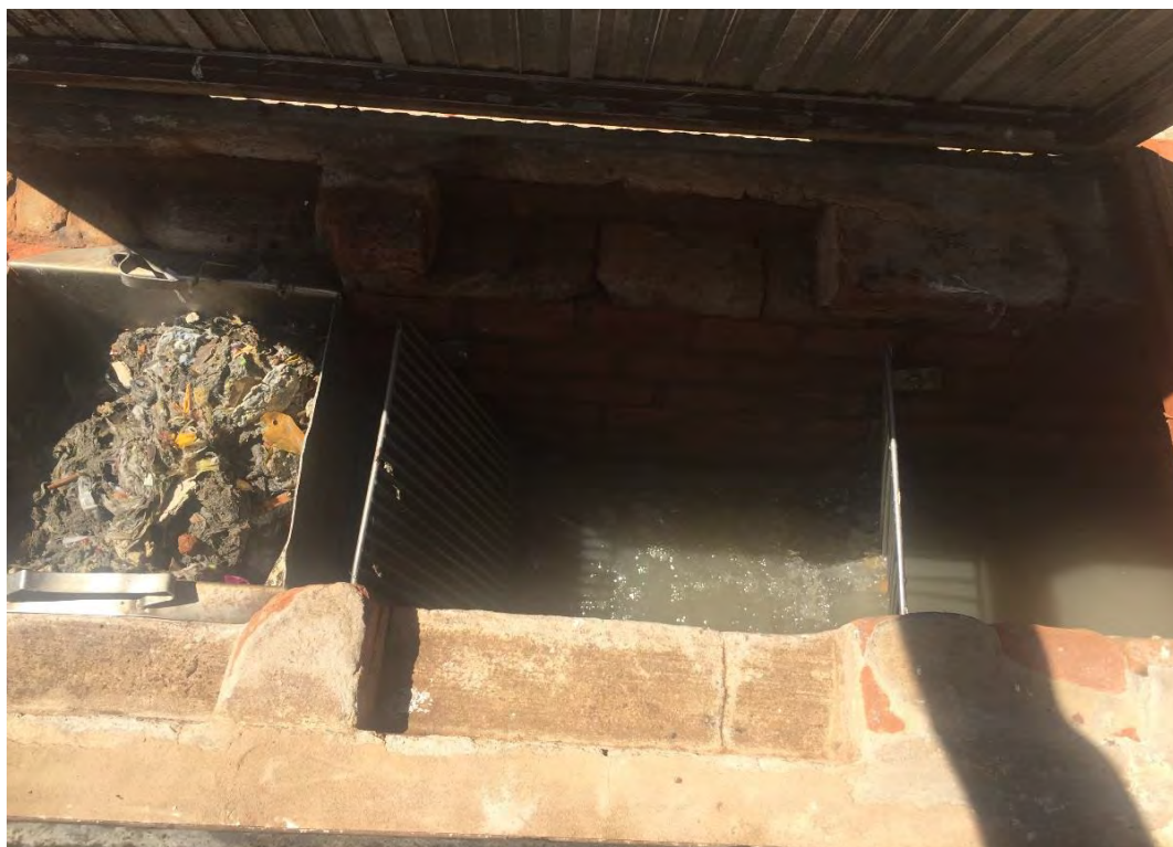
Figura 23: Gradeamento com canal executado com tijolo sem reboco e impermeabilização.
