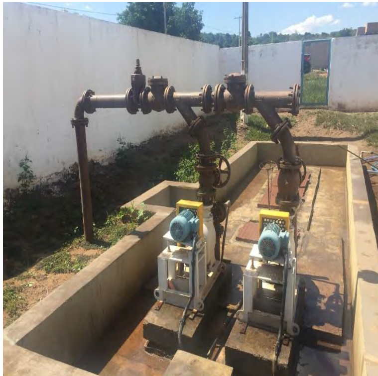
Figura 8: Conjunto moto bomba.
