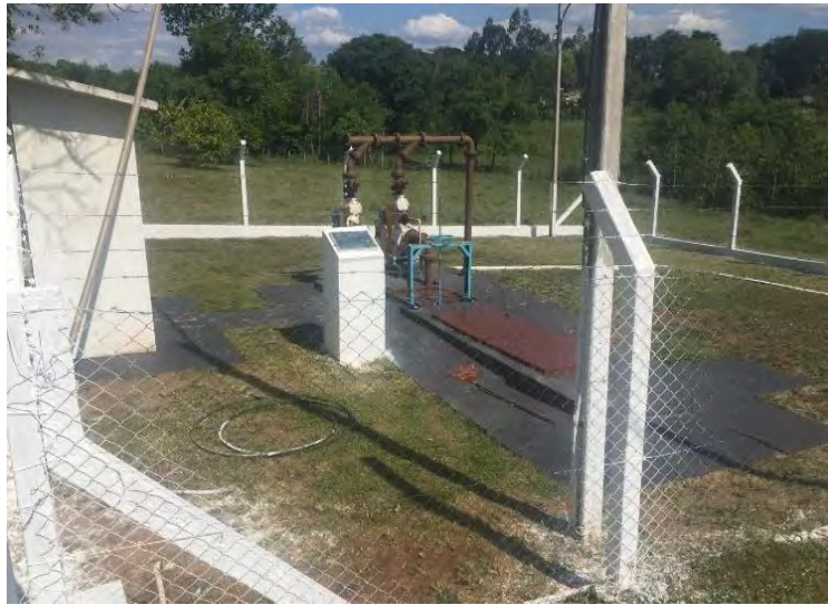
Figura 16: Vista geral da EEBB 04.
