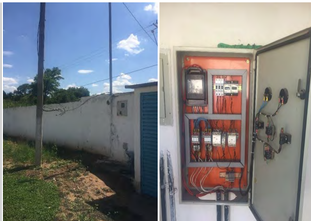
Figura 9: Padrão de entrada e painel elétrico.
