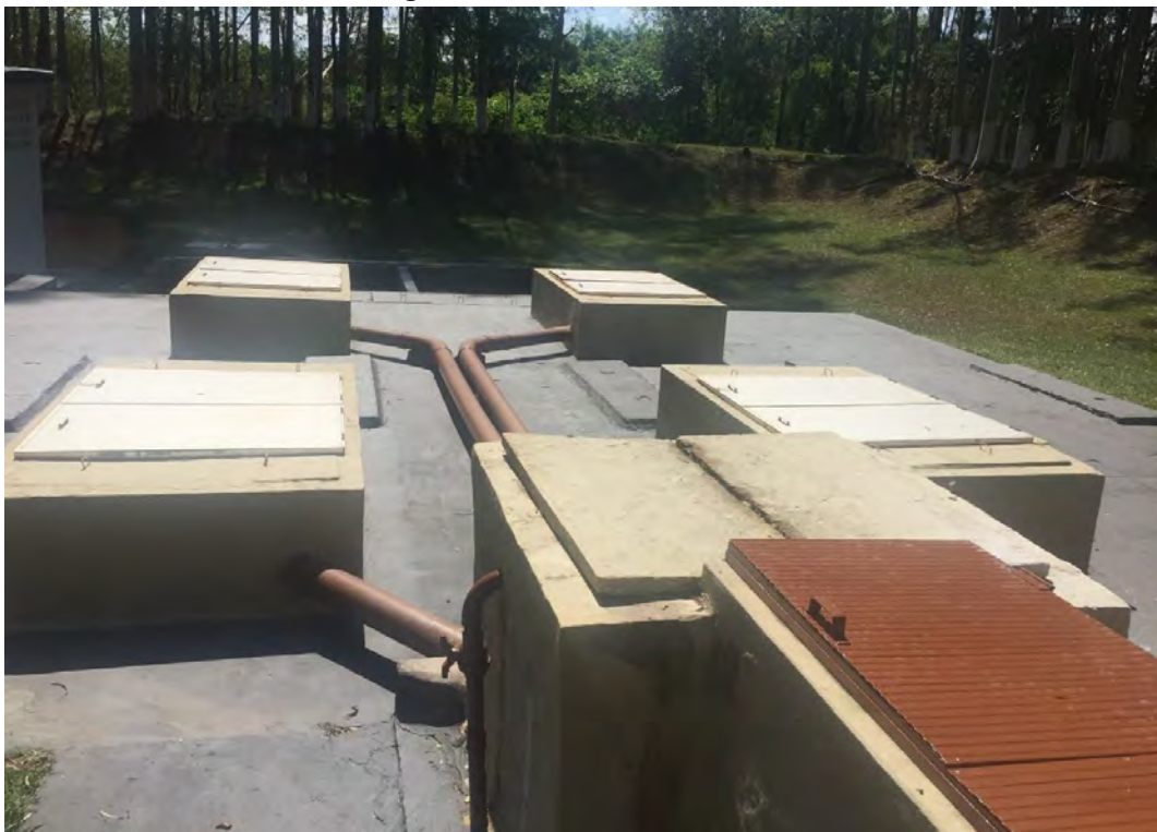
Figura 27: Vista superior do RAFA e caixas de distribuição.
