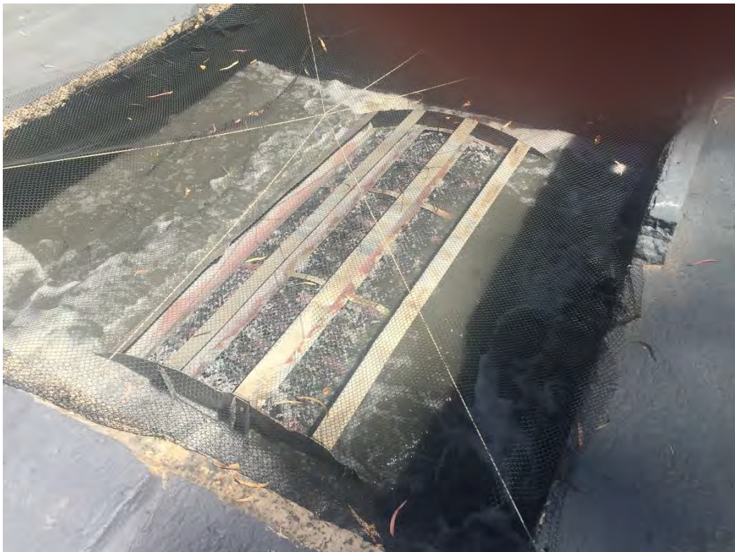
Figura 29: Biodiscos com mídias.
