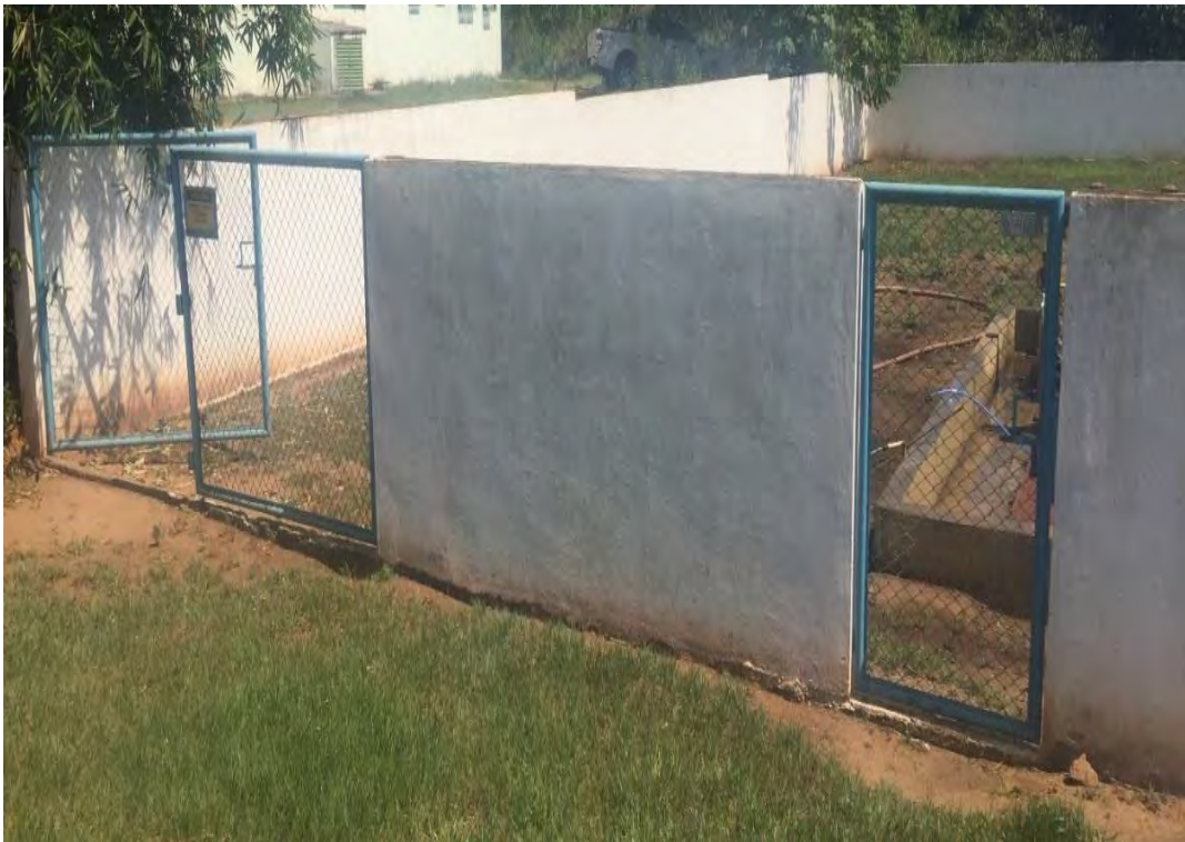
Figura 6: Vista Geral da EEEB 01.
