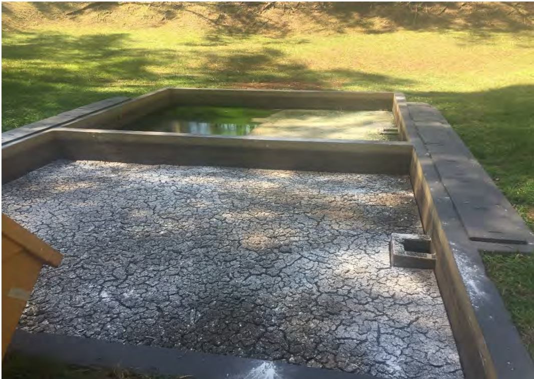
Figura 34: Leito de secagem.
