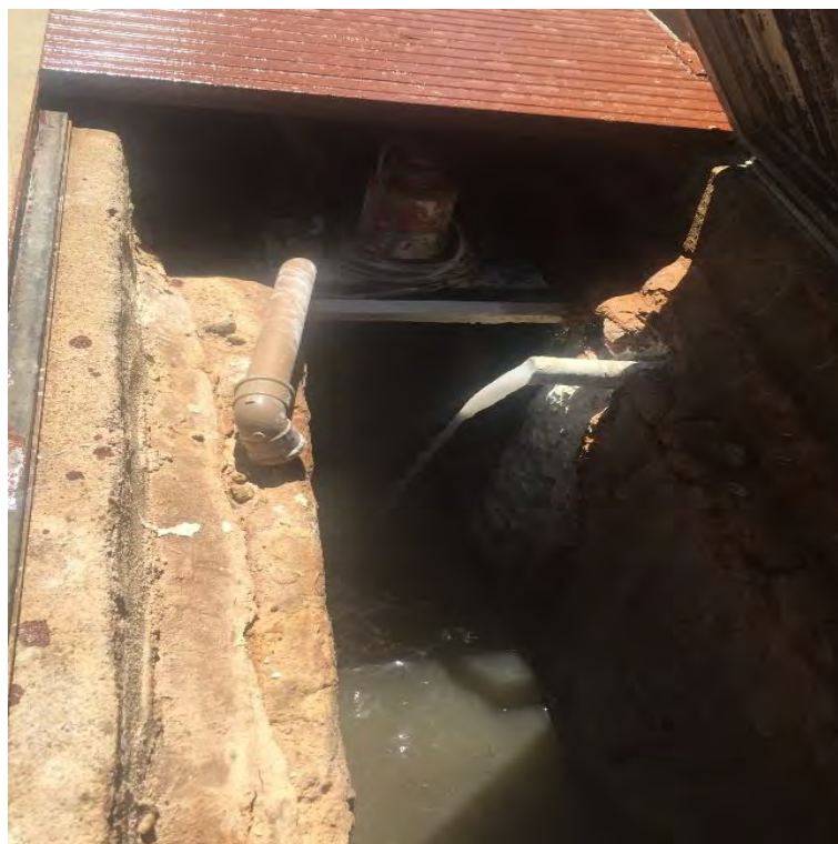
Figura 25: Ponto de dosagem de cal.
