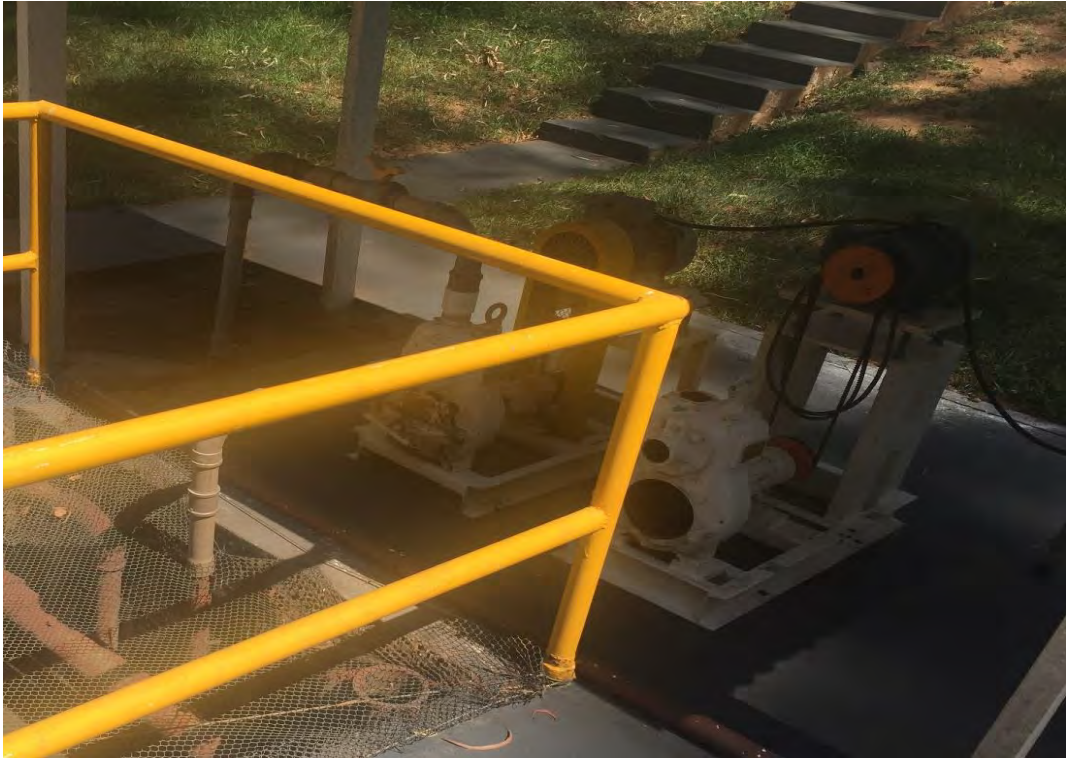
Figura 32: Bombas de recirculação.
