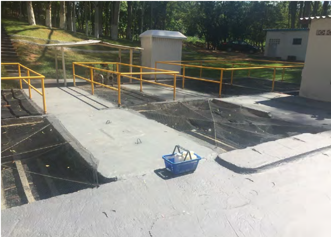
Figura 28: Tanque onde estão instalados Biodiscos.
