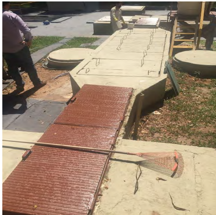
Figura 22: Tratamento preliminar com tampas em concreto e em aço carbono.
