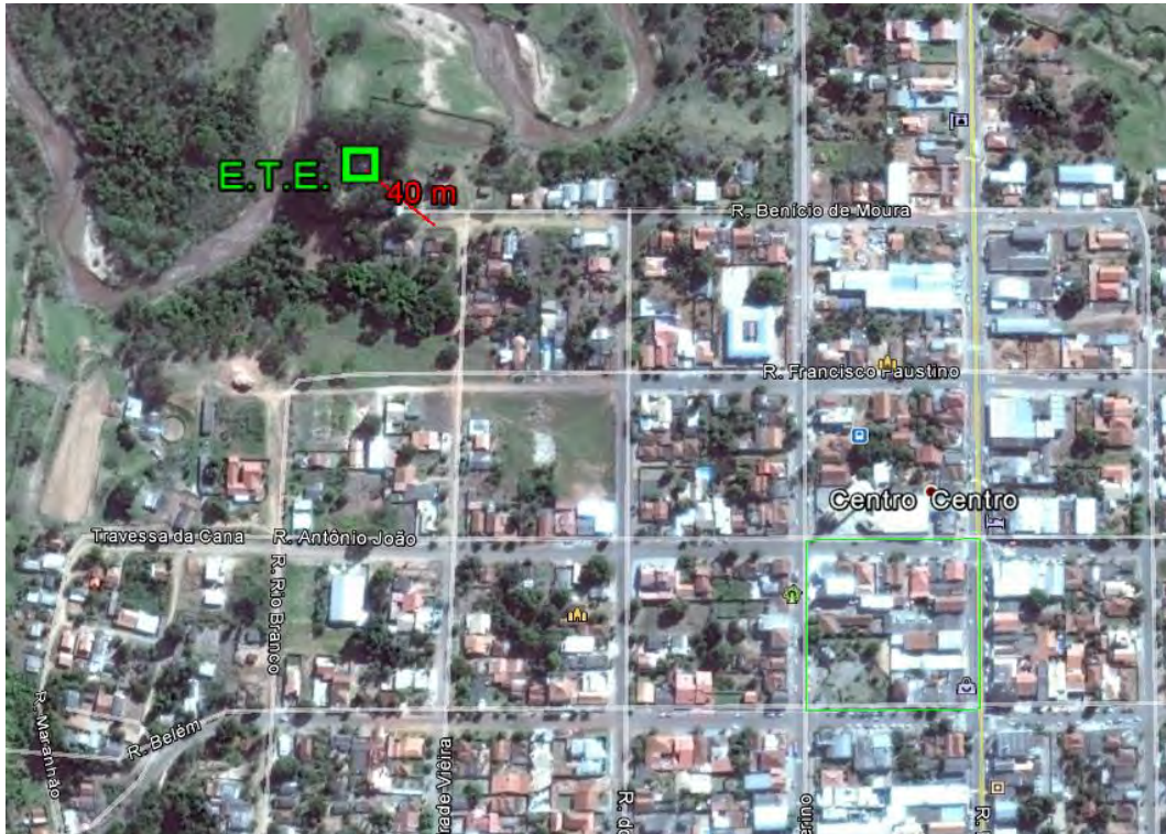
Figura 37: Ocupação ao entorno ETE Camapuã.
