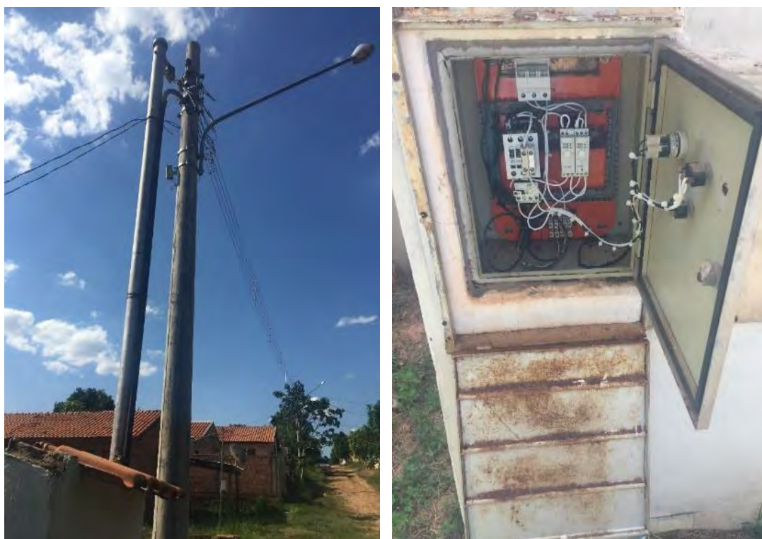
Figura 15: Entrada de energia e painel elétrico.
