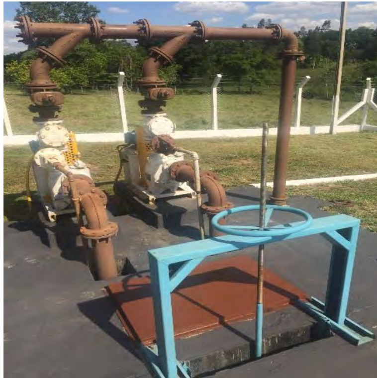
Figura 18: Conjunto moto bomba.
