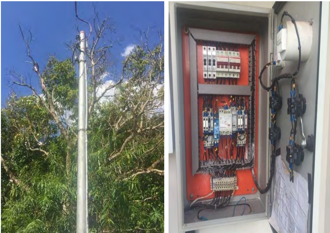
Figura 19: Padrão de entrada e painel elétrico.
