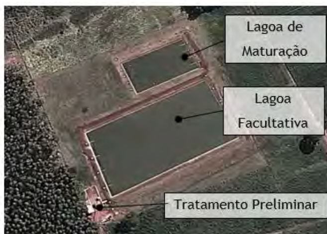
Figura 7: Vista aérea da ETE Caarapó
