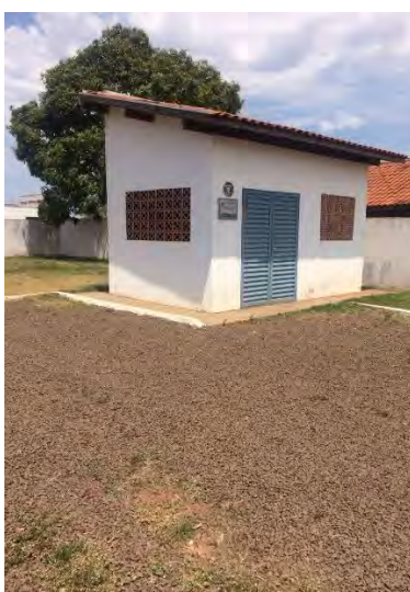
Abrigo do Quadro de Comando e Gerador
