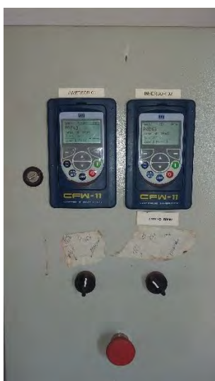
Quadro de comando
