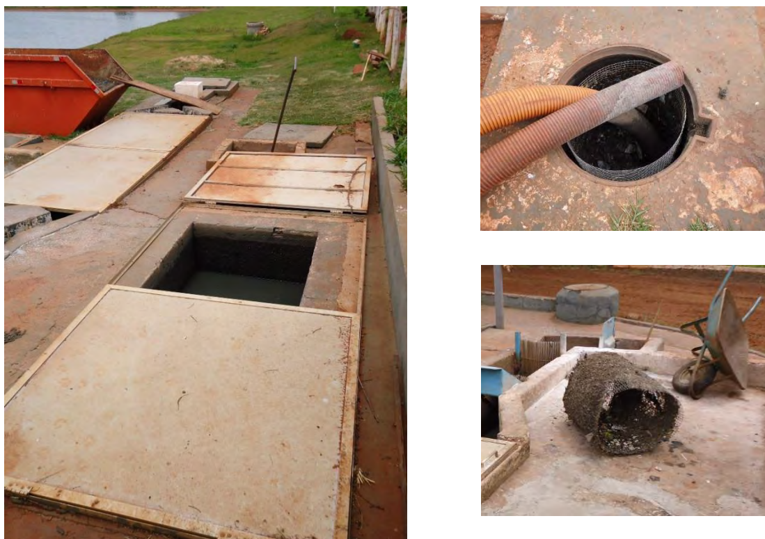
Figura 11: Estrutura de recebimento de Auto-Fossa / Cesto remoção de sólidos grosseiros
