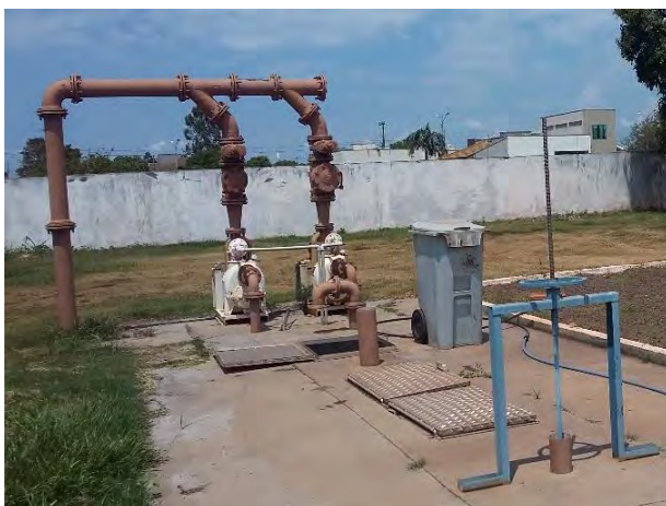
Estruturas da EE
