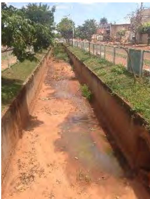
**Detalhe de corpo hídrico seco no canal de drenagem onde passava o Córrego Aviação no centro de Brasilândia. É possível verificar a presença de contribuição de esgoto clandestino.**
