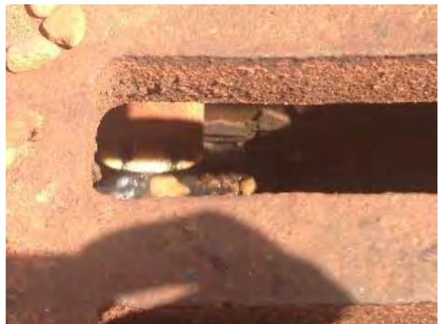
Esgoto clandestino lançado na galeria de água pluvial no Bairro João de Abreu, próximo ao n. 34.
