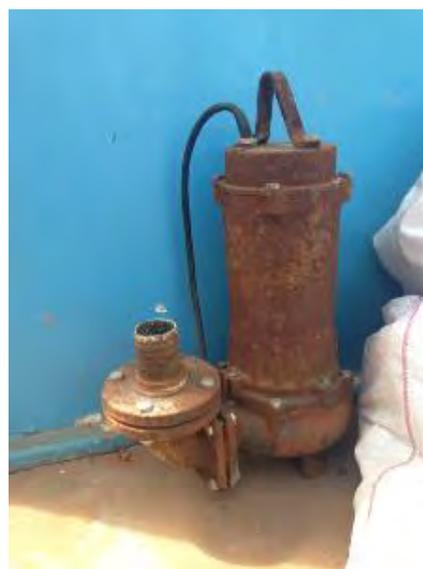
Bomba reserva desinstalada, porém em espera na elevatória
