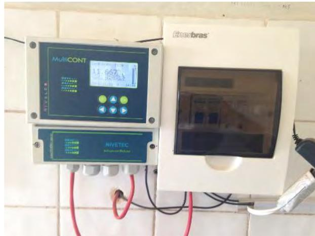
**Figura 8: Painel do medidor de vazão ultrassônico da ETE Brasilândia demonstra a vazão média afluyente acima da capacidade da estação.**
