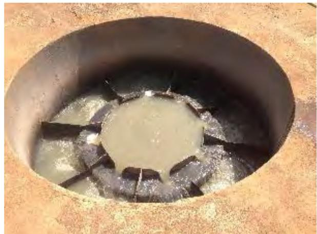
Figura 12: Vertedor central de esgoto do reator em Brasilândia.
