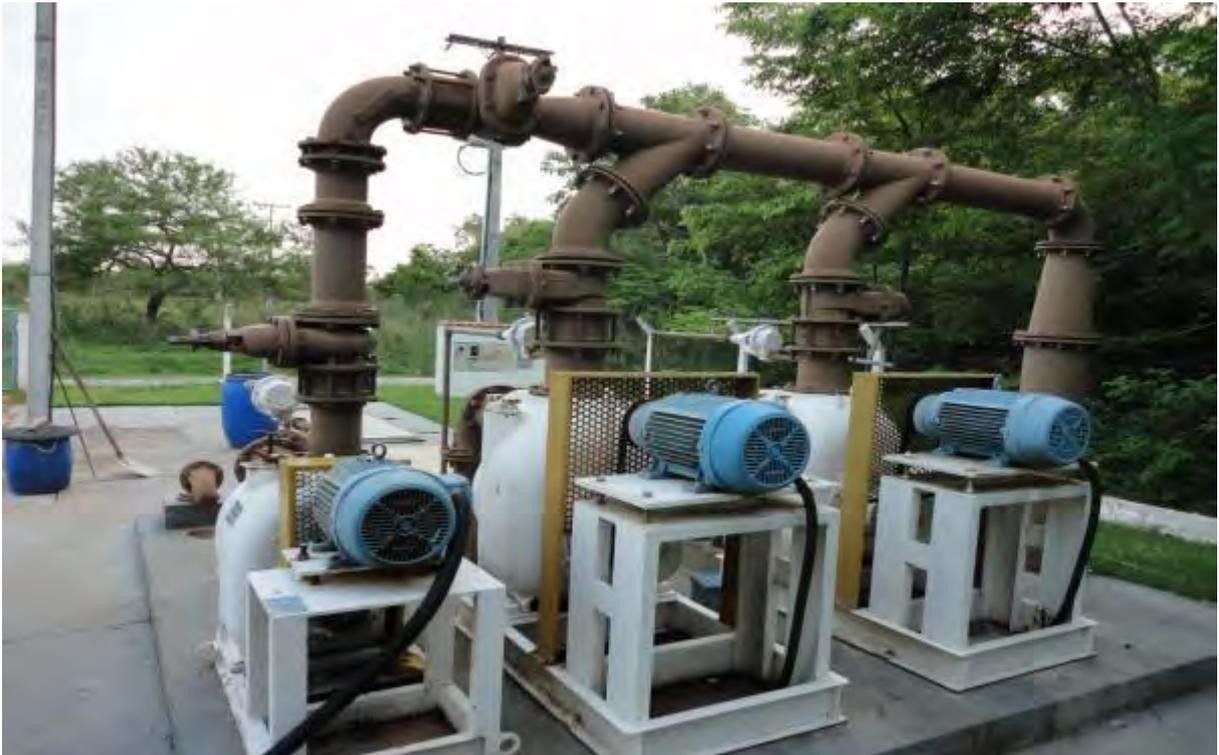
**Figura 12: Conjuntos moto-bombas da estação Elevatória Final de Bonito.**
