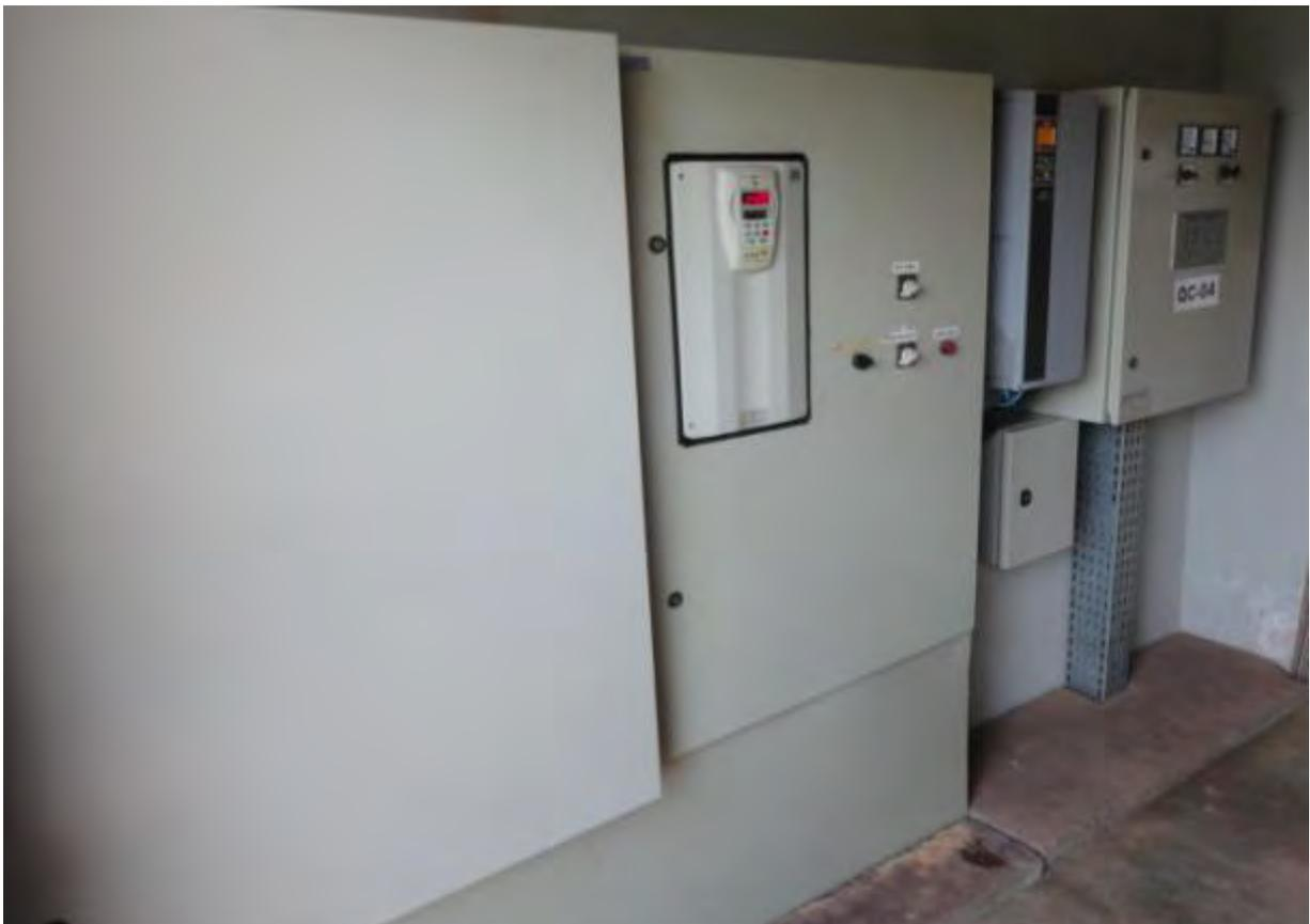
**Figura 13: Vista dos painéis de comandos da estação elevatória final e inversores de frequência.**
