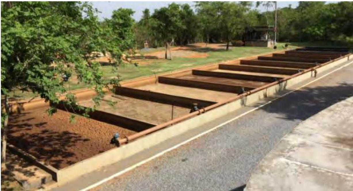
**Figura 39: Vista dos leitos de secagem de lodo da ETE Bonito.**
