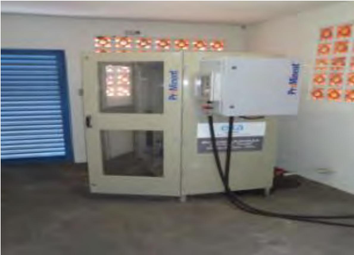
**Figura 34: Gerador de dióxido de cloro, com capacidade de 4Kg/h da ETE Bonito.**
