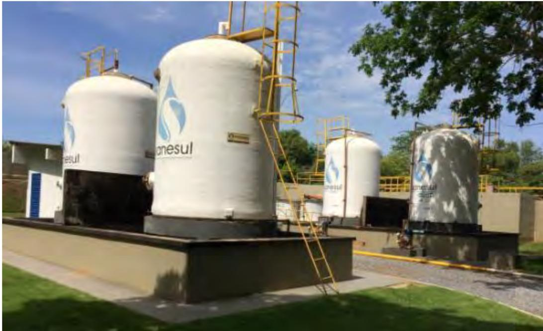
**Figura 31: Tanques de armazenamento de produtos químicos, com capacidade de 15m<sup>3</sup>da ETE Bonito.**
