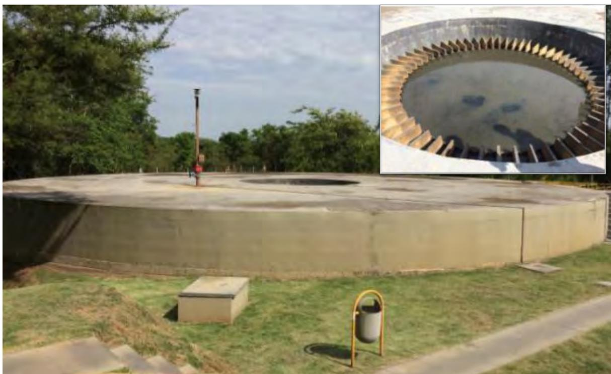
**Figura 24: Vista do Reator Anaeróbio de Lodo Fluidizado (RALF) "1" - Capacidade de 40 L/s, com detalhe da câmara de distribuição central da ETE Bonito.**
