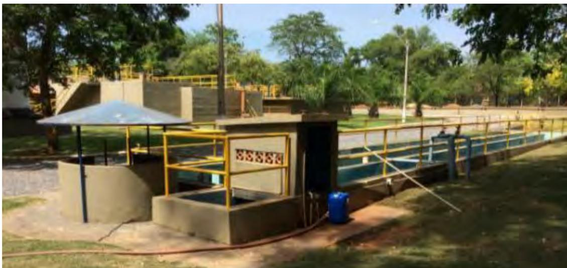
**Figura 37: Vista em primeiro plano da elevatória de recirculação de efluente tratado para reuso, na saída do tanque de contato da ETE Bonito.**
