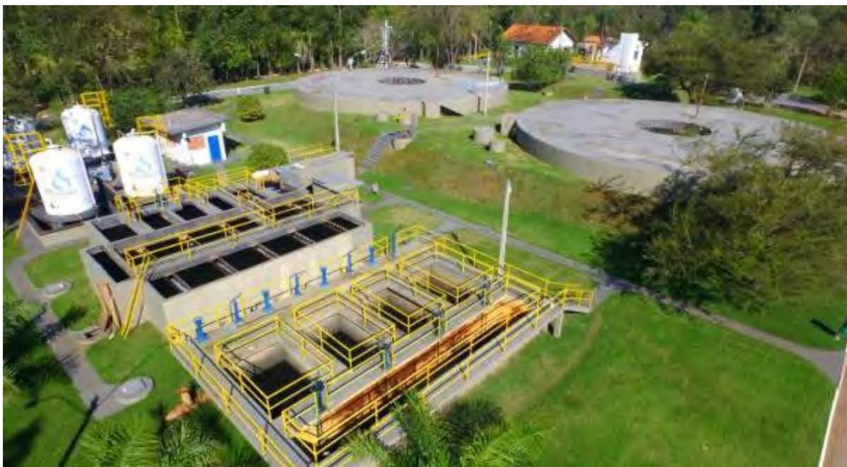
**Figura 28: Vista superior da ETE Bonito, em primeiro plano os filtros da unidade físico-química, decantador, floculador e tanques de produtos químicos.**
