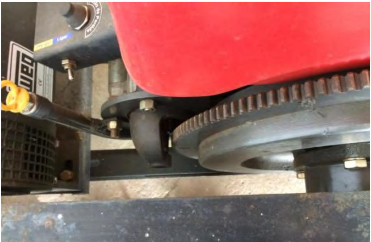
**Figura 20: Detalhe do acoplamento da partida na engrenagem do motor, o mesmo problema de partida ocorre nas EEEB Portal Formoso e Tarumã I e II.**
