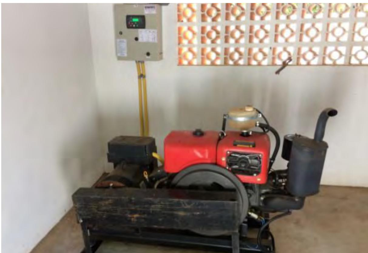
**Figura 16: Vista do Grupo Gerador marca GERAFORTE de 18 kVA, padrão para as EEEB Portal Formoso, Tarumã I e II de Bonito.**
