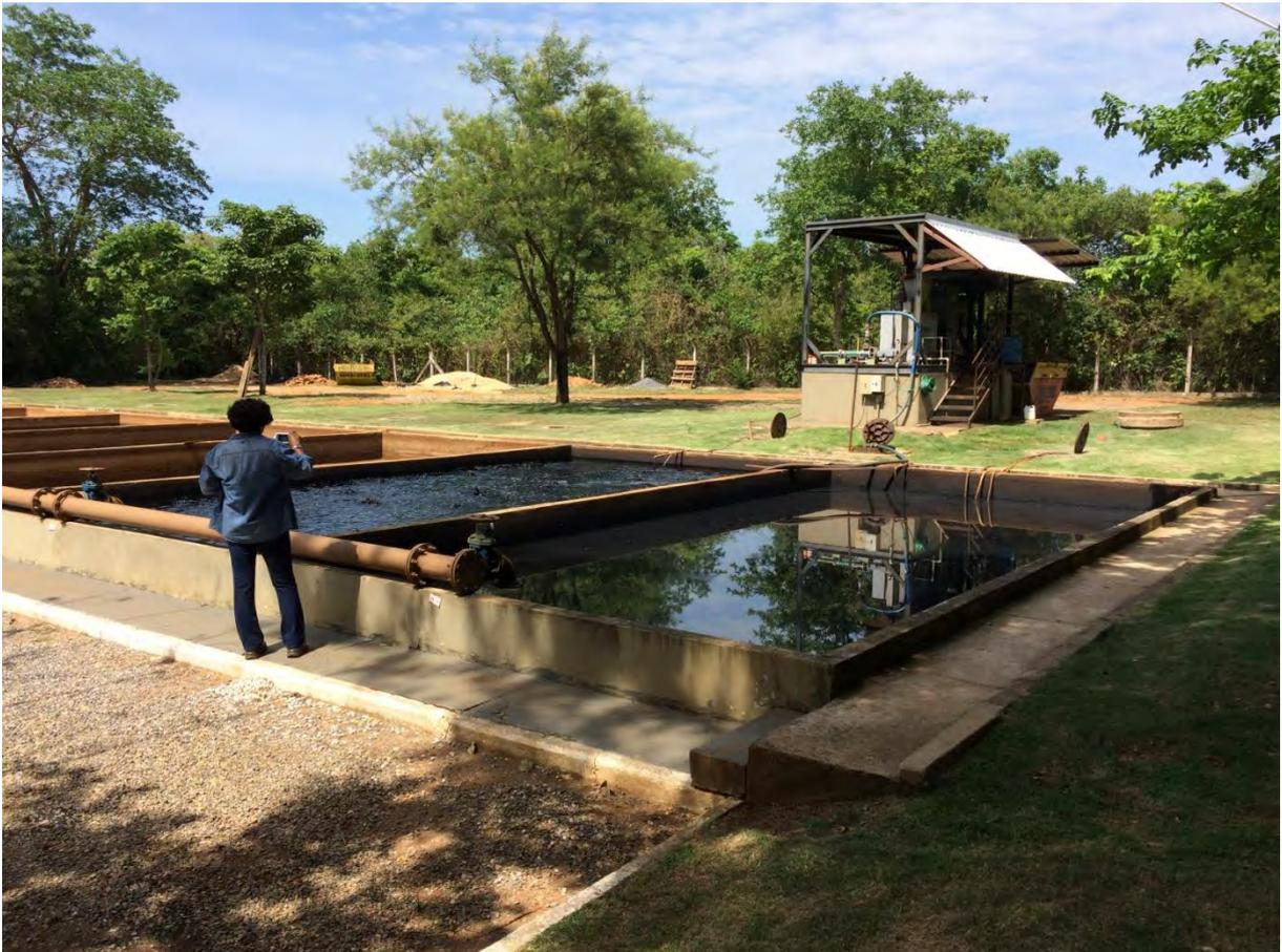
**Figura 41: Vista dos dois leitos onde são bombeados o lodo da unidade físico-química (decantador) da ETE Bonito.**
