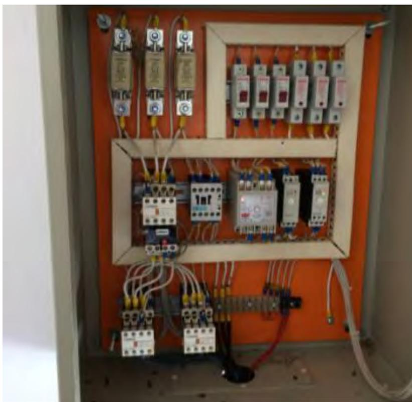
Figura 18: Vista do detalhe interno do quadro de comando, padrão para as EEEB Portal do Rio Formoso e Tarumã I e II.
