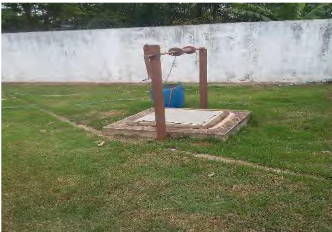
**Figura 17: EEEB 02 – Sol Nascente, sistema de içamento e bombona plástica, em Bodoquena.**
