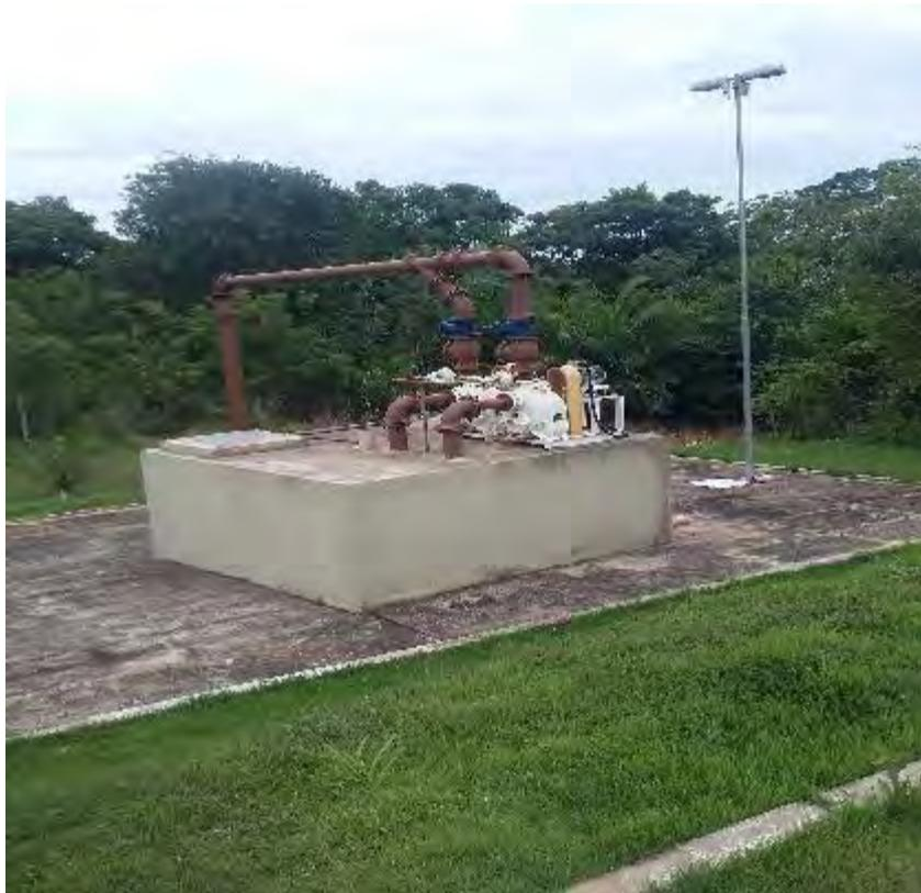
Figura 25: EEET – poço de sucção e barrilete, em Bodoquena.
