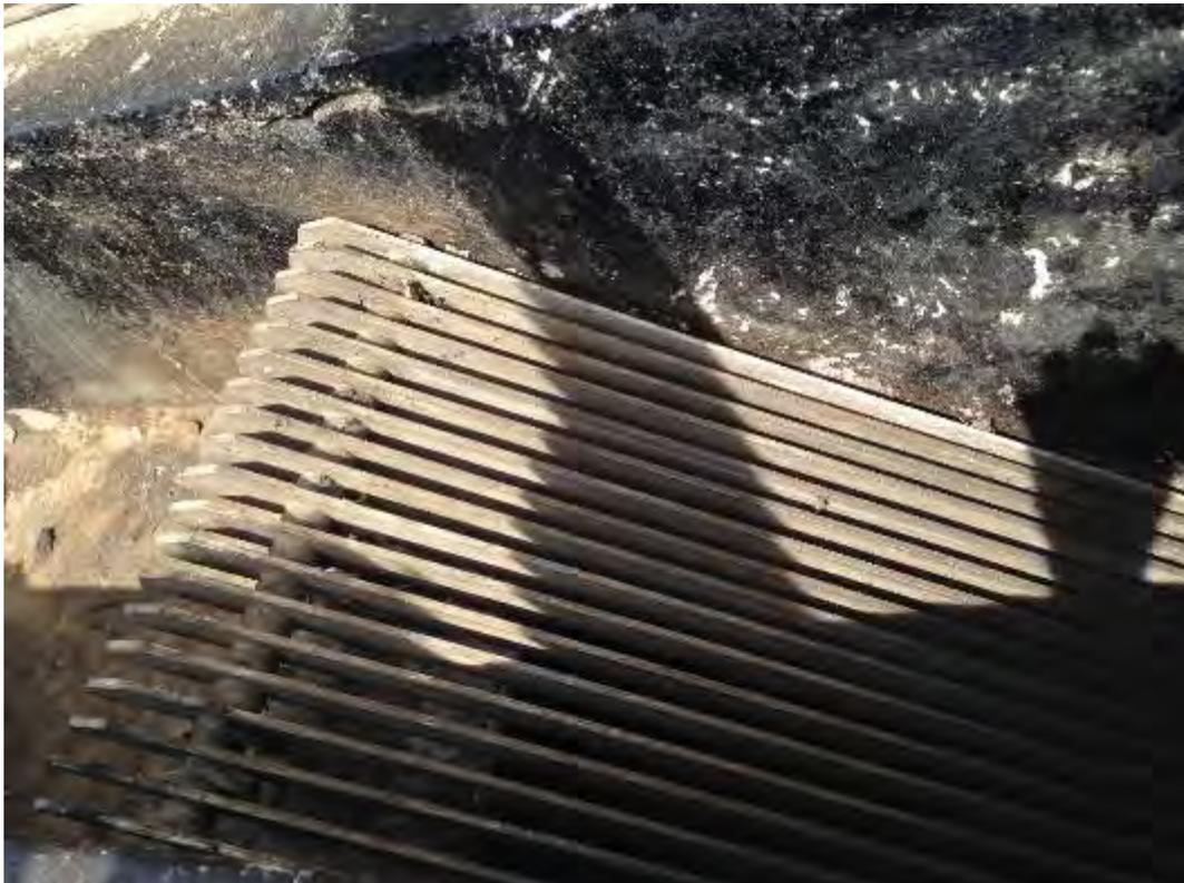
**Figura 30: Gradeamento do tratamento preliminar da ETE Bodoquena.**
