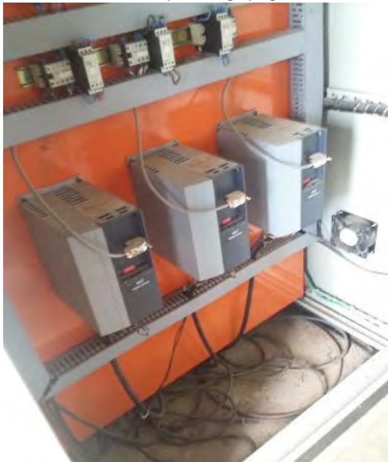
Figura 22: EEEB – 03 Final João Batista, inversores de frequência, em Bodoquena.
