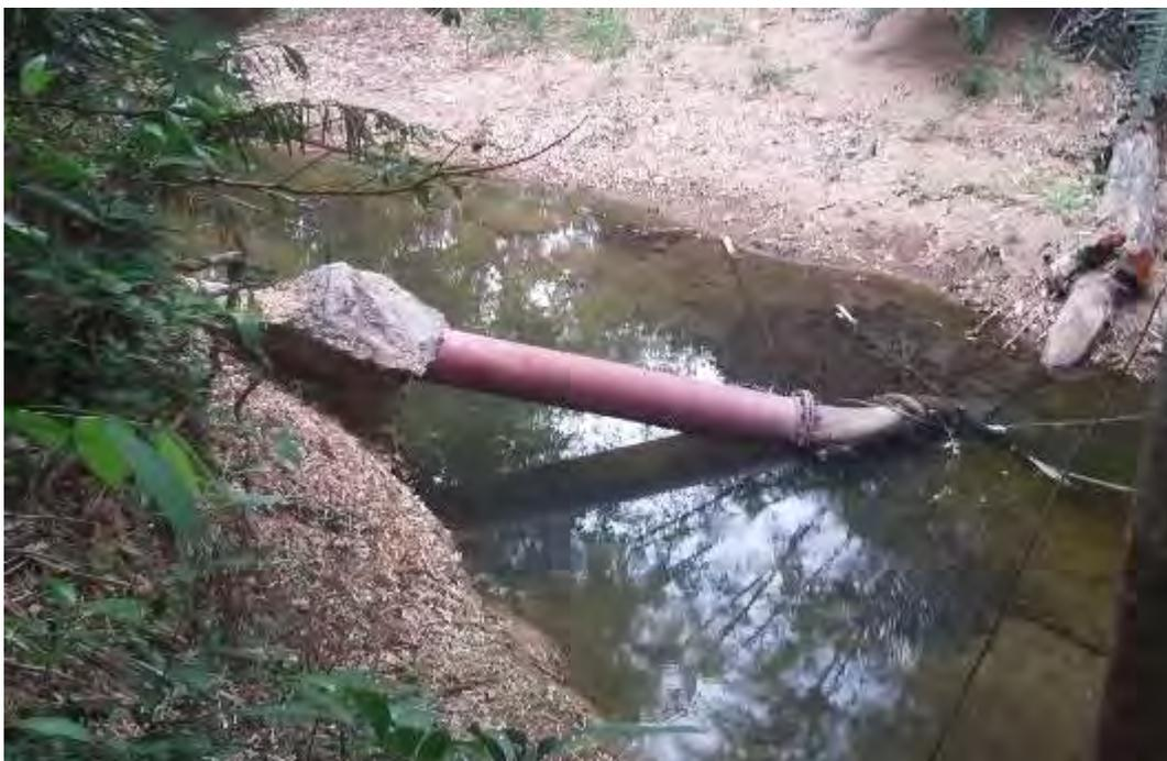
**Figura 42: Ponto de lançamento do efluente tratado no corpo receptor, em Bodoquena.**
