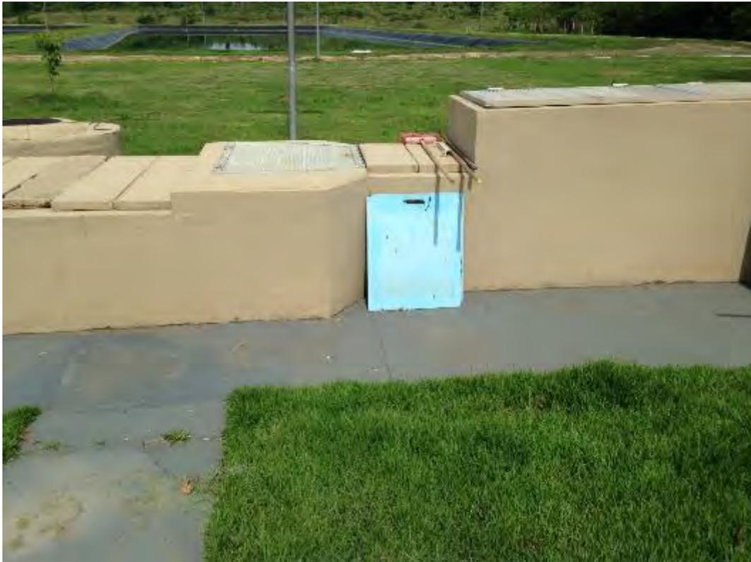
**Figura 29: Tratamento preliminar (gradeamento e desarenador) na ETE Bodoquena.**
