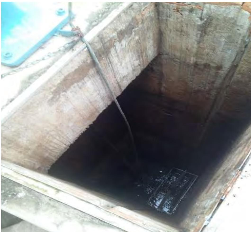
Figura 12: EEEB 01, poço de chegada e cesto retentor, em Bodoquena.
