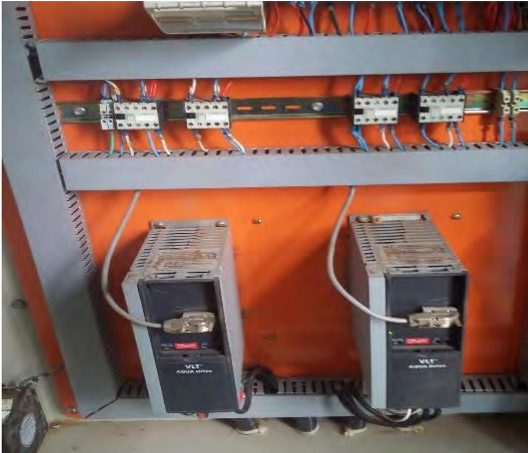
**Figura 15: EEEB 02 – Sol Nascente, inversores de frequência em Bodoquena.**
