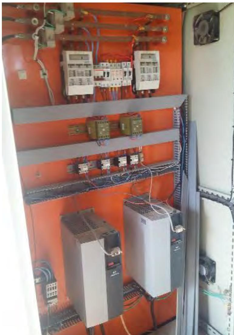
**Figura 28: EEET – Inversores de frequência existentes em Bodoquena.**
