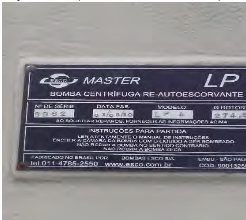
Figura 26: EEET –placa da bomba, LP-04, em Bodoquena.
