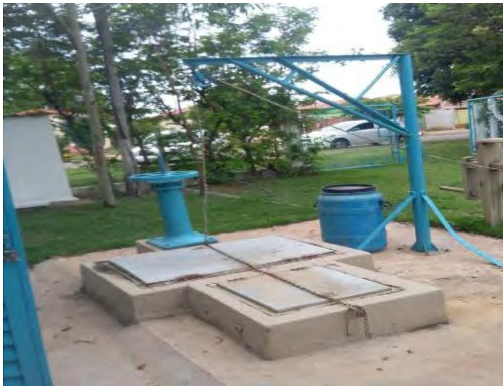
**Figura 10: EEEB – 01, poço de visita e monovia, em Bodoquena.**
