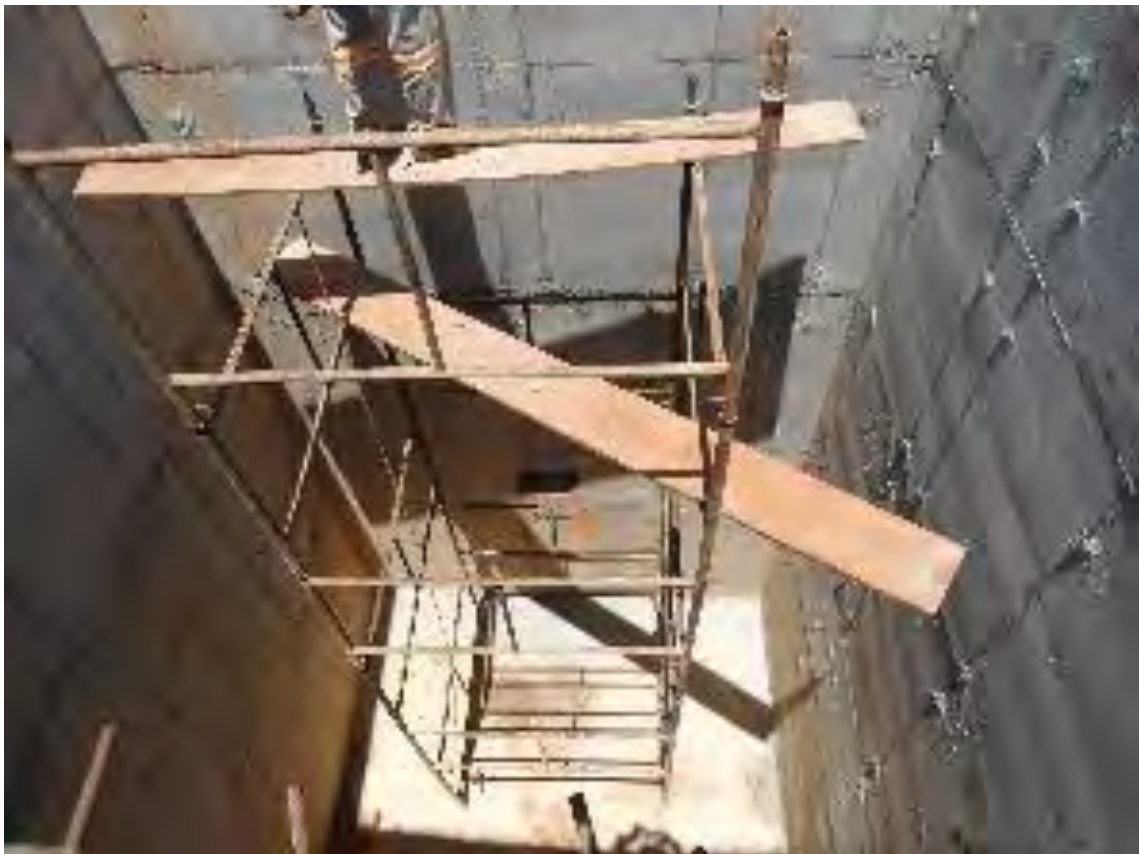
Figura 12: Obra da EEEB-002 Final de Batayporã.
