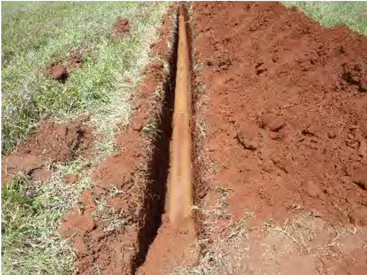
Figura 14: Obra do emissário de esgoto bruto por gravidade de Batayporã.
