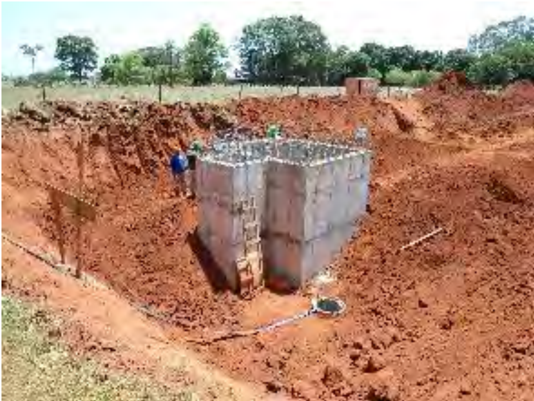
Figura 11: Obra da EEEB-002 Final de Batayporã.
