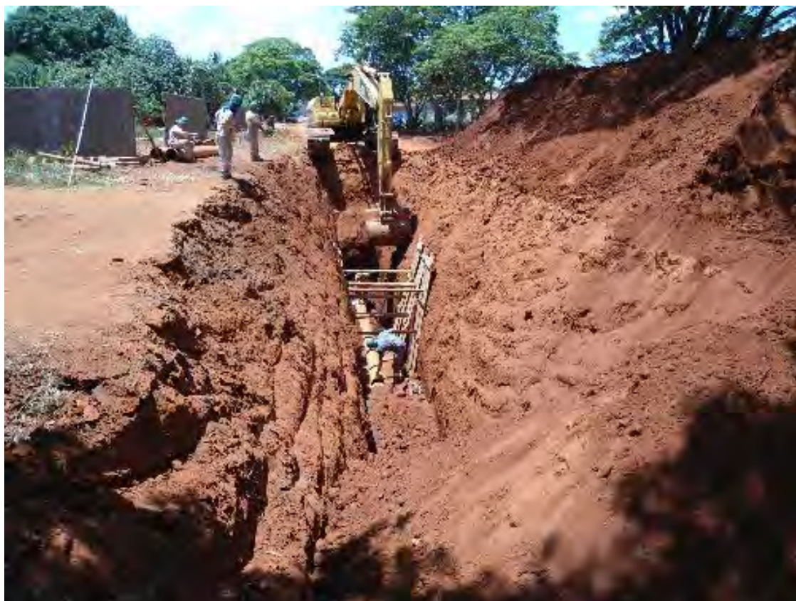
Figura 13: Obra da Linha de recalque da EEEB-002 Final de Batayporã.
