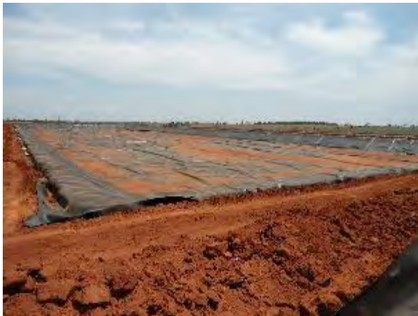
Figura 19: Vista da lagoa facultativa da ETE Batayporã em construção.
