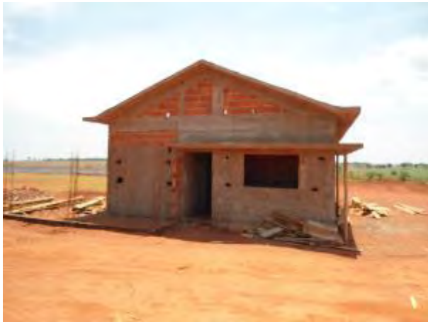
Figura 17: Vista 1 do laboratório da ETE Batayporã em construção.
