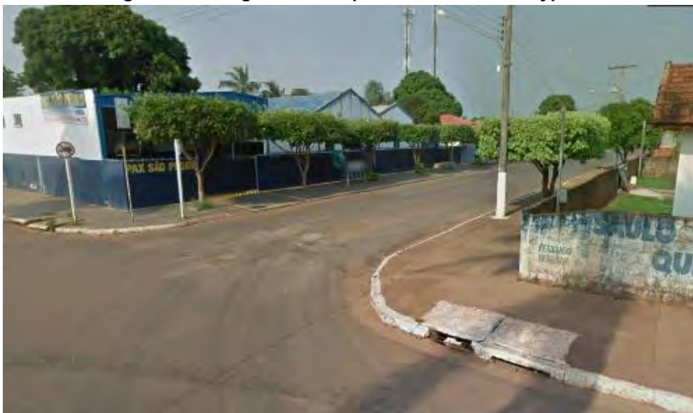
Figura 3: Vista da rua pavimentada com drenagem pluvial em Batayporã.
