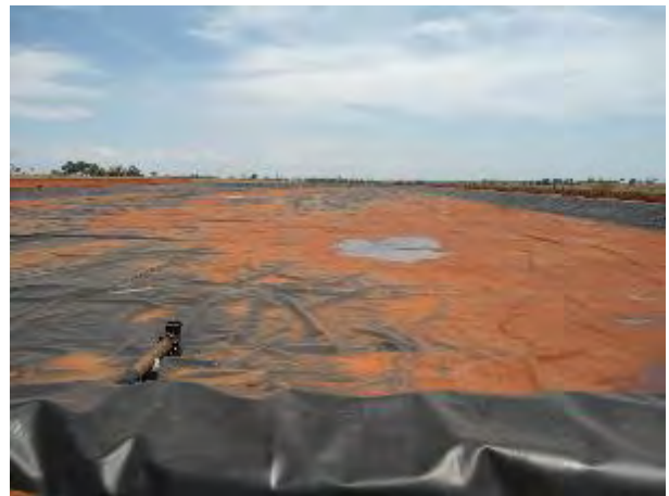
Figura 20: Lagoa de maturação da ETE Batayporã em construção.
