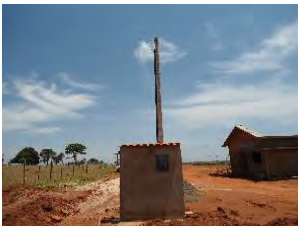
Figura 15: Entrada de energia na ETE Batayporã.
