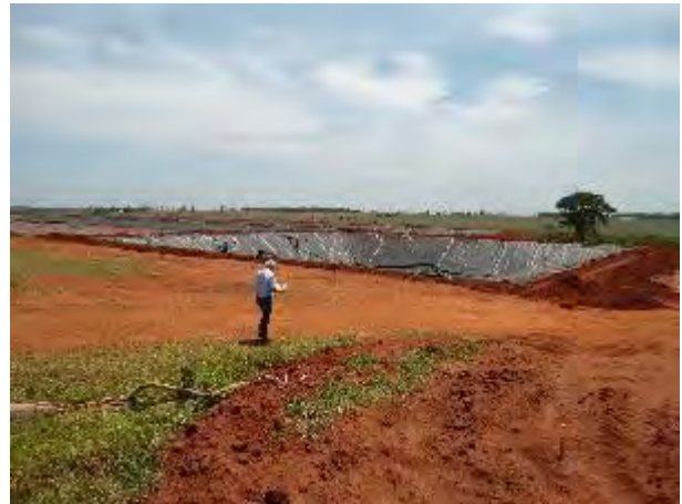
Figura 18: Obra da lagoa anaeróbia da ETE Batayporã.
