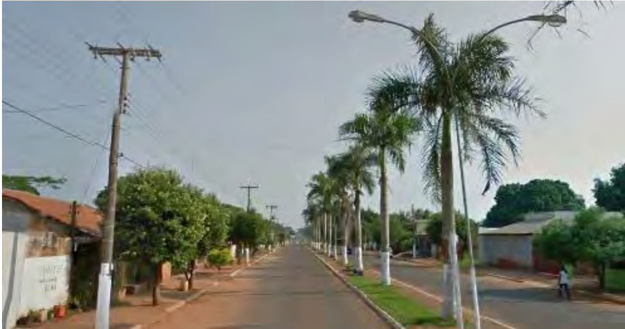
Figura 2: Vista geral da rua pavimentada de Batayporã.
