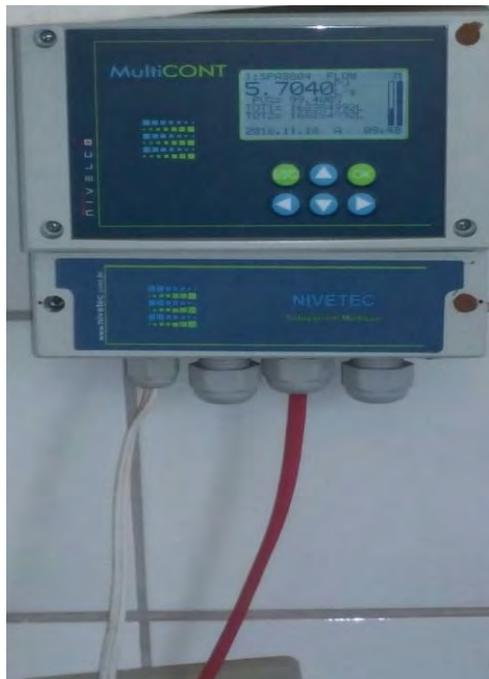
**Figura 10: Medidor de vazão NIVETEC da ETE Bataguassu.**
