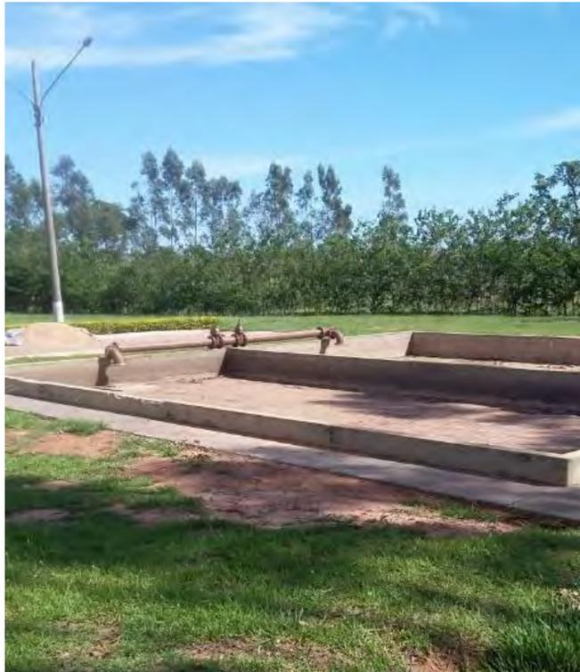
**Figura 15: Vista dos leitos de secagem.**
