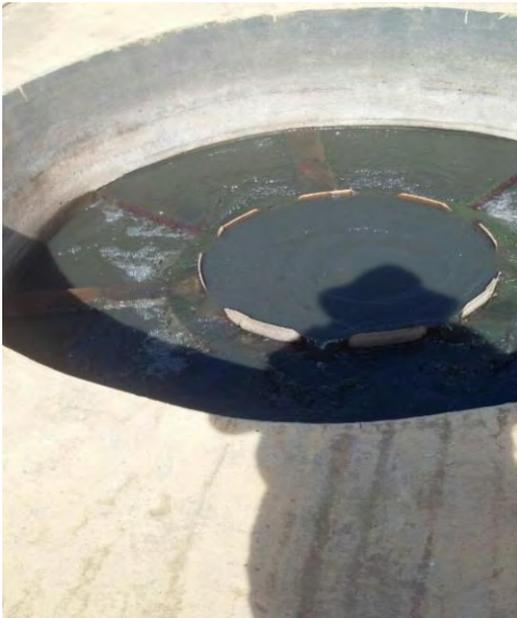
Figura 13: Vista do vertedor central do UASB ETE Bataguassu.
