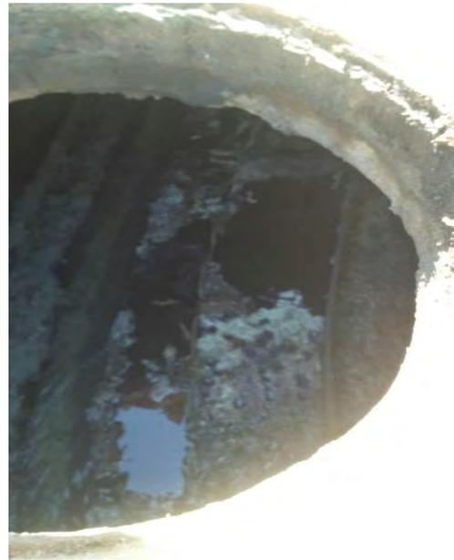
Figura 14: Vista do vertedor periférico do UASB ETE Bataguassu.
