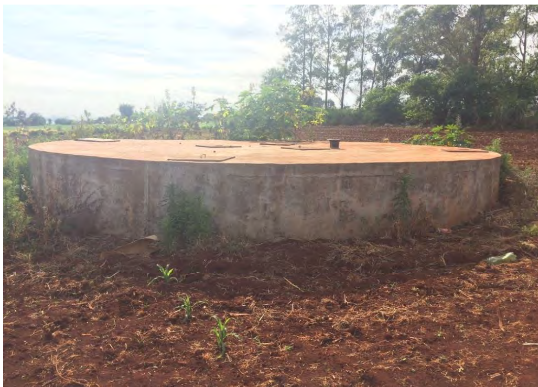
Figura 8: Reator Anaeróbio (UASB).
