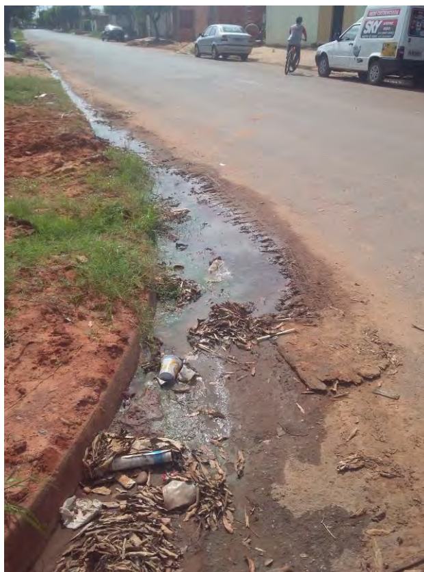
Esgoto a céu aberto próximo a Rua Maria Teixeira da Silva Água Clara/ MS.
