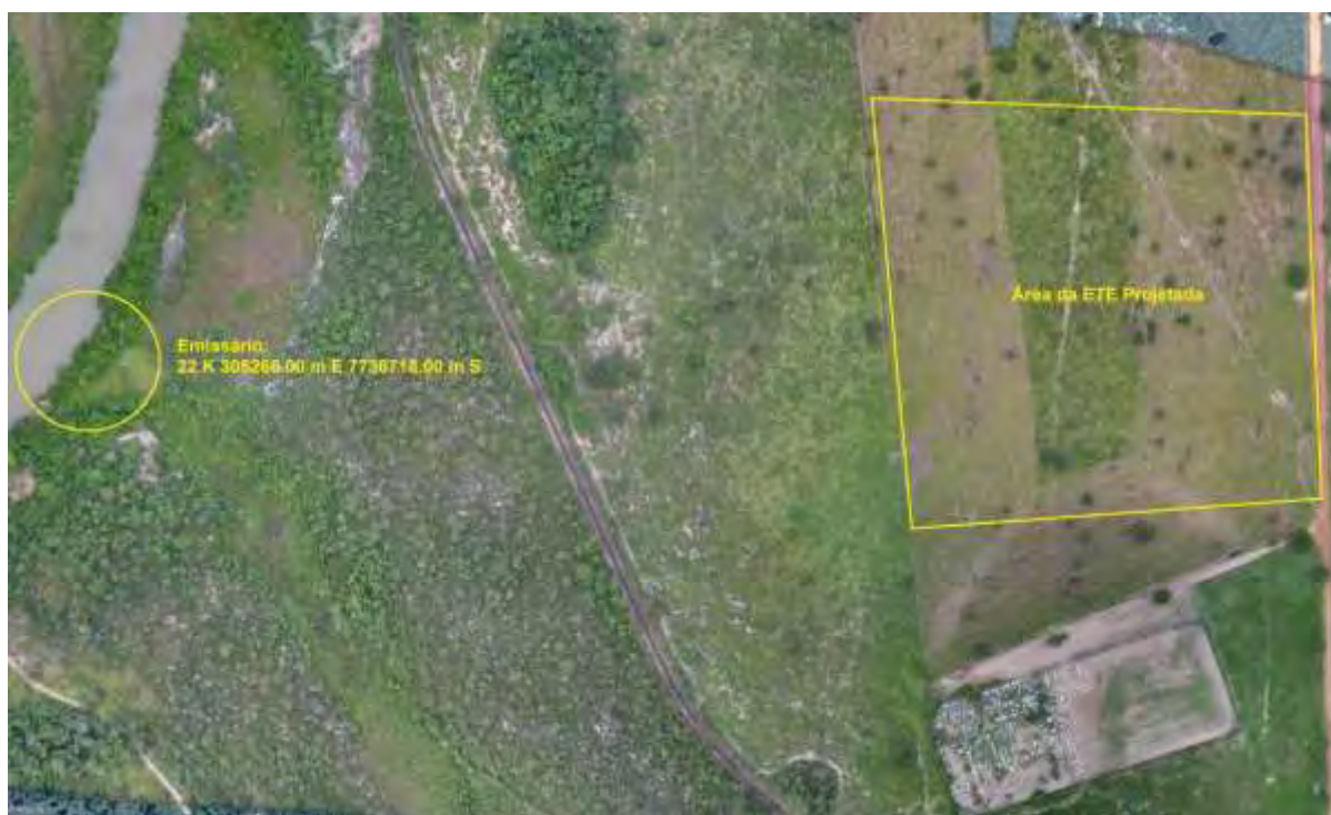
Figura 3: Vista da área pretendida para a ETE Água Clara Projetada e entorno, Água Clara, MS.
