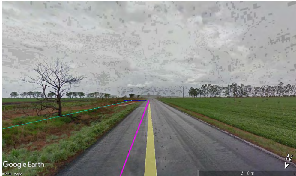
Figura 3.38 – Rodovia MS 306 – Localização Canteiro (02). Fonte: Adaptado de Google Earth.
