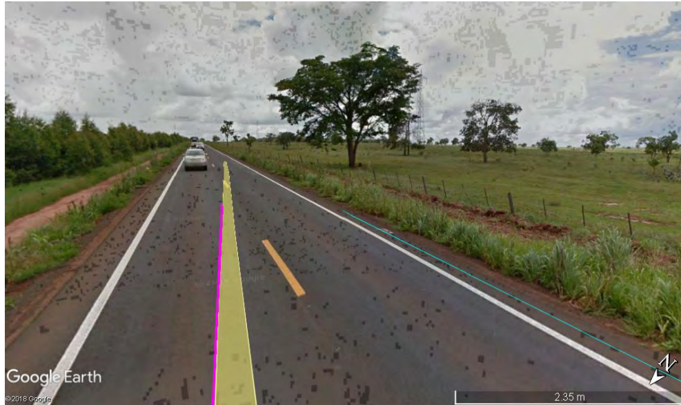
Figura 3.40 - Rodovia MS 306 – Localização Canteiro (03).
